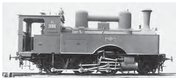
Bei der Maschinenfabrik Esslingen entstanden die württembergischen Fz, die von der Reichsbahn als 97.3 eingereiht wurden. Sie dienten als Reserve am Alaufstieg und im planmäßigen Einsatz im Schwarzwald, bis dort 1936 der Zahnradbetrieb aufgegeben wurde. (beide Bilder Archiv Obermeyer)
