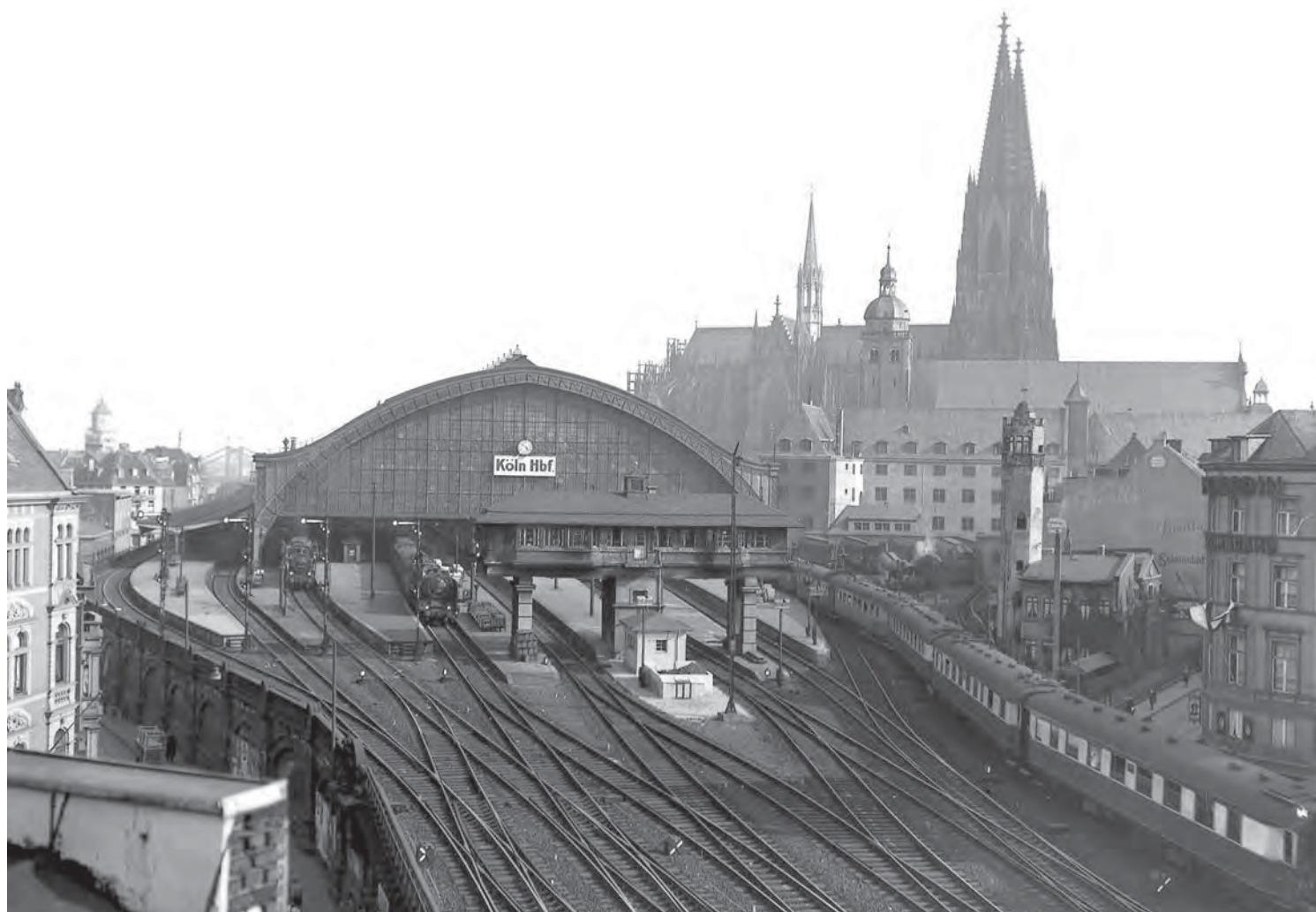
Besonders steile Weichen sind an beiden Bahnhofsköpfen in Köln verbaut. Die Ein- und Ausfahrten von Zügen erfolgen entsprechend langsam. Foto: Sammlung Gerhard/EJ
