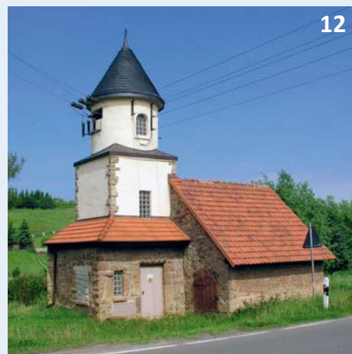
Bild 13: In Neubulach-Martinsmoos im Landkreis Calw in Baden-Württemberg steht diese Turmstation in landestypischer Bauweise. Sie ist auch ein Beispiel für die Langlebigkeit alter Turmstationen: Im Jahr 1910 gebaut, versorgt sie ihre Umgebung auch noch 100 Jahre später mit Strom. FOTO: ILLO-FRANK PRIMUS
