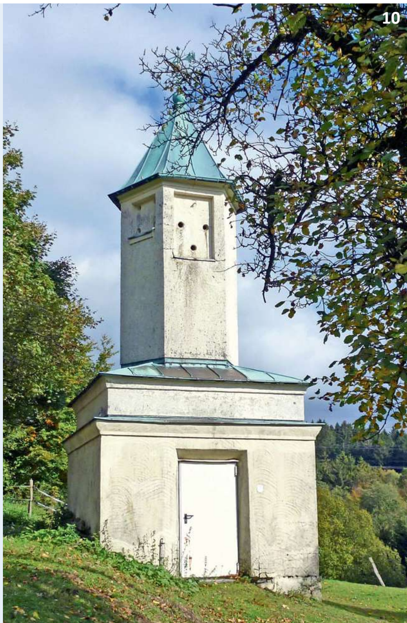
Bild 13: In Neubulach-Martinsmoos im Landkreis Calw in Baden-Württemberg steht diese Turmstation in landestypischer Bauweise. Sie ist auch ein Beispiel für die Langlebigkeit alter Turmstationen: Im Jahr 1910 gebaut, versorgt sie ihre Umgebung auch noch 100 Jahre später mit Strom. FOTO: ILLO-FRANK PRIMUS
