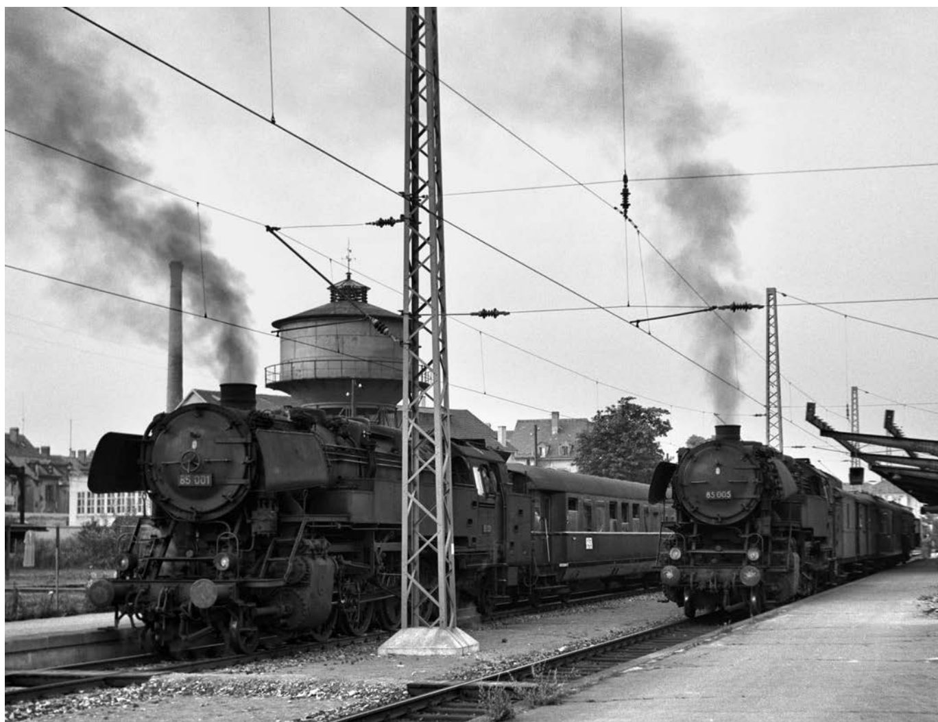
Am 3. August 1955 bieten in Freiburg Hbf die beiden Schwestern 85 001 mit E 613 und 85 005 mit P 1587 einen imposanten Anblick. Die neuen Oberleitungsmasten sind Teil der Elektrifizierung der Rheintalbahn Basel – Freiburg, sie künden aber auch bereits von der baldigen Umstellung der Höllentalbahn auf 16 2/3 Hertz und dem durchgehend elektrischen Zugbetrieb. FOTO: ULRICH MONTFORT
