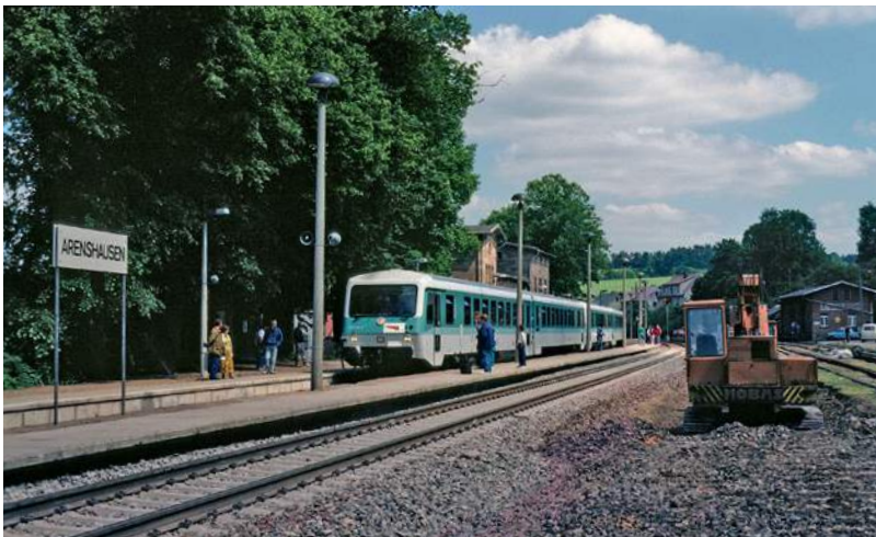
OBE: Bauarbeiten für den Lückenschluss bei Eichenberg (17.2.1990). LINKS: Am 26. Mai 1990 pendelten zwischen Arenshausen und Eichenberg Triebwagen der Baureihe 628.2. Foto: J. Hörstel
