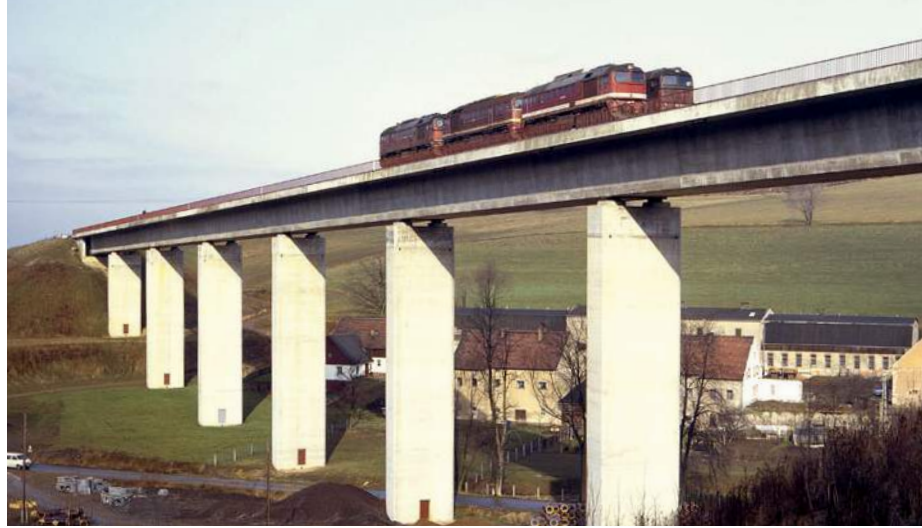
1992 wurde der Hetzdorfer Viadukt durch eine 2 km lange Neubaustrecke mit zwei Spannbetonbrücken ersetzt (Brückenbelastung mit Baureihe 220). Fotos: R. Heinrich (2)
