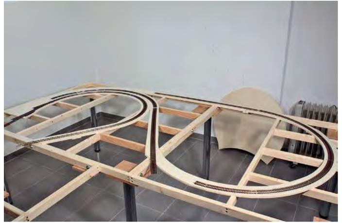
Auf der linken Seite sind die Trassen noch nicht befestigt, da sie später in einer Steigung oder einem erhöhten Niveau liegen werden. Die Trassenbretter werden mit kleinen Verbindungsbrettchen zusammenmontiert. Diese sind Reste vom Trassensägen.
