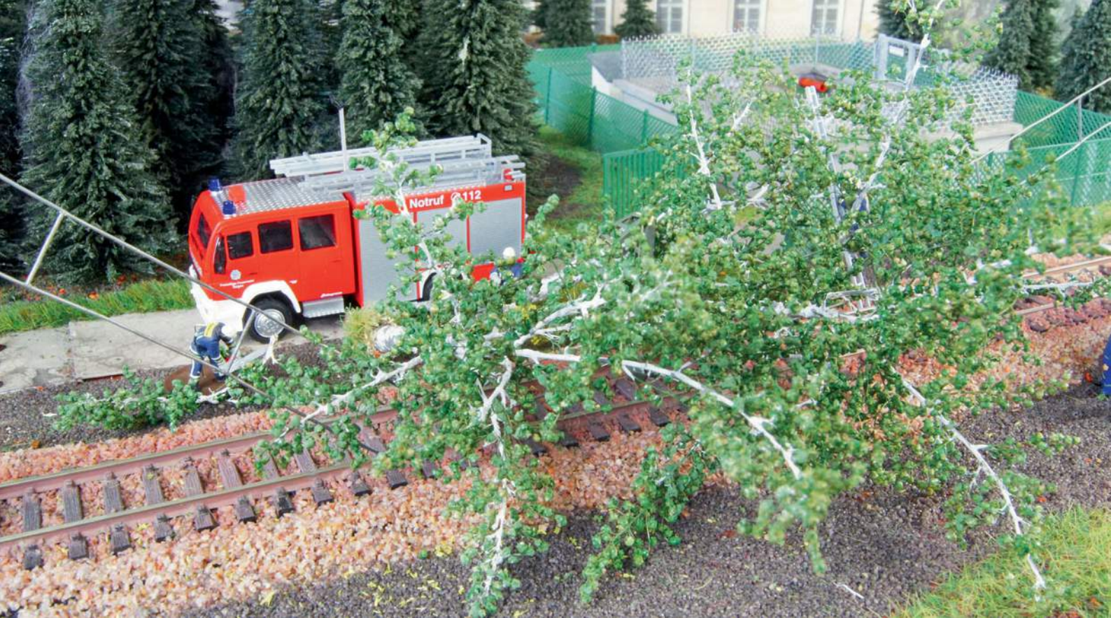
Schöne Bescherung: Eine Orkanböe hat mehrere Bäume an der Bahntrasse umgerissen. Auch die Oberleitung wurde beschädigt.
