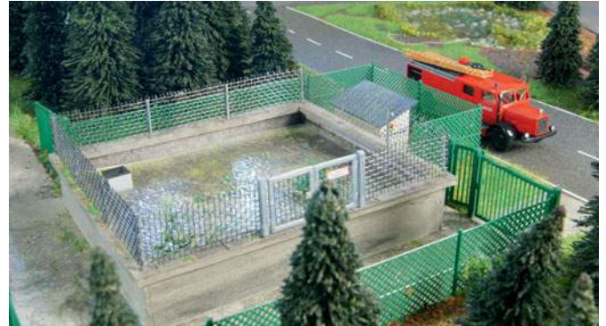
In Gegenden abseits der städtischen Wasserversorgung finden oftmals künstlich angelegte Löschwasserspeicher Verwendung (Busch 1079).
