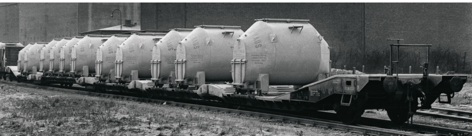
Probeverladung 1957: Elf pa-Behälter auf dem Versuchsfahrzeug 5 BTfs 57 für den Huckepackverkehr.
