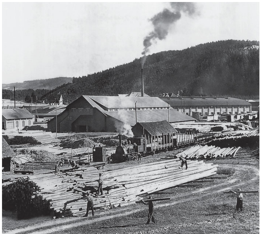
Oben: In Eltville werden in den 1930er-Jahren Holzschwellen von Hand auf einen offenen Güterwagen verladen.
