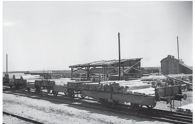
In einem Schwellenwerk dienen alte Flachwagen dem werksinternen Verkehr.
