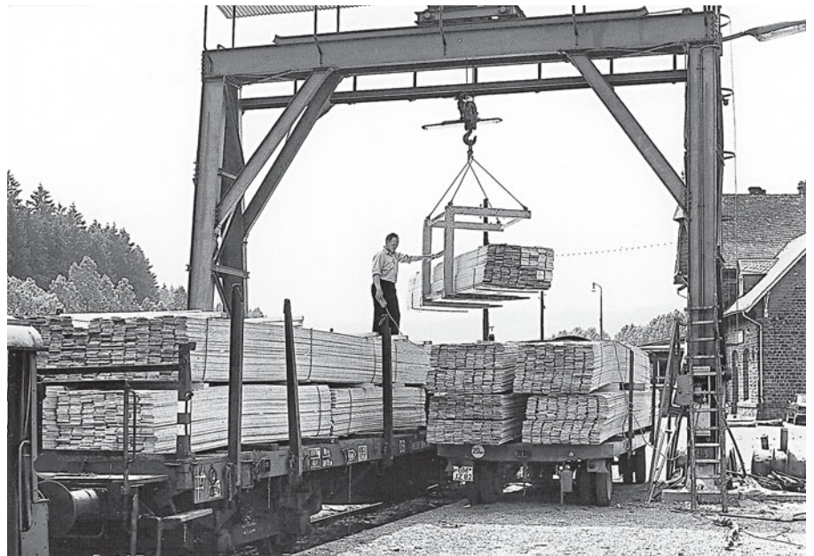
Ab Mitte der 1960er-Jahre erfolgt der Holzumschlag vom Lkw(-Anhänger) auf die Bahn in der Regel per Überladekran. FOTO: HELMUT SÄUBERLICH
