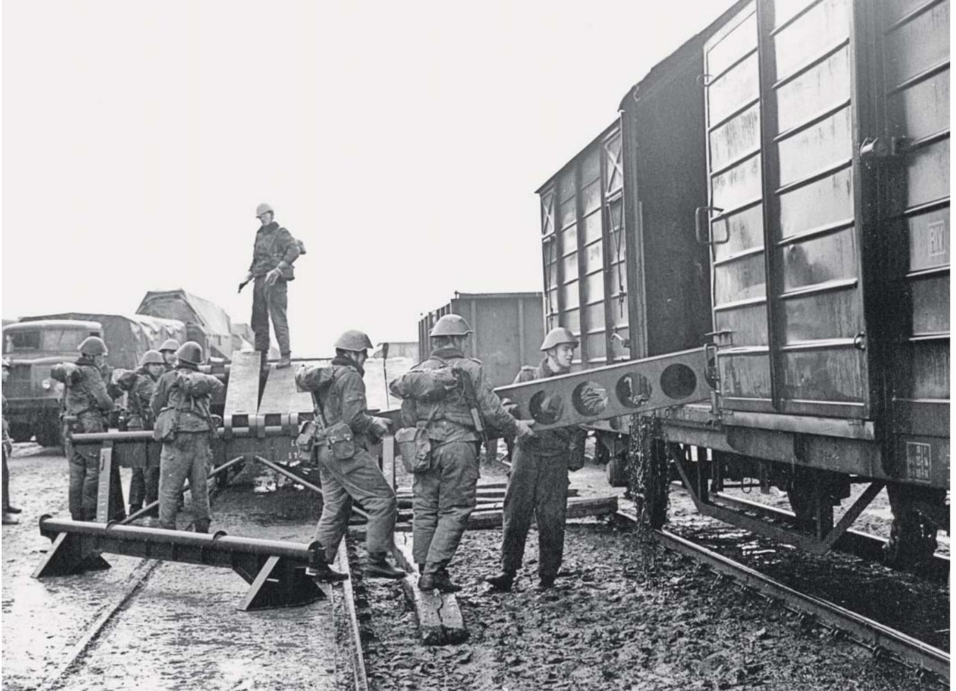
Verladeübung einer Einheit der Luftstreitkräfte/Luftverteidigung mit ZLR 60/1 am 8. Februar 1982. Die ZLR wurden oft in Gbs- oder anderen G- bzw. H-Wagen eingelagert und zum Einsatzort befördert. Hier wird eine ZLR zum Aufbau entladen. FOTO: MILITÄRHISTORISCHES MUSEUM DER BUNDESWEHR
