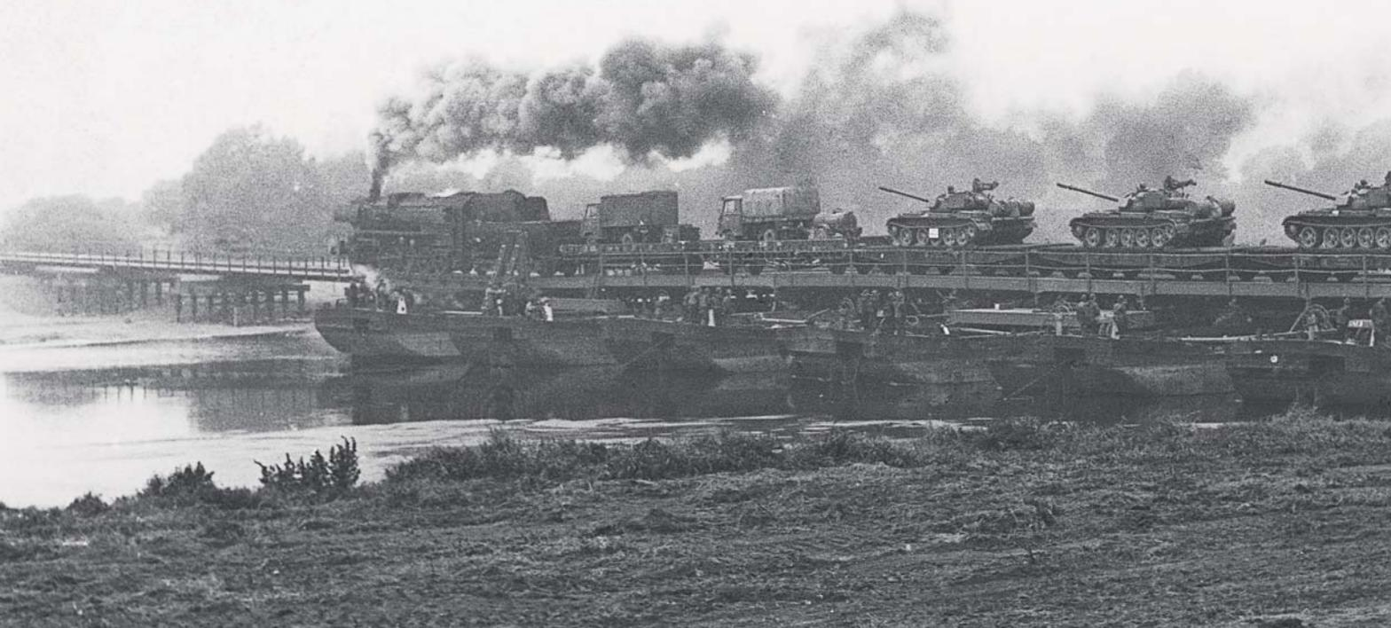
■ Flussüberquerung eines Truppentransports auf einer kombinierten Schwimmbücke. An der Spitze eine Lok der Baureihe 52. FOTO: SLG, HARALD GRAFE
