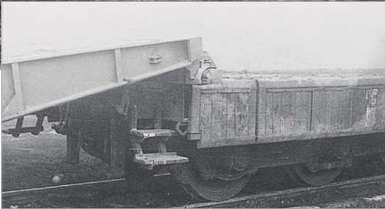
■ Begleitbrücke TMM als Behelfskopframpe auf einem Samm. Eine Befahrung durch Panzer war so nicht möglich, da der Samm infolge der einseitigen Belastung aus dem Gleis gehoben worden wäre.
