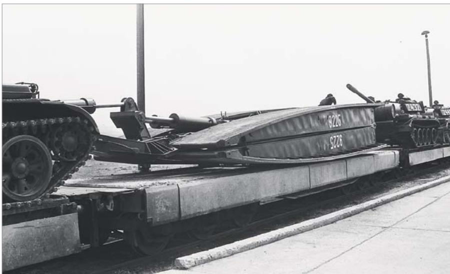
■ Abgebordeter Samm-Wagen, beladen mit Klappbrücke des Brückenlegepanzers BLG 60M2. Zur Befestigung dienen standardisierte Befestigungsbalken. FOTO: HARALD GRAFE
