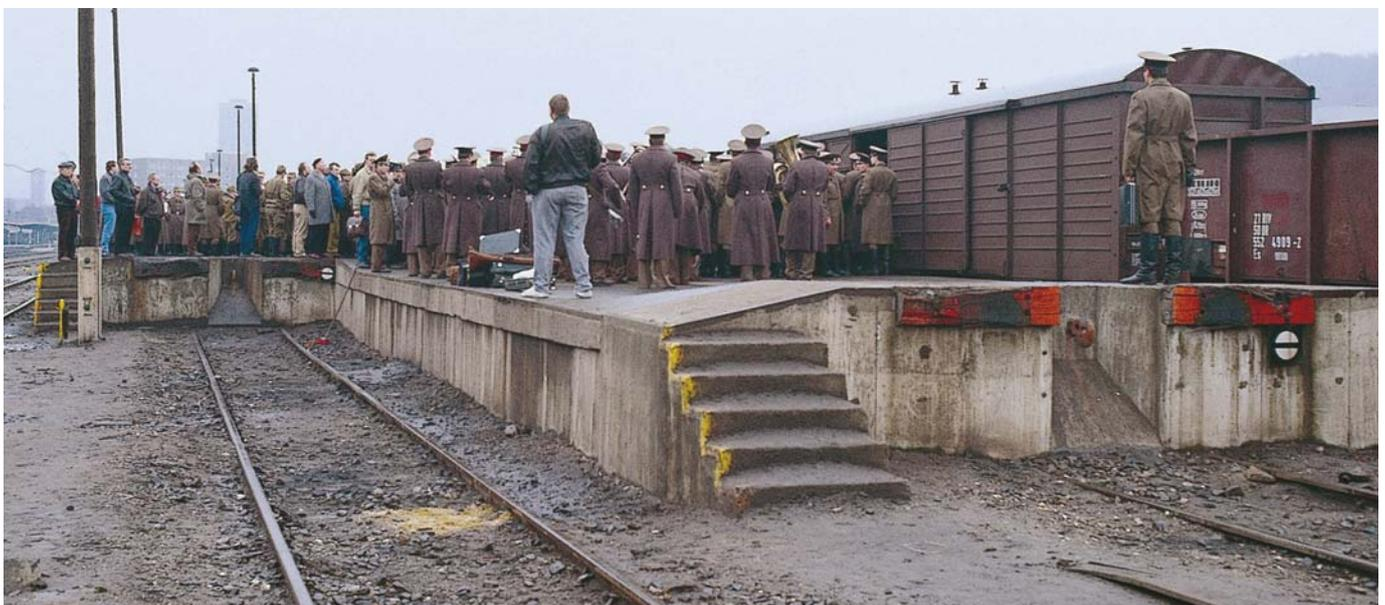
■ Kombirampe mit Zughaken in Jena Saalbahnhof. Deutlich sichtbar die Erhöhung der Rampe im Bereich der geteilten Pufferbohle. FOTO: HARALD GRAFE
