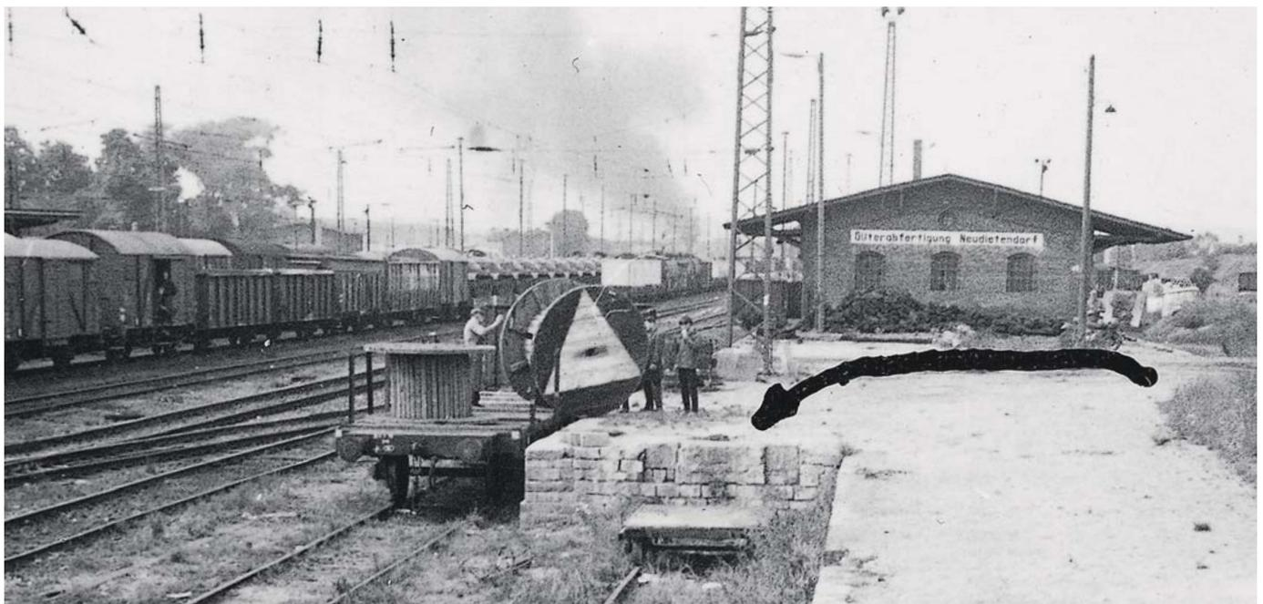
■ Beispiel für eine beschädigte Kombirampe in Neudietendorf bei Erfurt (um 1970). Zusätzlich zum desolaten Zustand der gemauerten Kanten fehlt die Pufferbohle. Im Hintergrund ein Truppentransport mit einer Dampflokomotive an der Spitze.
