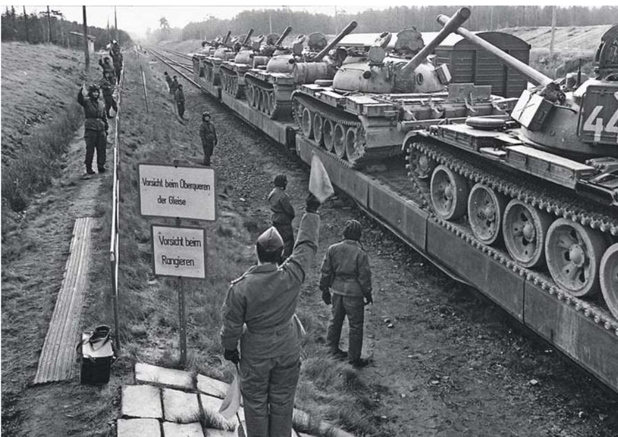
gung von Kettenfahrzeugen wurden meist zwei Holzbalken je Fahrzeug mit den Maßen 15 cm x 15 cm x 2,7 m (je nach Breite des Kettenfahrzeugs bis zu 3,05 m) verwendet. Diese Balken waren jeweils mit mindestens vier Bauklammern am Wagenboden zu befestigen. Auch diese Balken mussten so angebracht werden, dass sie unmittelbar an den Ketten anlagen.
