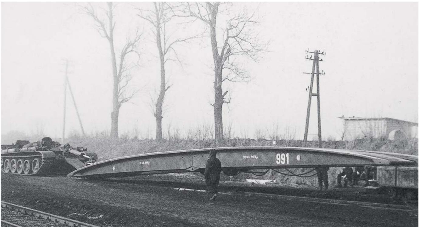
■ Es gab auch Versuche, Pioniertechnik als Behelfskopframpen einzusetzen. Hier ein Versuch mit einem Brückenlegegerät BLG.
