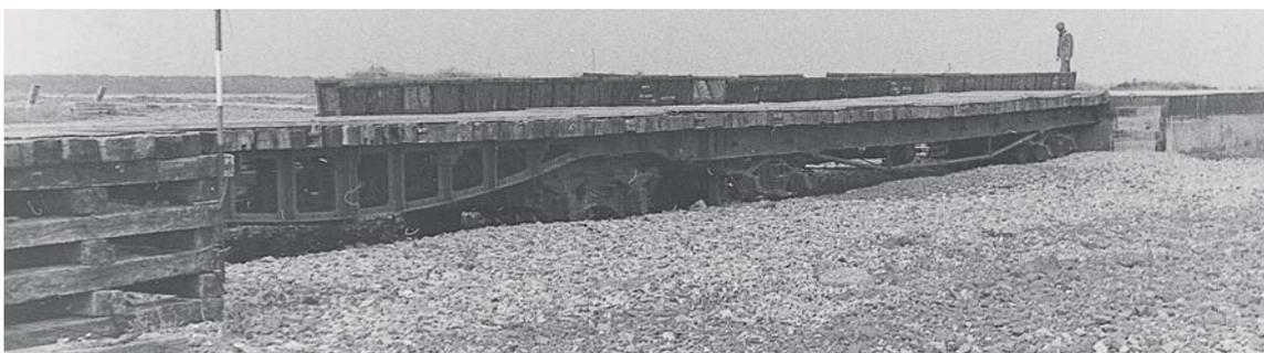
■ Stationäre Rampe für Verladeübungen mit Kopf- und Seitenrampe aus Beton und behelfsmäßiger Schwellenrampe.
