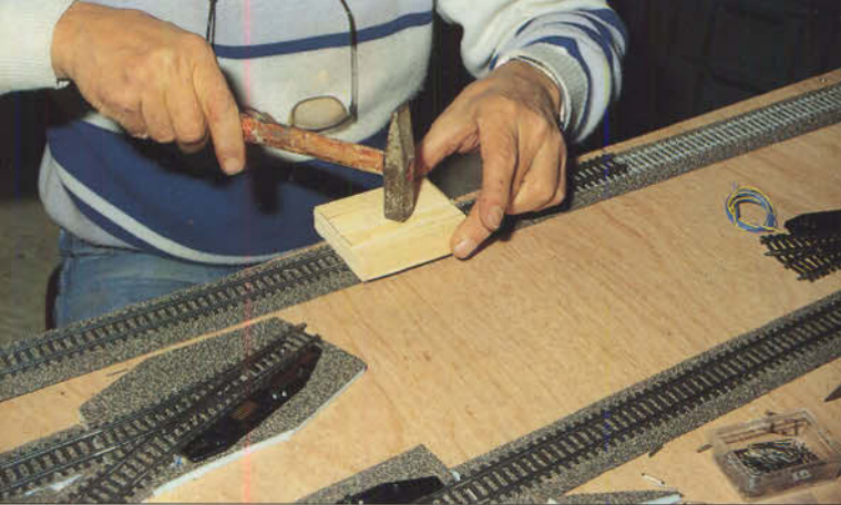
Bild 4: Nach dem Eindrücken des Gleises in die Merkur-Bettungskörper wird das Gleis mittels Hammer und Holzbrettchen nachgeklopft.
