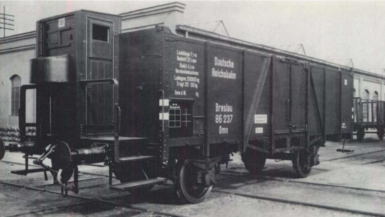
Bild 9: Der Omn Breslau 86237 sieht aus wie ein Wagen der Austauschbauart, Ablieferungsdatum (1.10.1923) und Gattungsbezirk weisen ihn aber noch eindeutig als Verbandsgüterwagen aus. Der Wagenkasten ist mit seinem Obergurt, den Schrägstreben und dem außenliegenden Sprengwerk schon weitgehend identisch mit der Austauschbauart, Gattungsbezirk Königsberg, aber z.B. die Puffer entsprechen noch der Verbandsbauart. Werkfoto MAN, Slg. Diener
