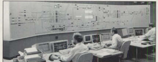
Hier herrscht inzwischen schon Betrieb: Ende September ging die 700-Millionen-Mark-Anlage, der Rangierbahnhof München Nord, in Betrieb. "Gehirn" der Anlage ist der Fahrplandienstleiterraum mit Meldetafel und Fahrplandienstleiterarbeitsplätzen (hier während der Abnahme). Vom "Panorama-Vorbau" des Stellwerkes aus überwachen Bergmeister die Vorgänge am Ablaufberg. In dem flachen Gebäude ist die Werkstatt untergebracht. Fotos: R.R. Rossberg
