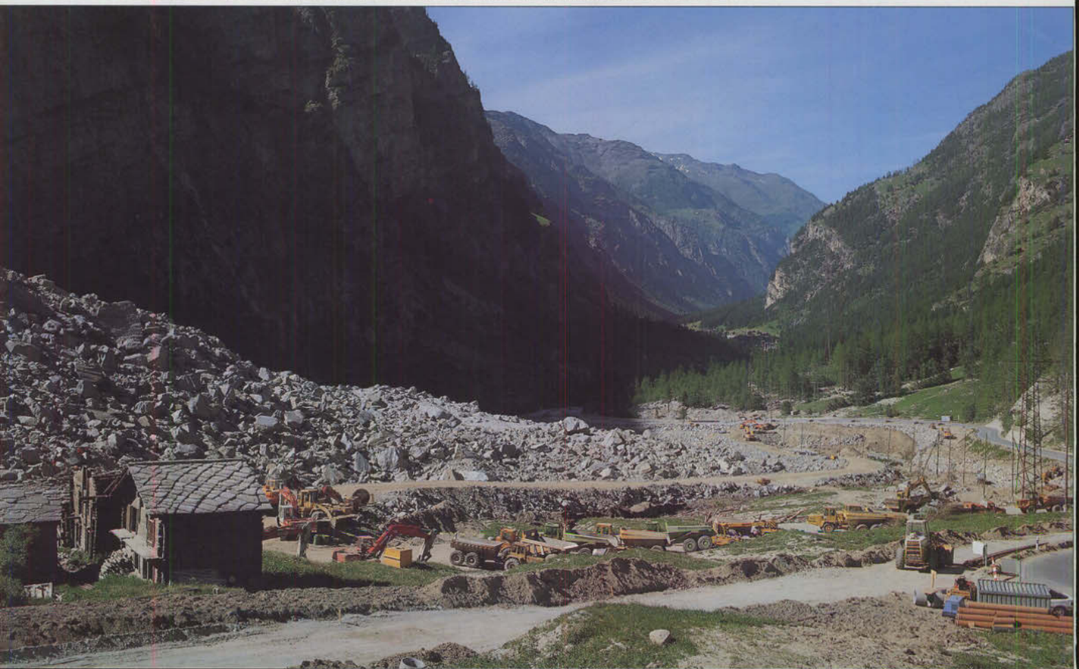
Bild 6: Die Gesteinsmassen haben den Weiler Lärch und die Bahnlinie der BVZ in diesem Abschnitt unterhalb von Randa verschüttet. Die Kosten für den schnellstens eingeleiteten Bau der Umgehungsstrecke beliefen sich auf rund 10 Millionen sfr. Foto: K. Fader
