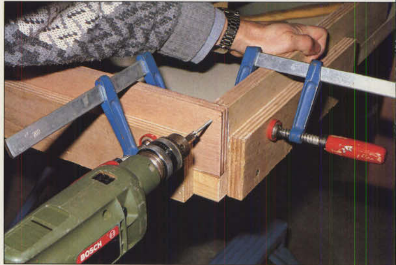
Bild 8: Mit Schraubzwingen müssen die verleimten Teile fixiert, anschließend verschraubt ...
