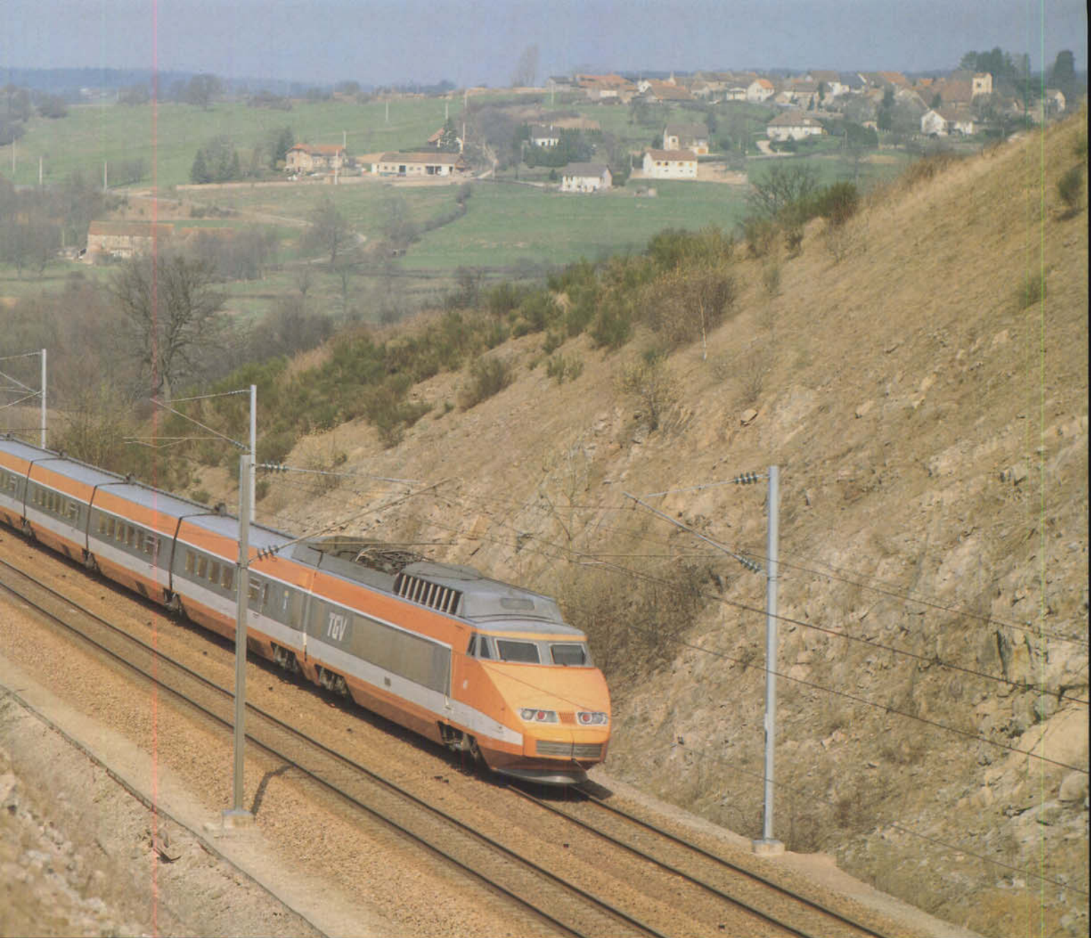
Bild 1: Da die französischen Neubaustrecken nur von den TGV-Zügen befahren werden, waren Steigungen bis zu 35‰ möglich (Paris – Lyon), Aufnahme bei St.-Pierre-de-Varennes). Am 20. März 1989 jagt der R (= Rapide) 865/815 mit dem bei der Talfahrt gewonnenen Schwung über die nächste Kuppe.
