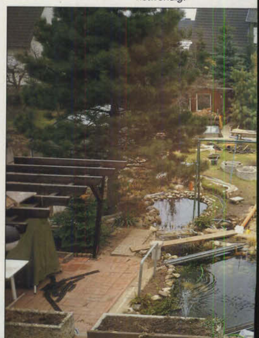
Bild 10 (unten): Die Gartenbahn in der Aufbauphase. Eine Menge Erdarbeiten waren für die unterirdische Verlegung der Kabel notwendig.
