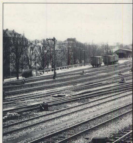
Bild 4: Die Nordseite des Bahnhofs Coburg 1940.
