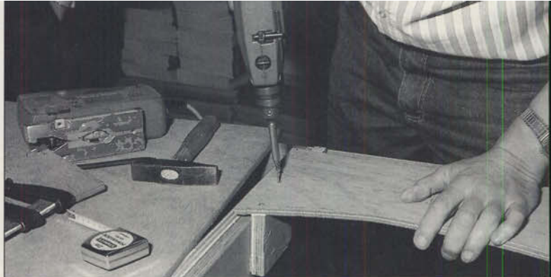
Bild 21: Die Trassenbretter werden mit dem Unterbau verschraubt und zusätzlich verleimt.
