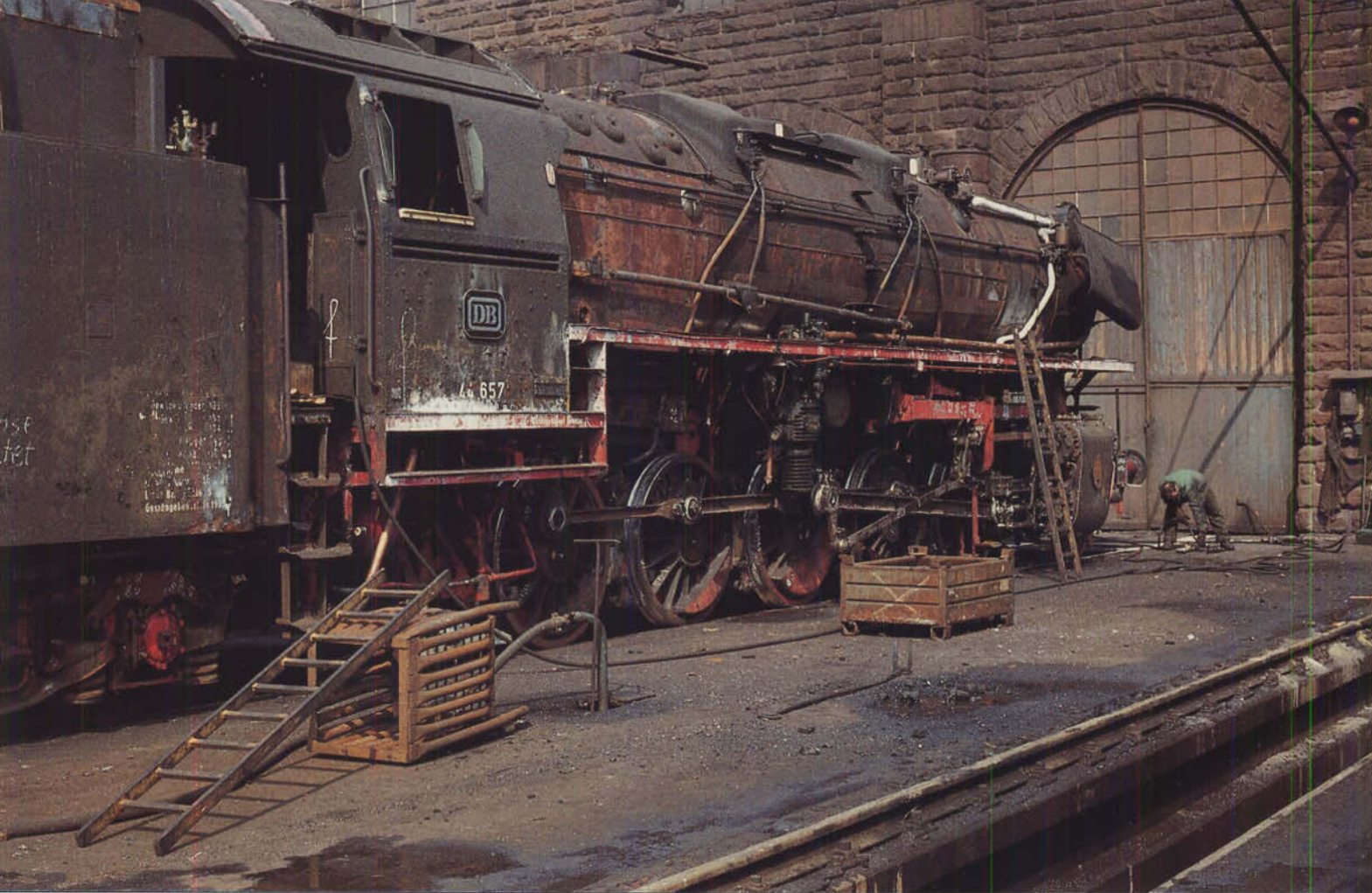
Bild 11: Im März 1971 waren die Halblengleise im AW Trier offensichtlich alle belegt, so daß an der 044 657 unter freiem Himmel gearbeitet werden mußte. Foto: Th. Horn
