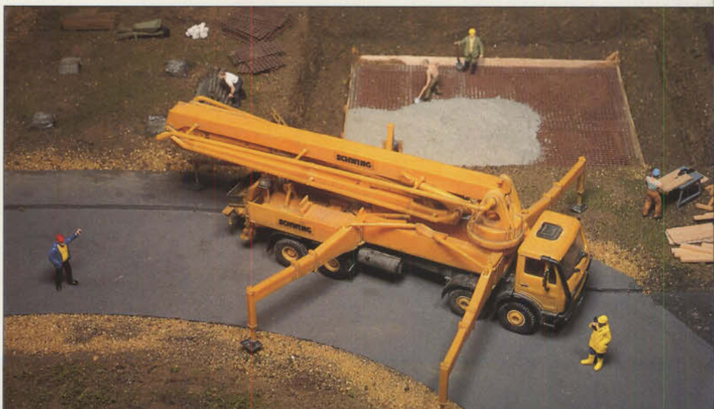
Bild 16: Eine Schwing-Betonpumpe wird zum Einsatz vorbereitet; sie soll Beton in die Baugrube befördern.
