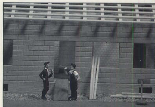
Bild 19: Die Zimmerleute beratschlagen ihr weiteres Vorgehen beim Errichten des Dachstuhls.
