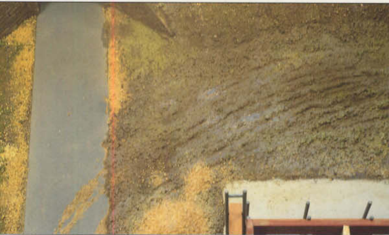
Bild 8: Die Baustellenfahrzeuge haben tiefe Spuren hinterlassen.
