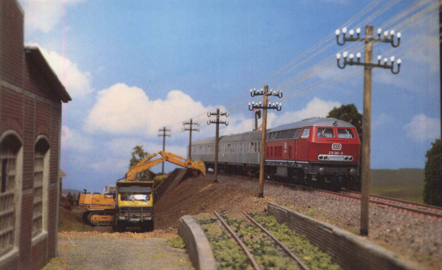
Bild 3: Ein großer Teil des alten Anschlußgleises mit dem Bahndamm zum Hauptgleis ist der Baggerschaufel schon "zum Opfer gefallen".
