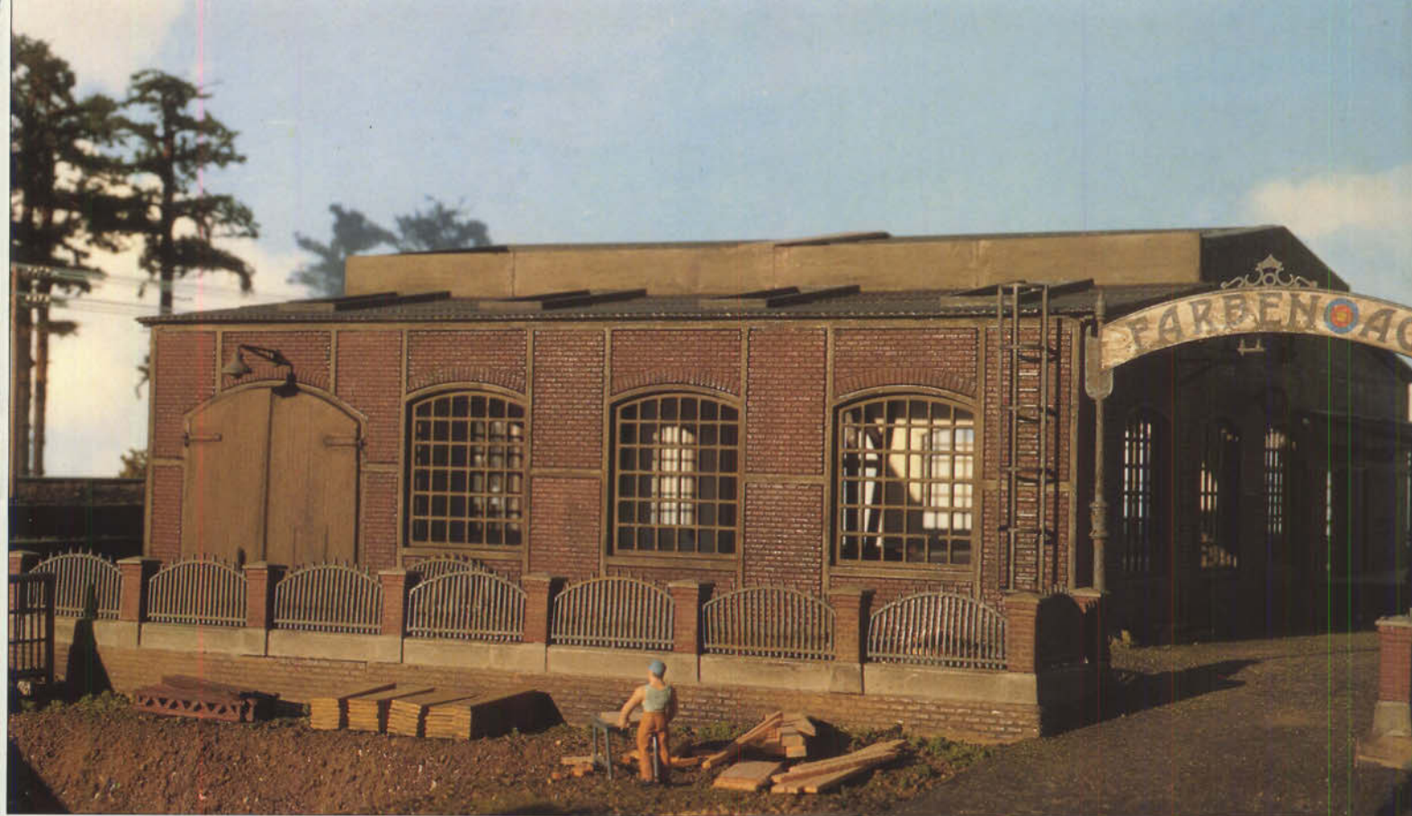
Bild 22: Eine Gesamtansicht der zum Abriß bestimmten Fabrik. Das Firmenschild "Farben-AG" über dem Tor kündigt vom einstigen Bestimmungszweck.
