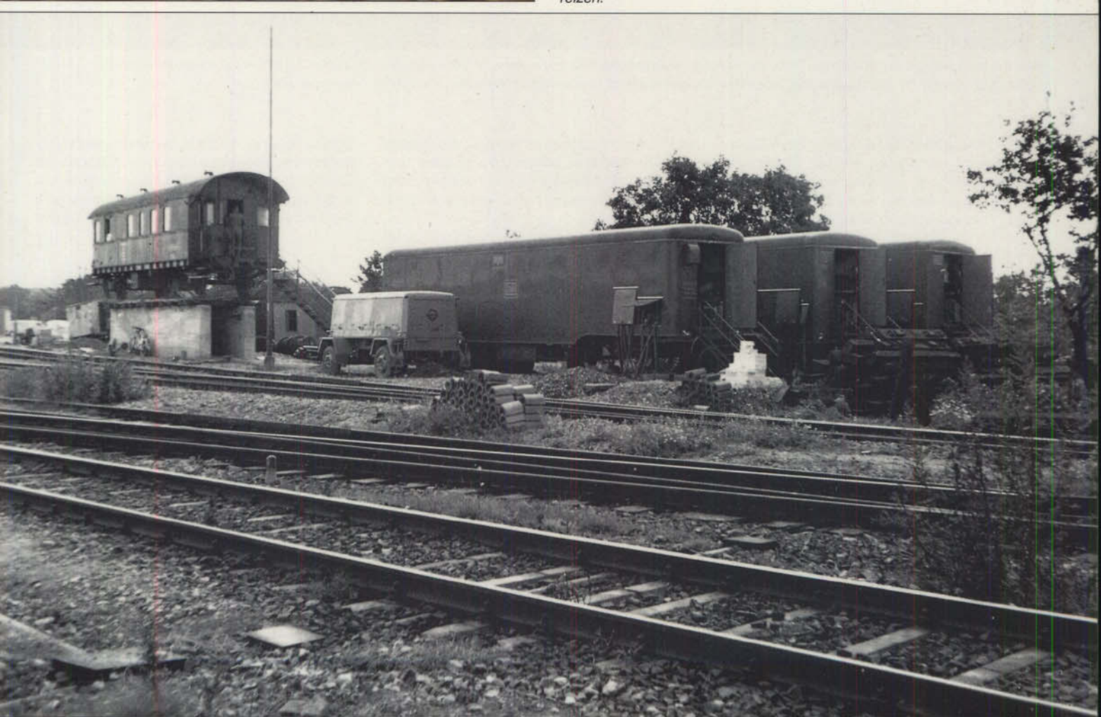
Bild 6: Daß das Stellwerk nicht nur aus einem alten Wagen auf einem Sockel besteht, zeigt die Aufnahme von der anderen Seite. Eine Menge Elektrotechnik wurde "investiert". Auch diese komplexe Gesamtsituation könnte zum Nachbau reizen.
