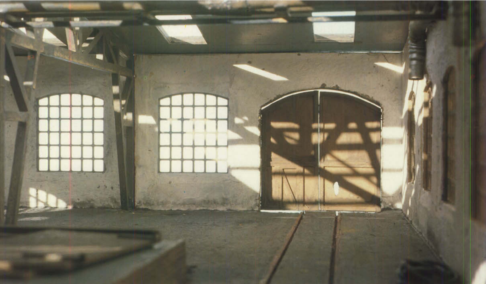
Bild 20: Vorbei sind die Tage reger Betriebsamkeit. Von allen Einrichtungen befreit erwartet die Halle der baldige Abriß.
