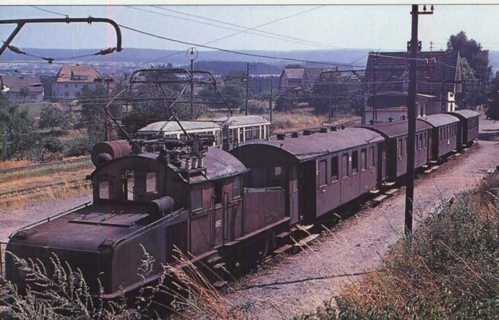
Bild 2: Bahnhof Ittersbach im Jahre 1964. Der Personenzug wurde von einer AA-AA-Lok, Baujahr 1911, hierhergebracht. Dahinter gerade noch zu erkennen sind zwei Beiwagen der Kleinbahn Ittersbach – Pforzheim.
