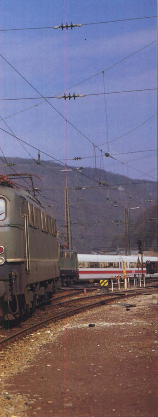
Bild 3: Auf den Neubaustrecken war eine große Anzahl von Kunstbauten erforderlich. Hier die 676 m lange Wälsebach-Talbrücke bei Kirchheim. Foto: Dr. Scheingraber
