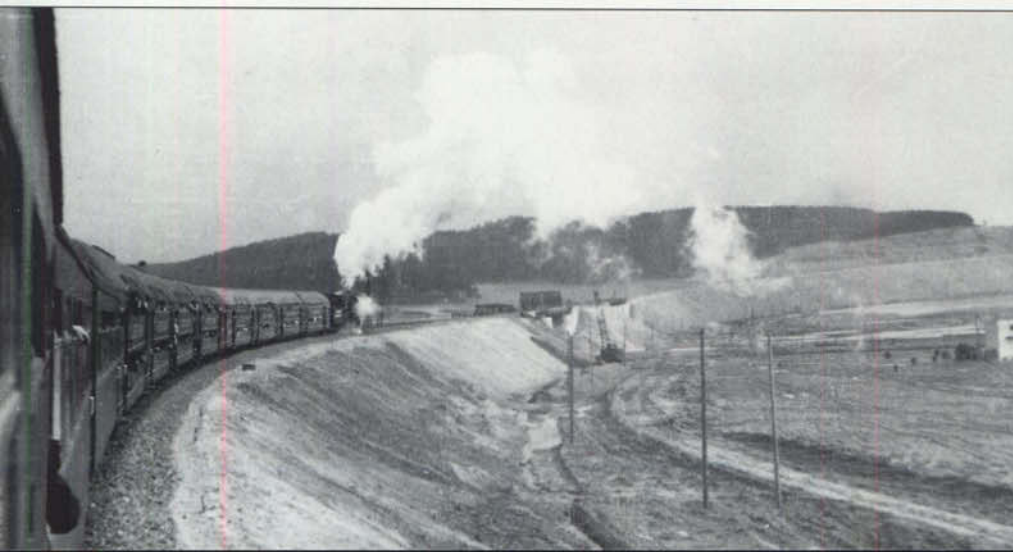
Bild 11: Dieses aus dem Eröffnungszug heraus geschossene Foto läßt erahnen, welche gewaltigen Erdbewegungen erforderlich waren, um die neue Strecke von Gerstungen über Dietrichsberg und Förtha nach Eisenach "aus dem Boden zu stampfen". Foto: Archiv Schunke
