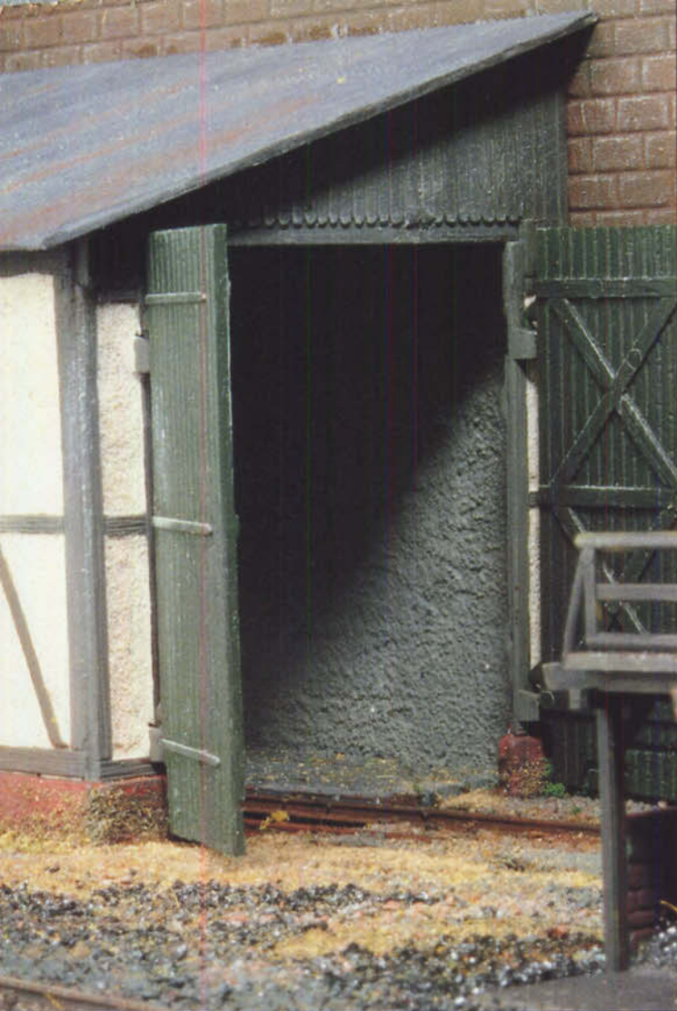
Bild 9: Gut sichtbar ist hier der Verputz der Innenwand, der dunkelgrau eingefärbt wurde.
