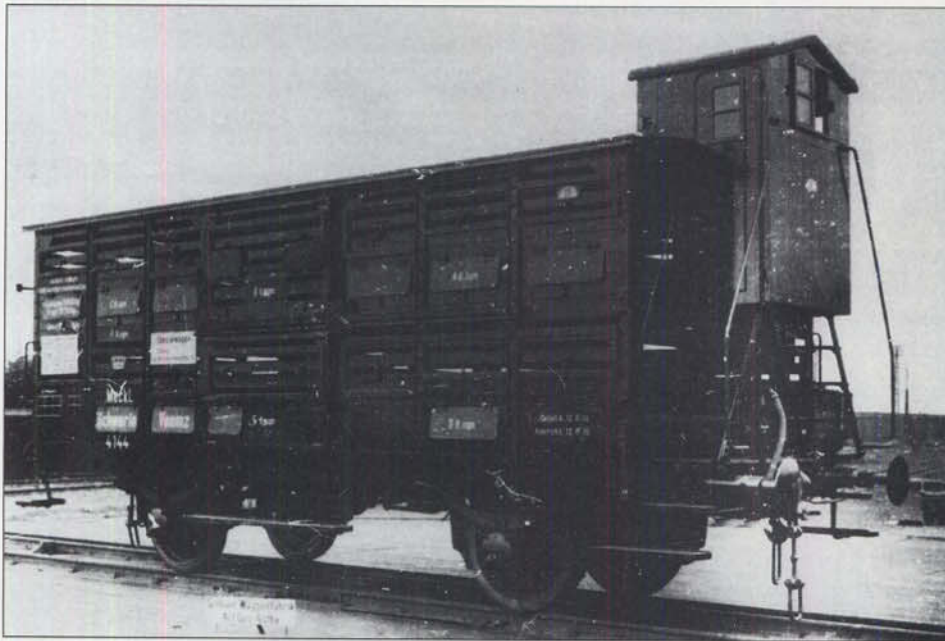
Bild 5: Dieses Bild zeigt – leider in nicht zufriedenstellender Bildqualität – einen der ersten Viehwagen in Verbandsbauart. Er gehörte ab 12. Juni 1913 dem Park der Eisenbahnen im Großherzogtum Mecklenburg-Schwerin an und trägt die Nummer 4144 sowie das Gattungszeichen Venmz. Werkfoto Gothaer Waggonfabrik, Sammlung Heidt
