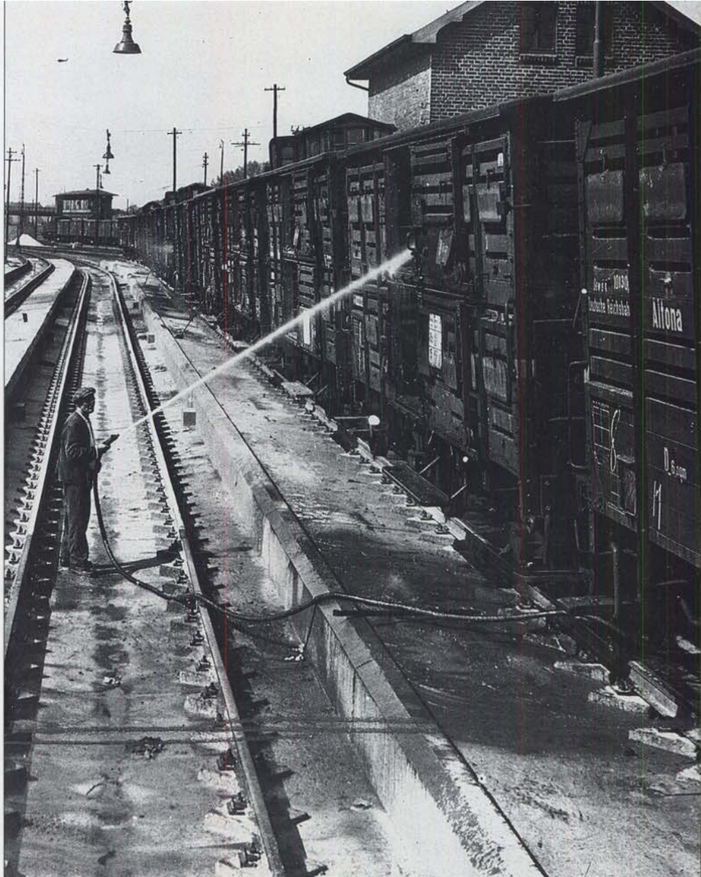
Bild 4: Der Reinigung der Viehwagen kam besondere Bedeutung zu. Hier wird auf einem Nebengleis eines unbekanntes Bahnhofs die Wasserreinigung eines ganzen Zuges durchgeführt. Die Aufnahme dürfte in der ersten Hälfte der dreißiger Jahre entstanden sein. Foto: Bildarchiv der Pressestelle der DRG, Sammlung Diener
