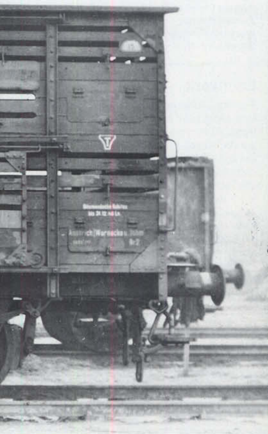
▲ Bild 1: Der Wagen Altona 2507 ist am 8. Mai 1928 im Raw Leinhausen untersucht worden. Mit Ausnahme der Hülsenpuffer weist er noch alle ursprünglichen Bauartmerkmale der Verbandswagen nach Musterzeichnung A 8 auf. Foto: R. Klitscher, Sammlung Diener
