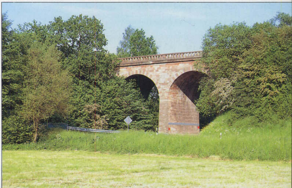
Bild 11: Der Viadukt nahe dem Haltepunkt Reichensachsen-West ist stark verwuchert. Von den vier Bögen sind nur noch zwei sichtbar. Fotos 2, 4, 7 bis 11: K. Rösler
