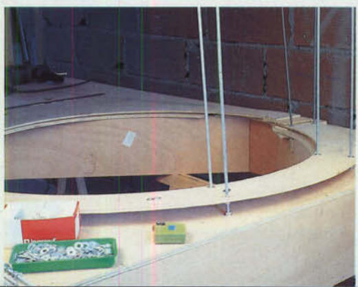
Bild 9: Die erste Etage der Gleiswendel ist montiert.
