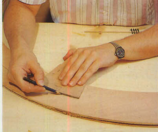
Bild 18: Anzeichnen des Oberleitungsverlaufs mit Schablonenhilfe.
