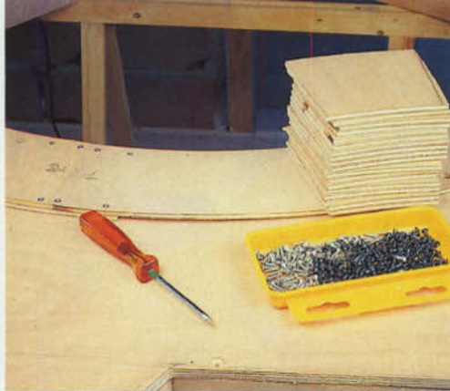
Bild 4: Mit 5 mm dicken Sperrholzplättchen werden die einzelnen Rampenelemente miteinander verbunden.
