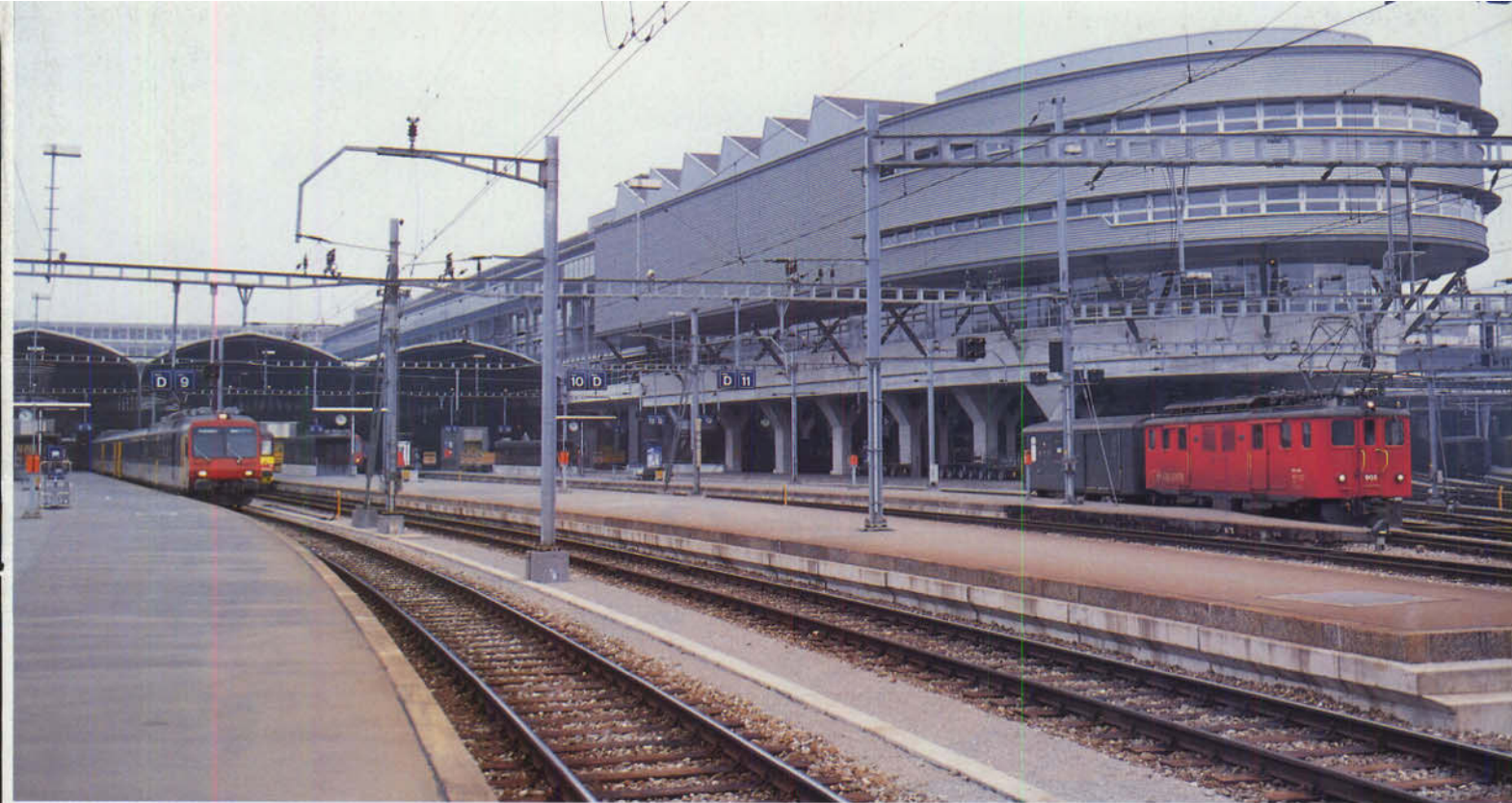
Bild 1: "Titanic" in Luzern? Das neue Postzentrum erhebt sich einem überdimensionierten Vierwaldstättersee-Schiff gleich über den Gleisanlagen zwischen dem Personen- und dem Güterbahnhof. Fotos: B. Studer
