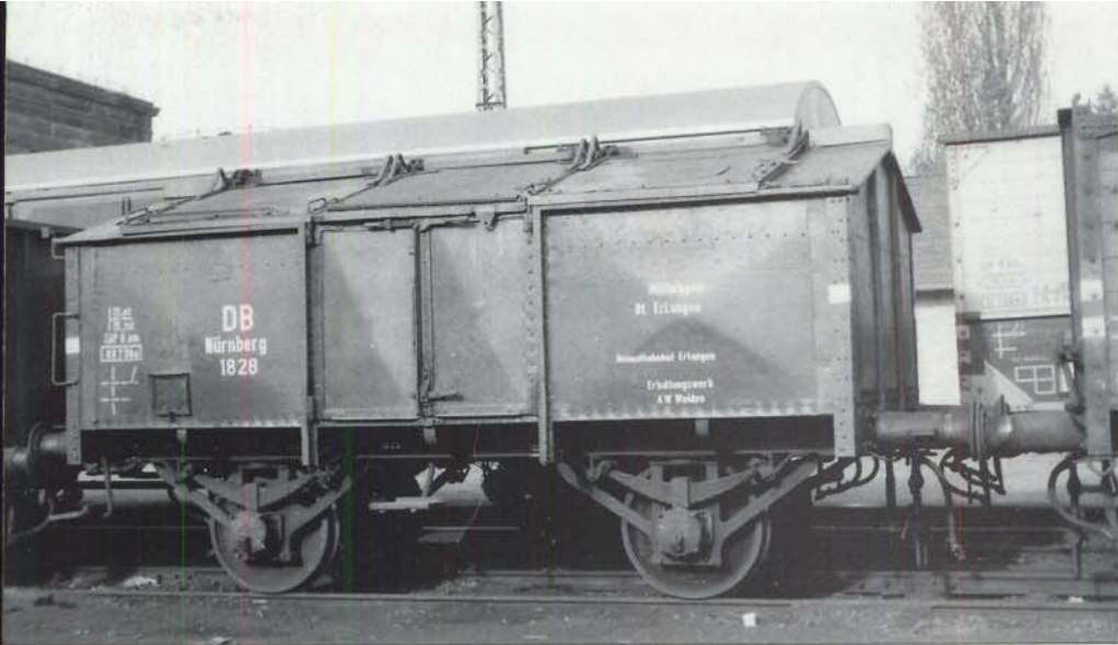
Bild 6: Ein Wagen nach preußischer Musterzeichnung Ild 4 fand 1963 als Müllwagen des Bahnhofs Erlangen Verwendung. Er wurde 1897 in Bochum gebaut und ist noch weitgehend in seinem Originalzustand. Lediglich die Hülsenpuffer entstammen neuerer Zeit.
