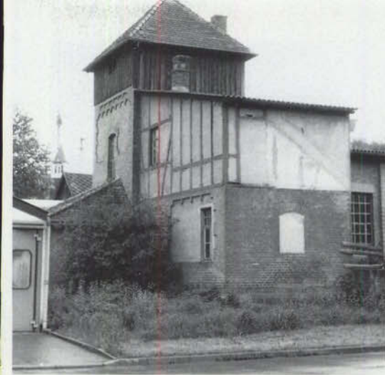
Bild 1: Rückansicht der Untergröninger Remise.
