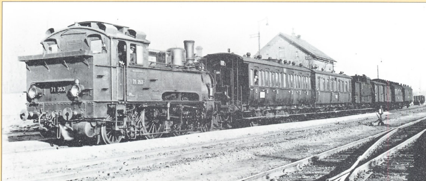
Bild 7: Mit einer interessanten Personenzuggarnitur steht die 71 353 in Brandis (Strecke Beucha – Trebsen/Mulde) zur Abfahrt bereit. Gleich hinter der Lok ein zweiachsiger sächsischer Abteilwagen 2./3. Klasse mit zusätzlicher Plattform an einem Wagenende.
