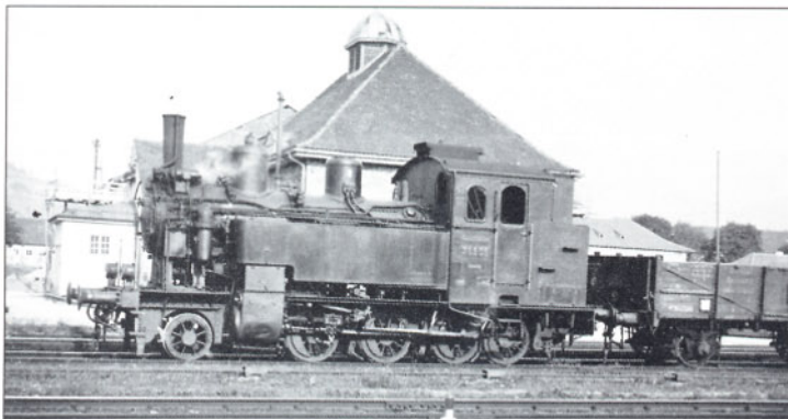
Bild 2: Die Baureihe 98.11 (GtL 4/5) ging zur Reichsbahnzeit aus "4/4"-Umbauten hervor. Foto: E. Schörner, Sammlung Dr. Hufnagel
