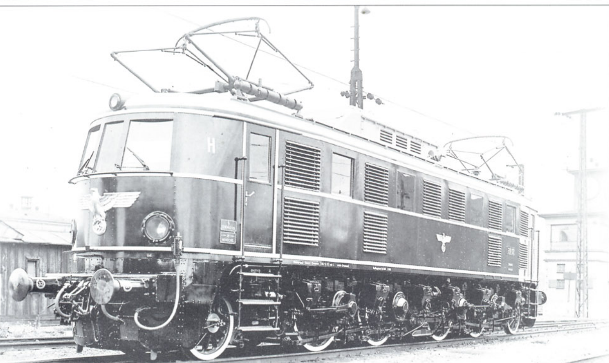
Bild 15 (links): Die E 1912 wurde als letzte ihrer Baureihe am 15. Oktober 1940 dem Betriebsdienst übergeben. Das bei den Lokomotiven E 1911 und 12 außenliegende Bremsgestänge ist auf diesem Foto gut zu erkennen.
