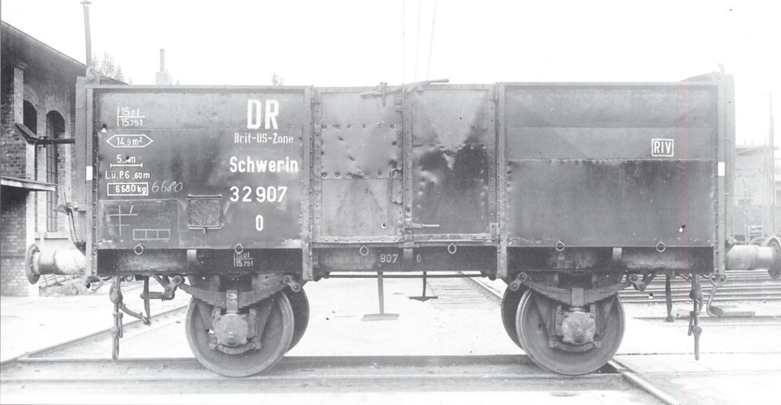
Bild 3: Der Schwerin 32907 ist ein ungebremster Kohlenwagen nach Musterzeichnung Ild 1 der Preußischen Staatseisenbahnen. Die Seitenwände wurden mittels aufgeschweißter Bleche ausgebessert. Gut zu erkennen ist der Verriegelungsgriff an der oberen Kante der Flügeltüren. Dieser Griff ist zusammen mit den Trittstufen unter den Türen bei der Verbandsbauart weggefallen. Der Wagen mit den Anschriften der seinerzeitigen Deutschen Reichsbahn wurde um 1950 in der Bizone im Bild festgehalten. Foto: R. Klitscher, Sammlung Diener
