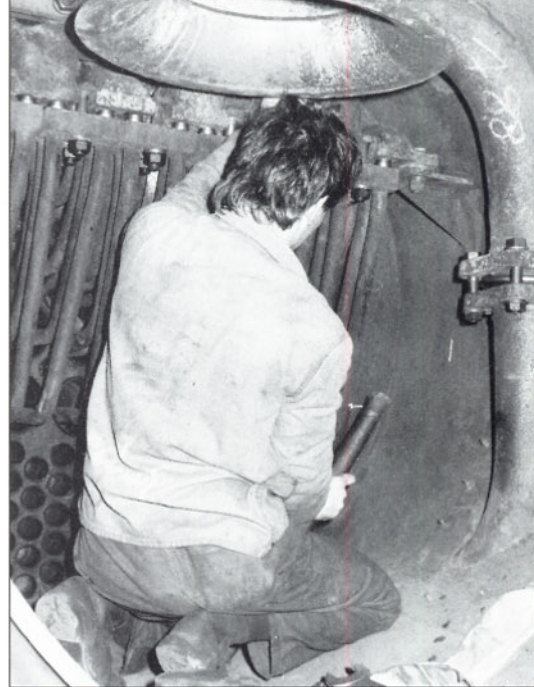
Bild 6: Einbau der Überhitzerelemente bei der Neubaulok 99 1779.
