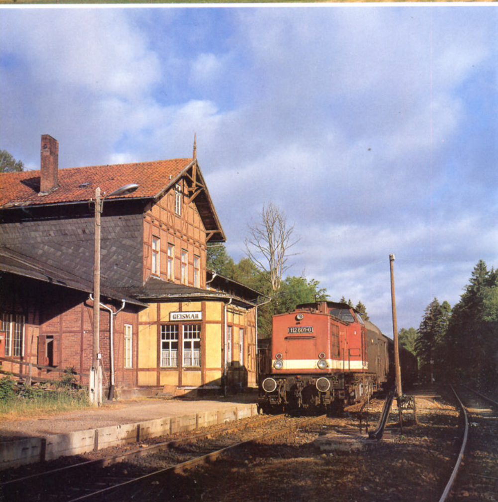
◀ Bild 2: In Geismar ist seit der Teilung Deutschlands Endstation.
