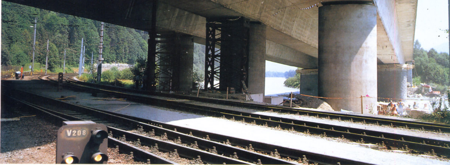
Bild 1: Drohte einzustürzen: die Autobahnbrücke über den Inn bei Kufstein. Im Hintergrund rechts der abgesackte Flußpfeiler, im Vordergrund die Bahnstrecke München – Kufstein – Innsbruck. Die Arbeiten an den Hilfspfeilern waren am Tag der Aufnahme, dem 20. Juli 1990, noch in vollem Gang.
