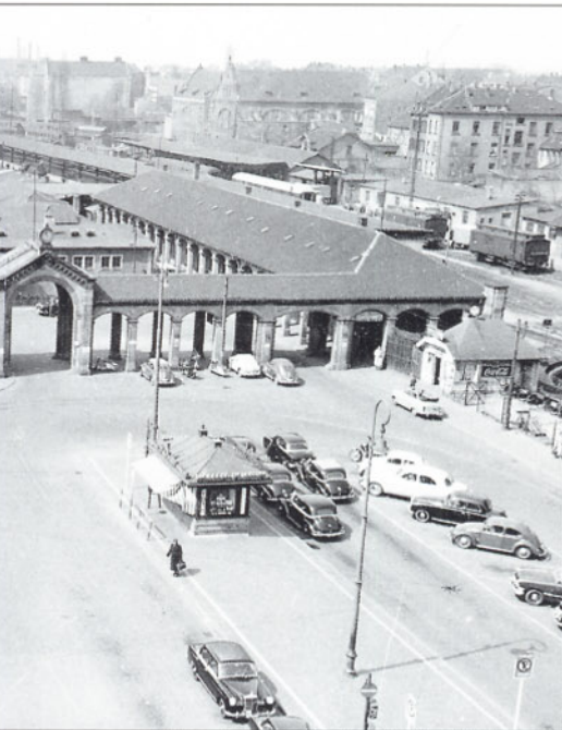
ausgerichtet. Für die Züge von/nach Neckar- gemünd sind Durchgangsgleise (links im Bild) vorhanden.
