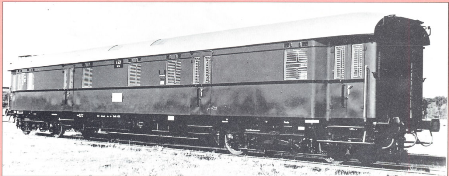
Bild 5: Paketpostwagen in geschweißter Ganzstahlbauweise der Gattung 4-p/21 (Baujahr 1935). Foto: Sammlung Dr. Scheingraber
