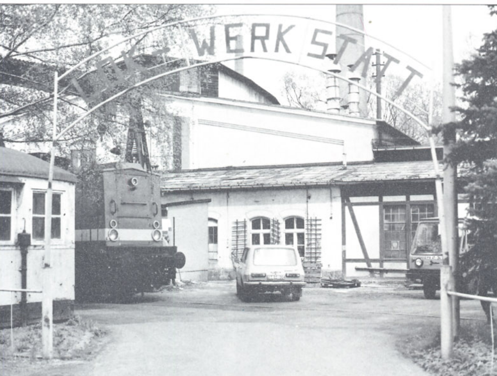
Bild 2: Das "Eingangsportal" zur Lokwerkstatt Zittau-Pethau.
