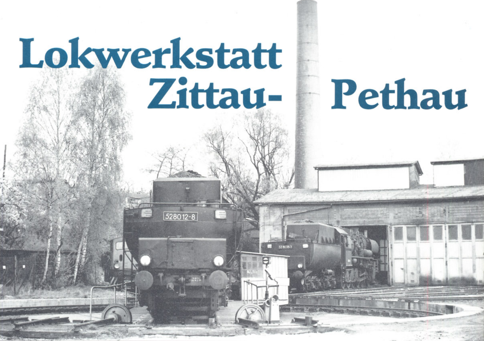
Bild 1: Die Heizlokomotive 52 8012 am 5. April 1990 auf der Drehscheibe in der Lokwerkstatt Zittau-Pethau. Die Maschine wird jetzt auf ihren Stammplatz am Gleis links vom Ringlokschuppen in unmittelbarer Nähe des Schornsteins vorrücken.
