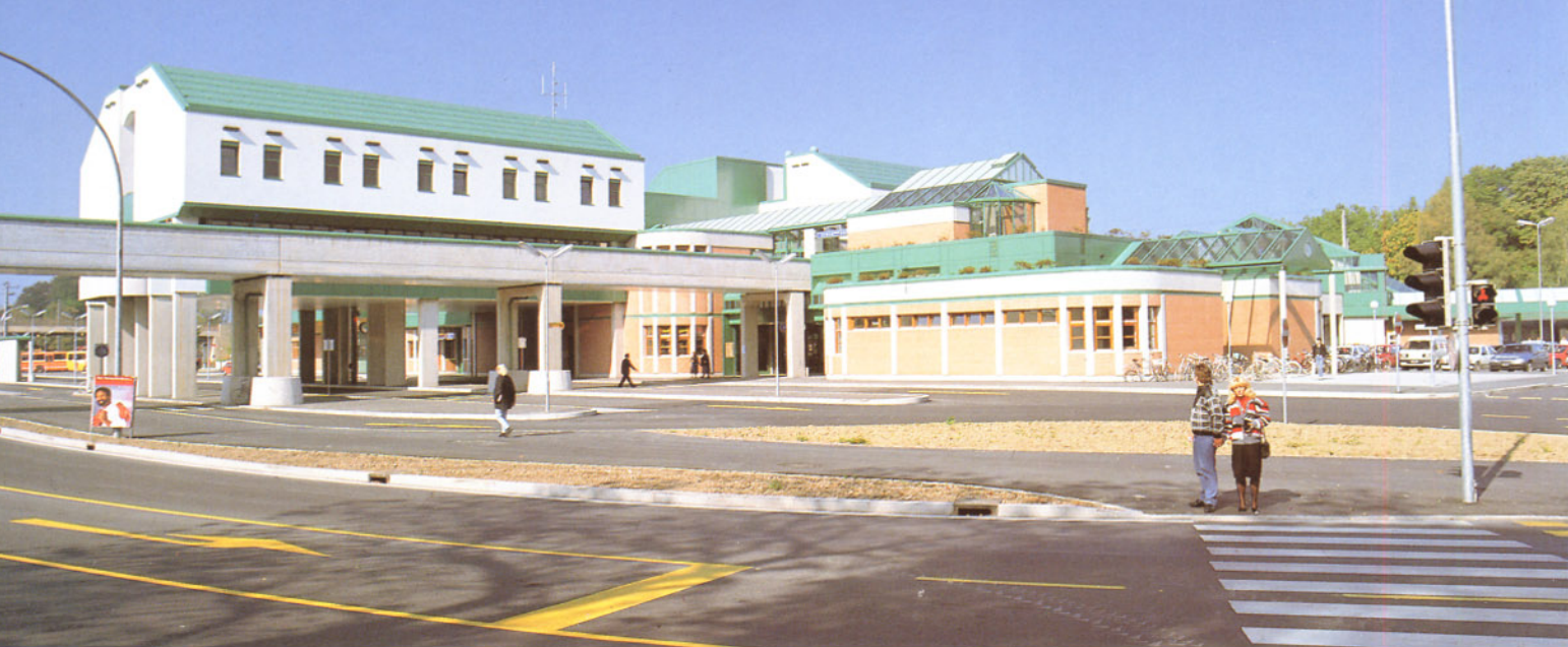
Bild 1: Der neue Bregenzer Bahnhof von der Stadtseite her gesehen. In der linken Bildmitte ist der Fußgängersteg über die B202 zu erkennen.
