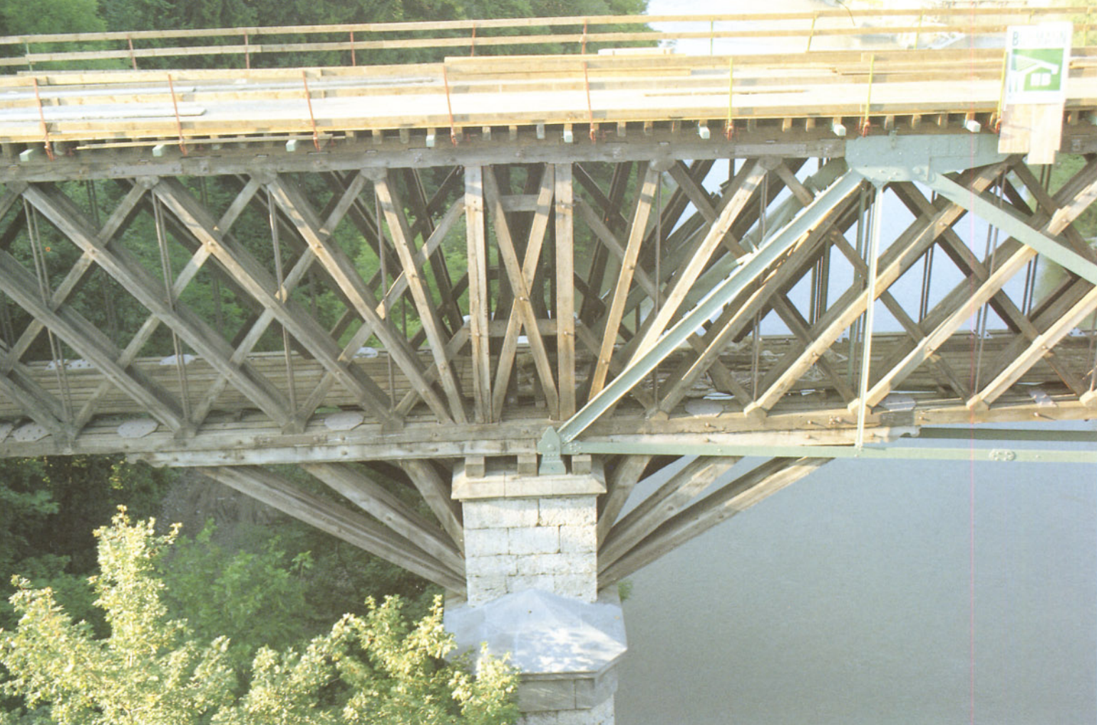
Bild 11: Detailansicht der Abstützung und der Lagerung des Tragwerks auf einem der beiden Pfeiler. Beim Anblick dieser filigranen Holzbauausführung kann man gut verstehen, daß die Brücke so sehr zum Nachbau als H0-Modell reizte.
