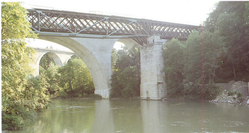
Bild 4: So sehen die drei Illerbrücken heute aus. Im Vordergrund ist an dem Pfeiler der Holzbrücke deutlich zu erkennen, daß diese ursprünglich zwei Tragwerke besaß.
