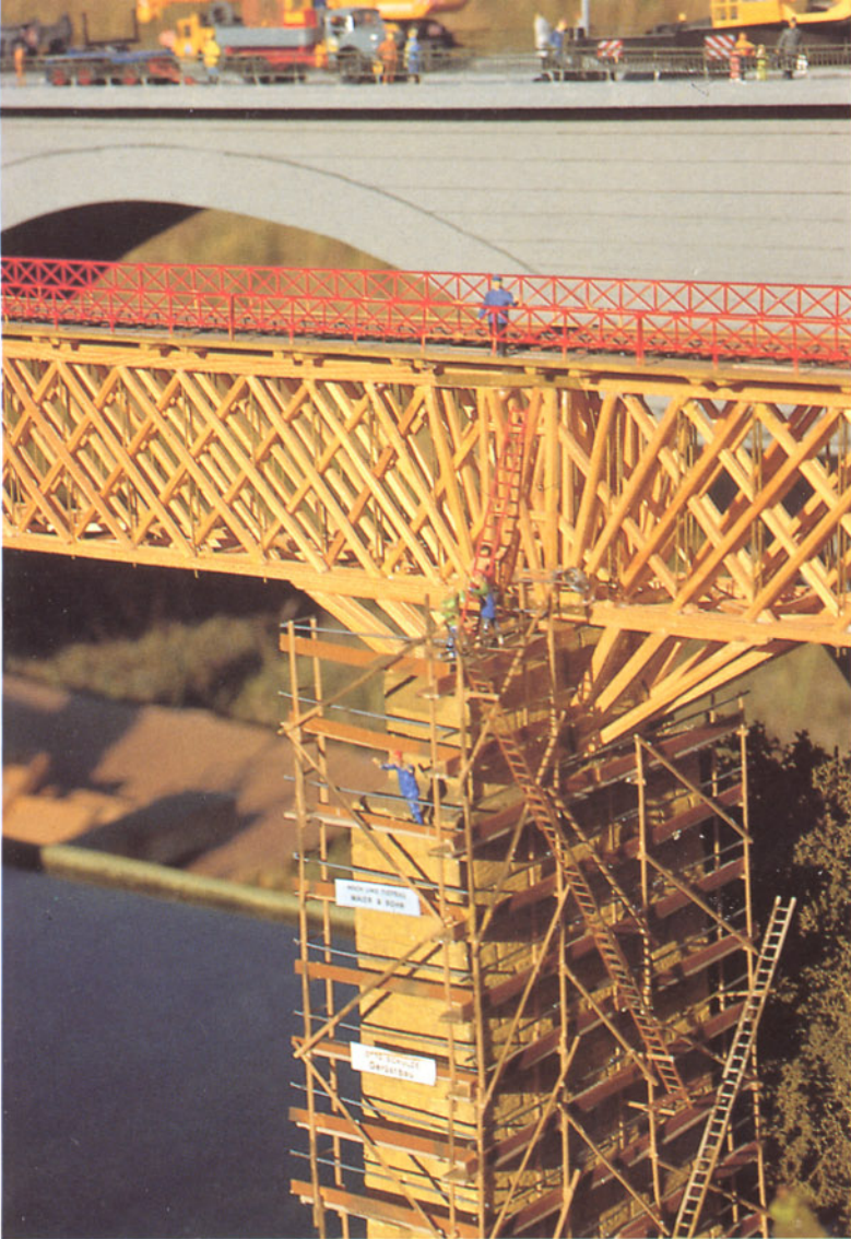
Bild 8: Der rechte der beiden Pfeiler ist von einem Gerüst umgeben, das zusammen mit den Baufahrzeugen auf der Betonbrücke im Hintergrund die Baustellenszene glaubwürdig erscheinen läßt.
