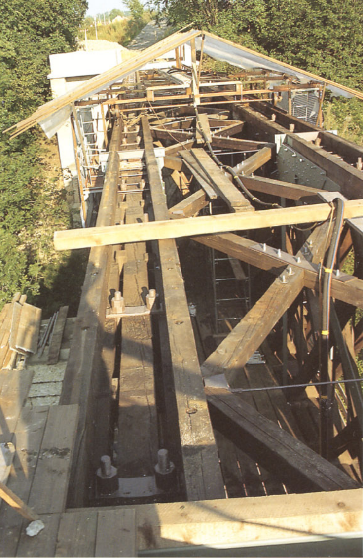
Bild 6: Diese Aufnahme entstand während der Sanierungsarbeiten. Sie zeigt sehr schön einige Details des Brückenfachwerks. Kaum zu glauben, daß diese Konstruktion einst ganze Züge getragen hat!
