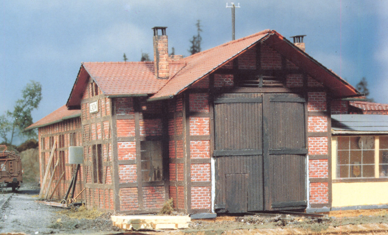
Bild 6: So wirkt der Lokschuppen aus der "Modellbahnmensch-Perspektive" – ein stattliches Gebäude für einen einständigen Lokschuppen!
