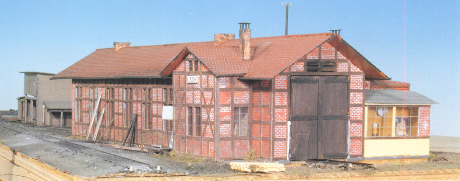
Bild 1: Das fertige Modell des Lokschuppens Calw, Ansicht von der Bahnhofseite auf die vordere Schuppeneinfahrt. Beachten Sie auch den weißen Warnanstrich links und rechts an den Schuppeneinfahrten.
