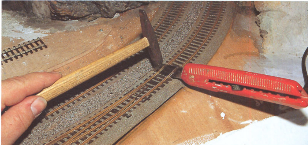
Bild 5: Eine defekte Weiche wurde entnommen. Gut sichtbar: Der zwischen die Gleise eingebrachte Schotter bleibt absolut formstabil.
