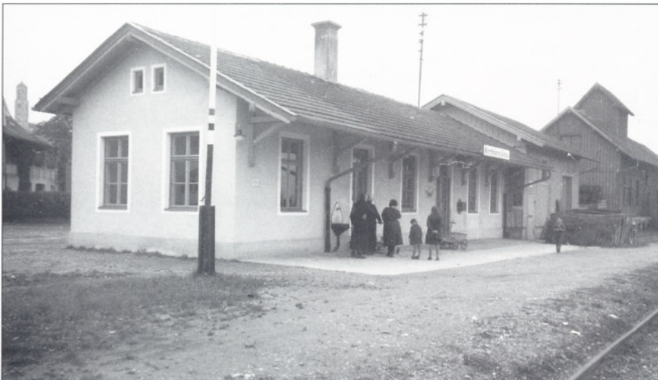
Bilder 12 und 13: Die Ausführung des Dienstgebäudes in einstöckiger Bauweise verrät bereits die Sparsamkeit der Bayerischen Staatseisenbahnen bei der Errichtung von Hochbauten für Lokalbahnen zu Beginn unseres Jahrhunderts (Aufnahmen vom 17. Oktober 1939).
