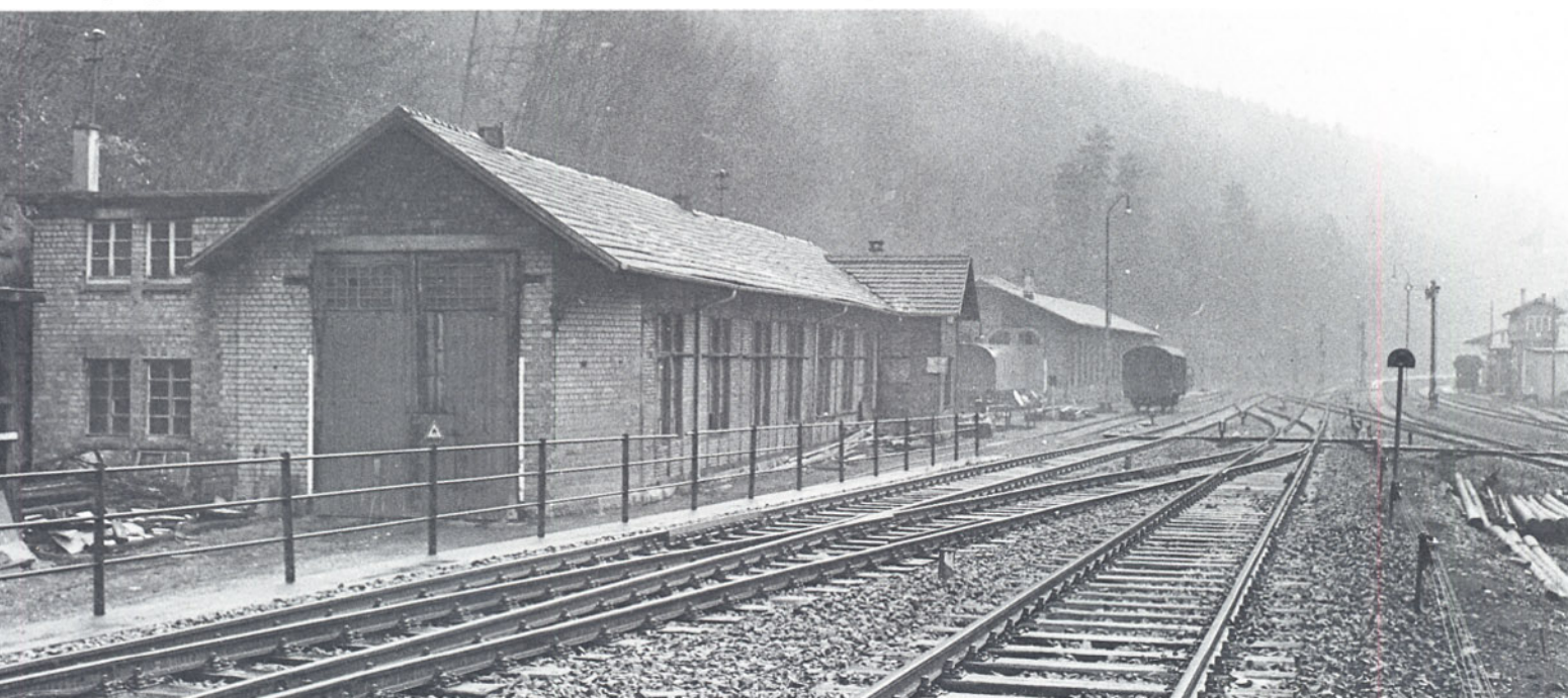
Bild 2: Das Vorbild. Diese Ansicht von hinten zeigt sehr gut die umgebaute hintere Stirnwand mit der abgeschrägten Gebäudecke. Im Vordergrund die einst zweigleisige Steilstrecke hinauf nach Weil der Stadt, die das Bw-Gelände stark einengt. Foto: H. Stemmler
