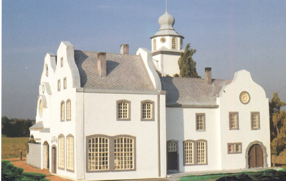
Bild 4: In dem großen Eckgebäude befindet sich die Klosterschenke. Die Anfertigung der eindrucksvollen Fenster ist zeitaufwendig, lohnt aber in jedem Fall die Mühe.
