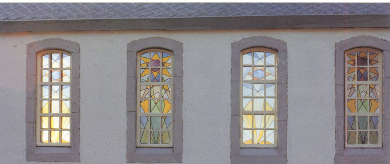
Bild 11 (unten): Auch von innen betrachtet wirken die Fenster perfekt. Und natürlich fehlen in dieser Kirche auch die Beichtstühle nicht.
