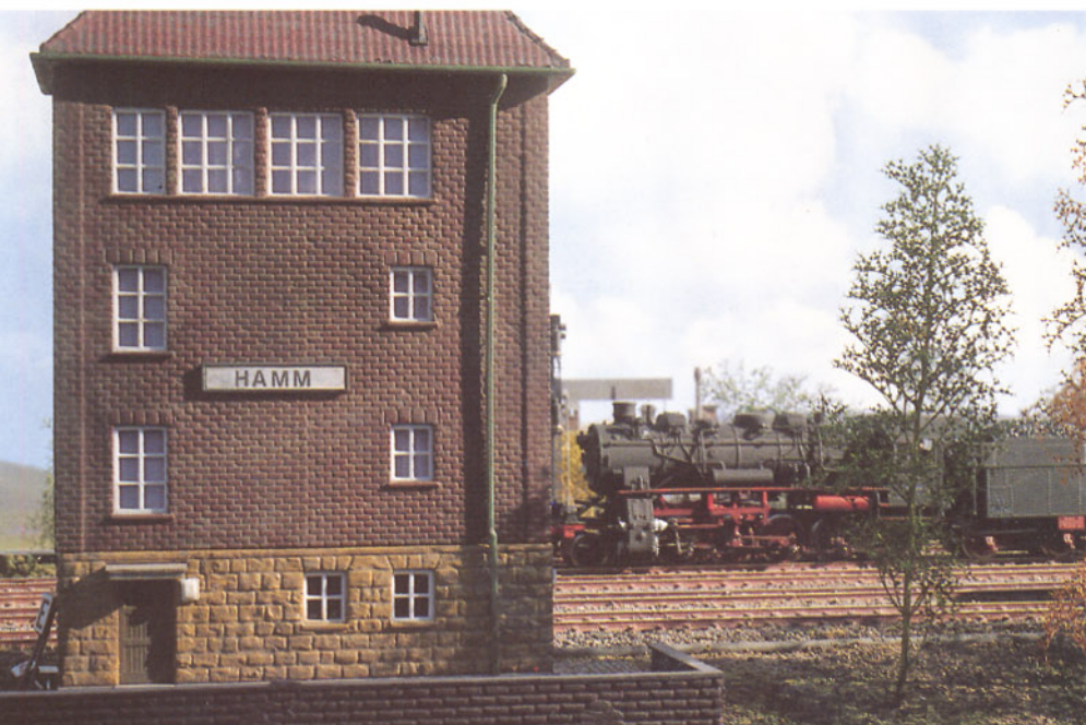
Bild 11: Das Reiterstellwerk Hamm befindet sich ebenfalls in Hochlage. Um einen sicheren Baugrund zu schaffen, mußte die Stützmauer um einen entsprechenden Sockel erweitert werden.
