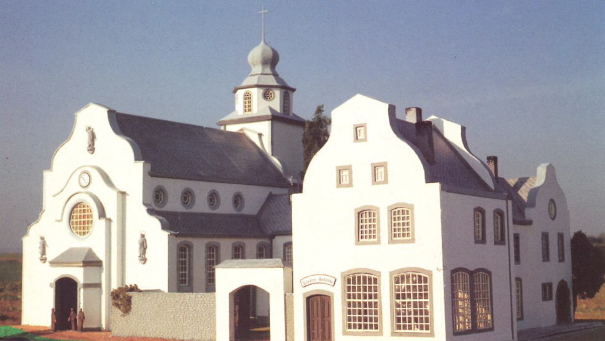
Bild 16: Der Innenhof ist an drei Seiten von Kirche, Verwaltungs- und Wohngebäude und Schenke begrenzt. Vorn schließt ihn eine Natursteinmauer ein.
