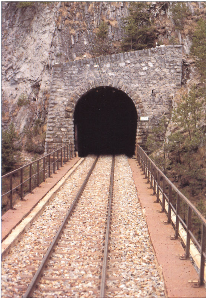
Der Brombänztunnel II bei Monstein an der Strecke Davos — Filisur ist 232 m lang. Die Zügenschlucht wird hier zwischen zwei Tunnelportalen auf einem Viadukt überquert. Foto: W. Hartmann
