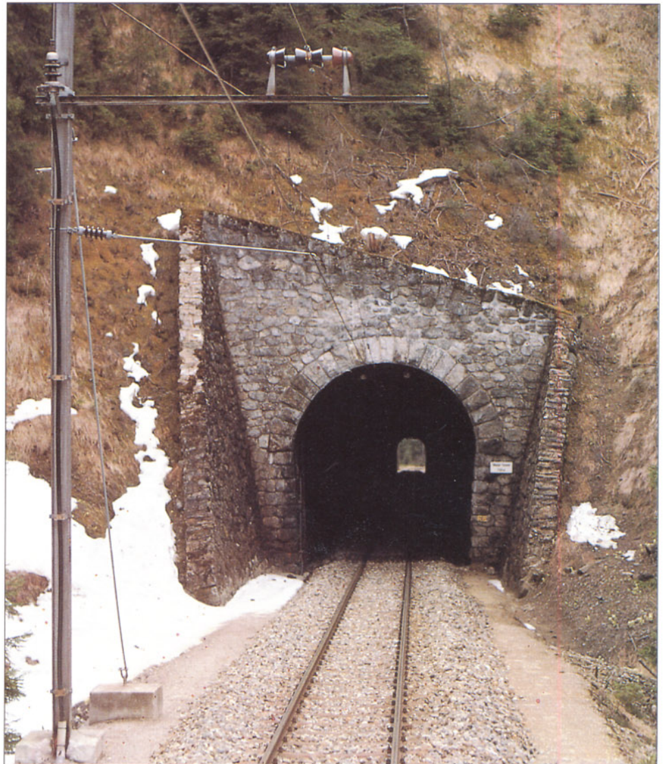
Der Schloßbergtunnel bei Filisur an der Strecke Chur – St. Moritz ist 56 m lang. Man beachte die seitliche Stützmauer und die Fahrleitungsabspannung an der Portalwand.
