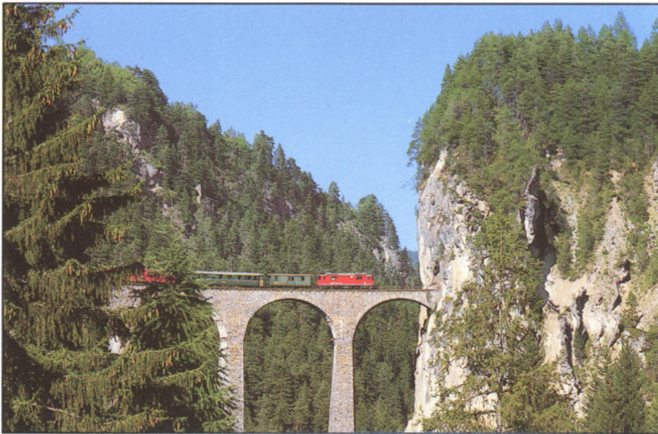
Der berühmte Landwasserviadukt zwischen Filisur und Alvaneu.
