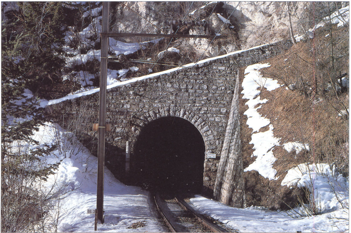
Der Madjatunnel bei Wiesen an der Strecke Davos – Filisur ist 260 m lang. Die seitlichen Stützmauern sind bis in die Höhe der Portalwand hochgezogen.
