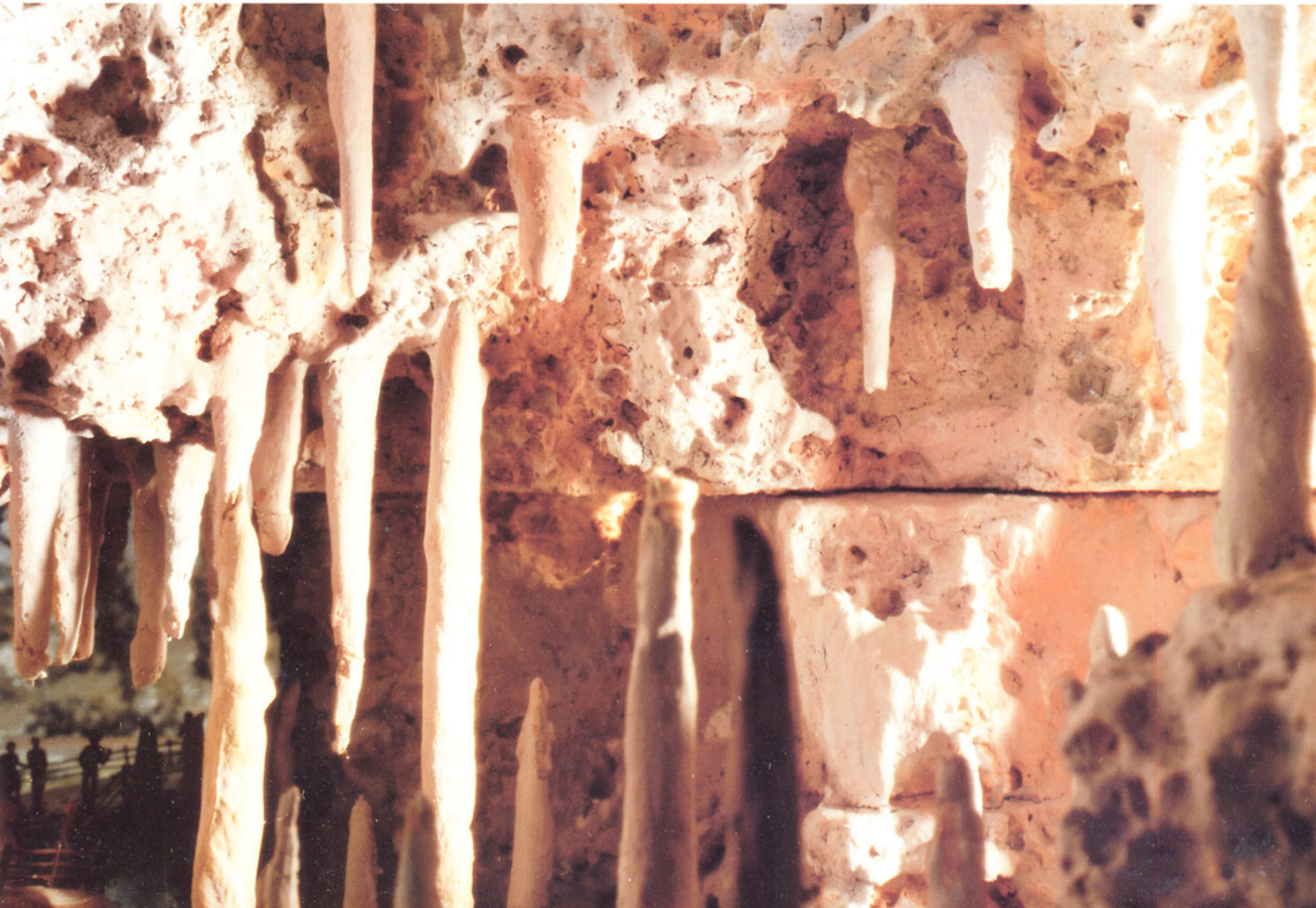
Bild 7: Hier erkennt man die Trennfuge des Höhlenober- und -unterteils, die jedoch nur von einem rückwärtigen Guckloch, das normal durch einen Spiegel verkleidet ist, sichtbar wird.
