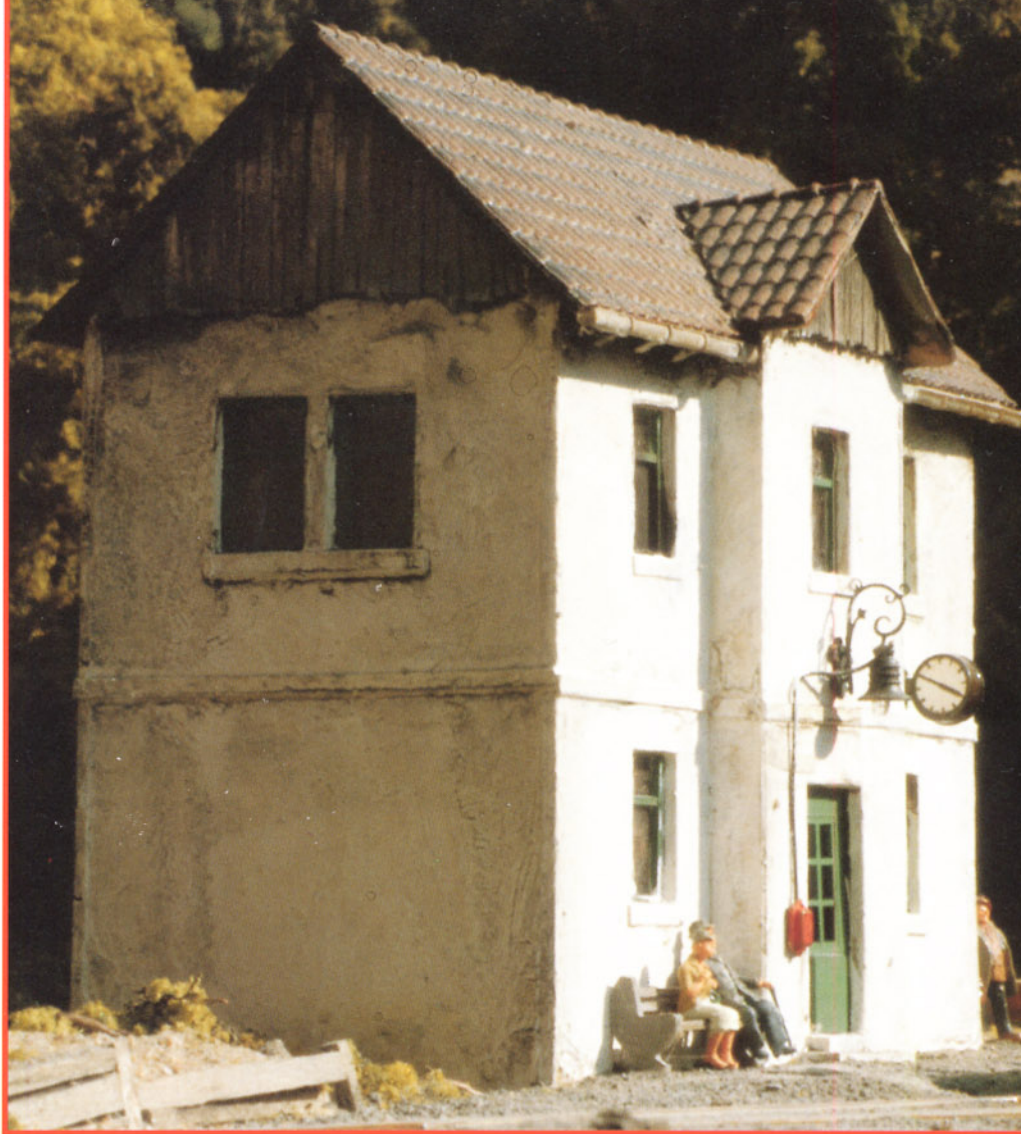
Bild 11: Das kleine Empfangsgebäude hat schon bessere Zeiten gesehen; es erfüllt aber noch seinen Zweck.
