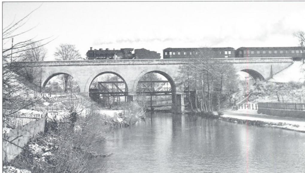
Bild 16: Ein mit einer S 3/6 bespannter Eilzug nach Regensburg überquert Mitte der fünfziger Jahre in Sinzing die Brücke über die Schwarze Laaber. Foto: G. Turnwald
