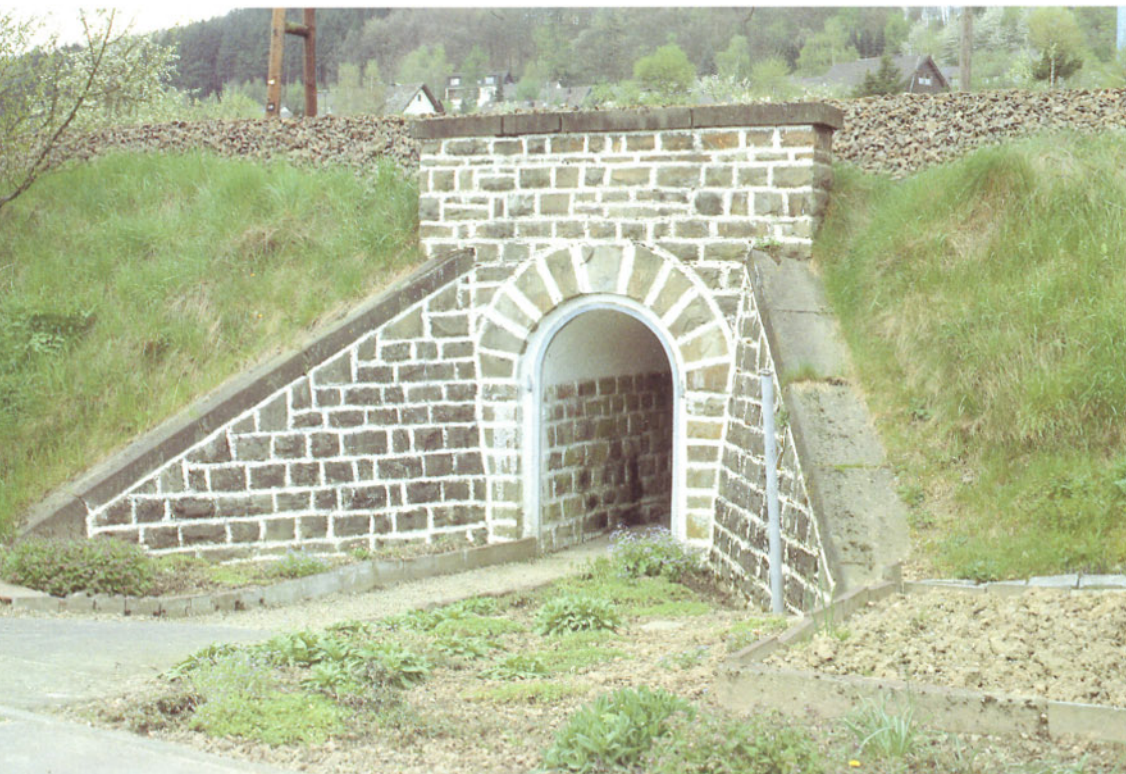
Bild 8: Optisch eindrucksvoller, aber superschmaler Wegedurchlaß in Hardt.
