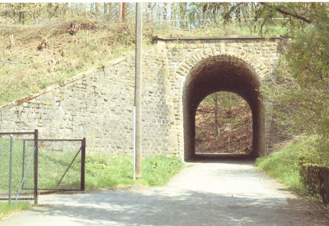
Bild 9: Grundform eines hohen Straßendurchlasses (Dieringhausen).
