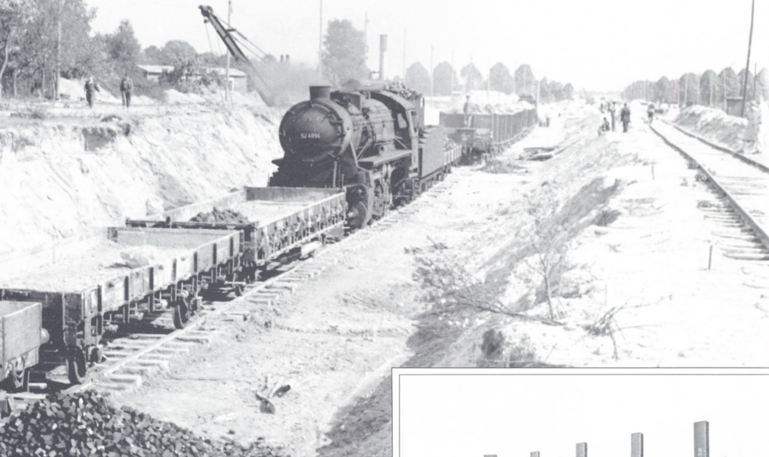
Bild 1: Vor der 52 4994 sind ein Rungenwagen der Austauschbauart sowie ein pr. Sml (R 02) zu erkennen. Foto: Sammlung Wilhelm
