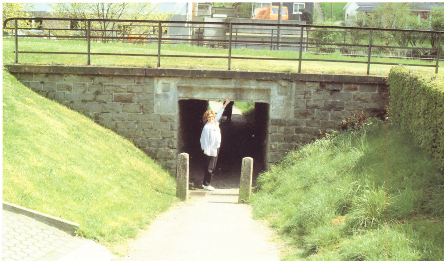
Bild 1: Der abgesenkte und sehr niedrige Wegedurchlaß wurde in Osberghausen fotografiert.
