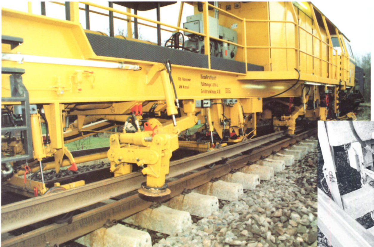
Bild 7: Nahaufnahme: präzise und "wie am Schnürchen" verlegt die Maschine die Monobloc-Betonschwellen.
