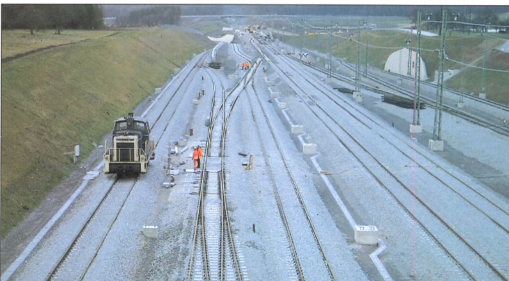
Bild 6: Seiner Fertigstellung geht bereits der neue Bahnhof von Vaihingen/Enz entgegen. Links und rechts münden die Gleise der alten Strecke in die Neubaustrecke ein. Alle Fotos: E. Stezenbach
