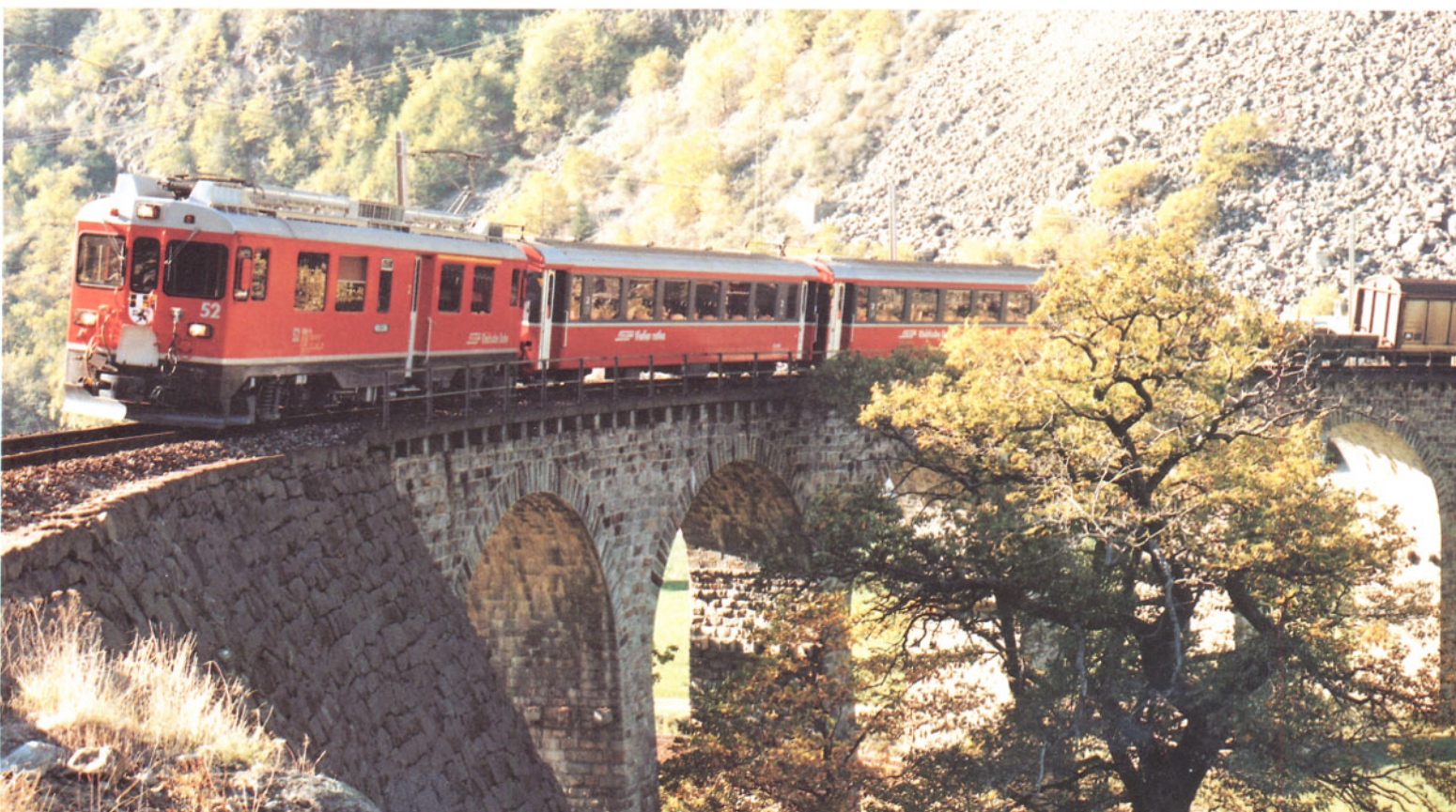
Bild 7: Bei Brusio befindet sich der einzigartige Kehrviadukt der Rhätischen Bahn. Die Trasse gewinnt hier 20 Höhenmeter. Foto: ABB
