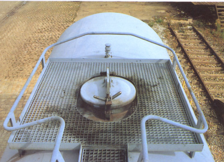
Bild 2: So sieht ein Kesselwagen im Bereich des Laufsteiges und der Einfüllöffnung aus. Deutlich zu erkennen sind die Spuren des übergelaufenen Mineralöls.
