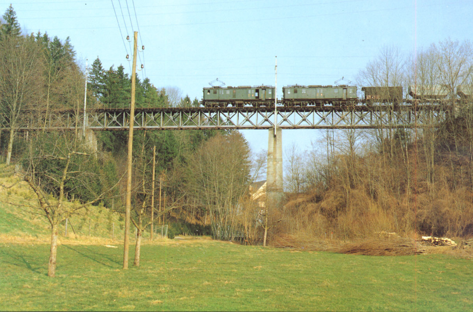
Bild 6: Mit dem Güterzug 65680 am Haken überqueren De 4/4 1680 und 1675 (in Doppeltraktion) gerade das größte Brückenbauwerk der Strecke Hauptwil – Bischofszell Stadt (11. März 1983). Foto: P. Bäuchle
