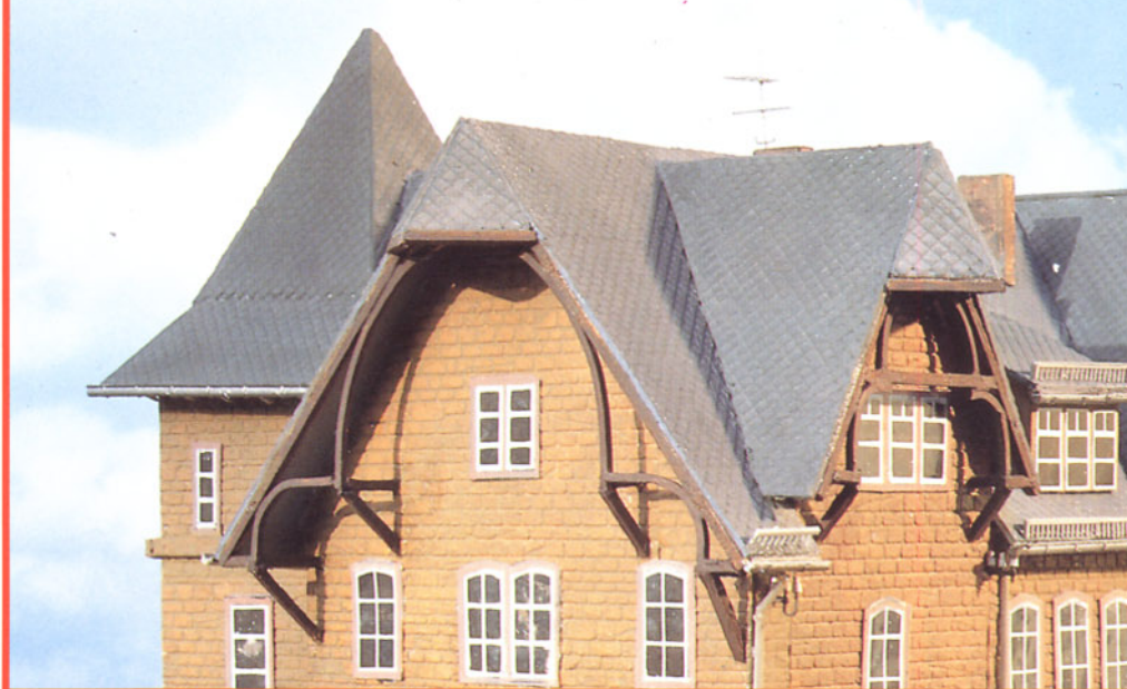
Bild 9: Die vorragenden Dächer des Empfangsgebäudes werden von einer eindrucksvollen Balkenkonstruktion mitgetragen.
