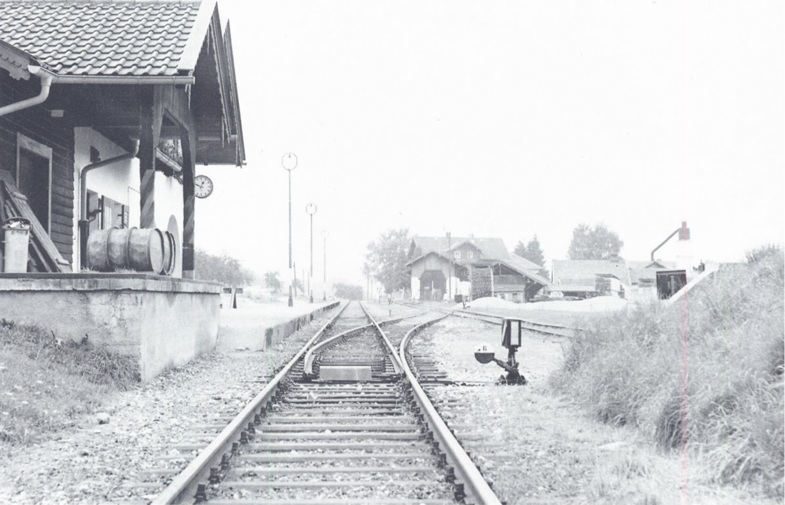
Bild 13: Über diese Weiche in das dritte Gleis mußten die Lokomotiven ankommender Züge umgesetzt werden. Im Hintergrund erkennt man den Lokomotivschuppen. Foto: H. Obermayer
