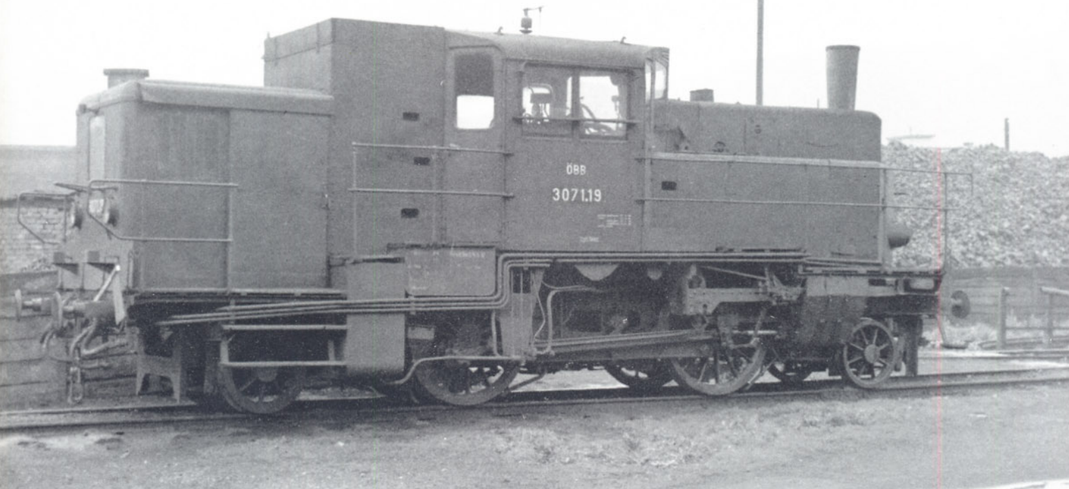
Bild 8: Der 3071.19 von der rechten Seite gesehen. Der Gepäckraum hat eine Schiebetüre. Über der hinteren Pufferbohle erkennt man das hier ausnahmsweise noch vorhandene klappbare Übergangsblech. Foto: Dr. Hufnagel
