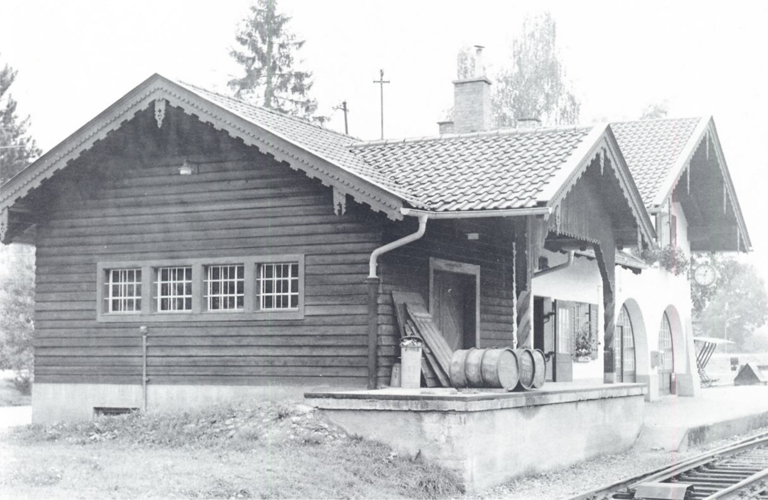
Bild 8: Der an das Empfangsgebäude angebaute Güterschuppen mit Laderampe.
