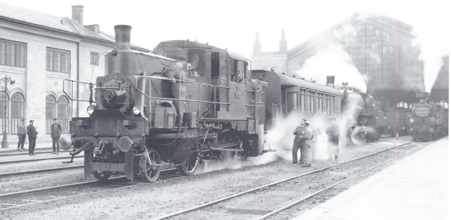
Bild 2: Der DT 1.02 steht abfahrtsbereit zu einer Meßfahrt im Wiener Nordbahnhof. Hinter dem Triebwagen ist der Meßwagen zu erkennen; als Bremslok fungiert eine Maschine der Serie 310. Foto: O. Zell, Sammlung Dr. Scheingraber
