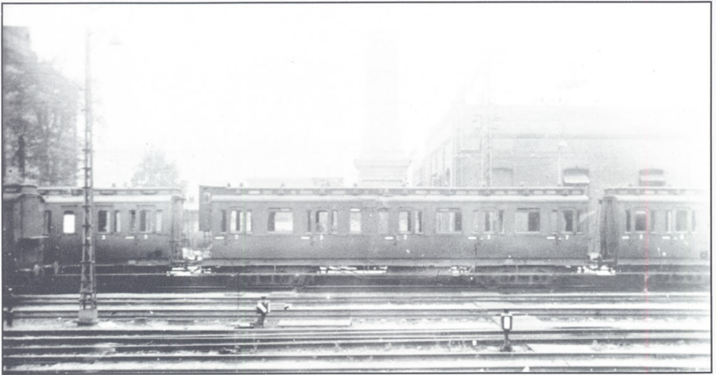
Bild 1: Der aus dem Dampftriebwagen Bauart Stoltz mit der Betriebsnummer Frankfurt 82 entstandene vierachsige Abteilwagen mit der Gattungsbezeichnung C4 Pr 06a/22. Foto: E. Konrad
