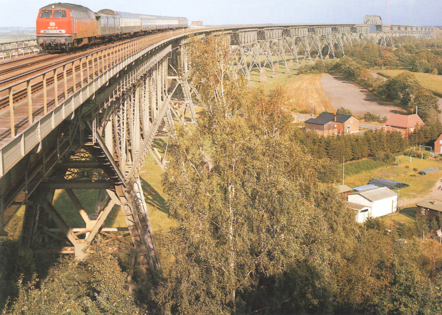
Bild 16: Bei Burg (Dithm) quert die Strecke Hamburg – Westerland (Sylt) den Nord-Ostsee-Kanal. Hier fotografierte Udo Geum am 08.09.1974 die 218 207 zusammen mit einem Eilzug. Foto: U. Geum
