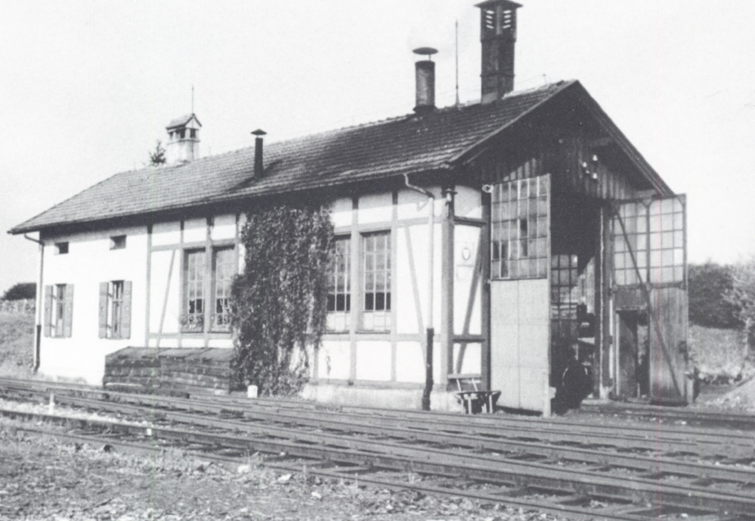
Bild 3: Der kleine einständige Lokschuppen in Monheim (Schwab) in einer Aufnahme vom August 1940.
