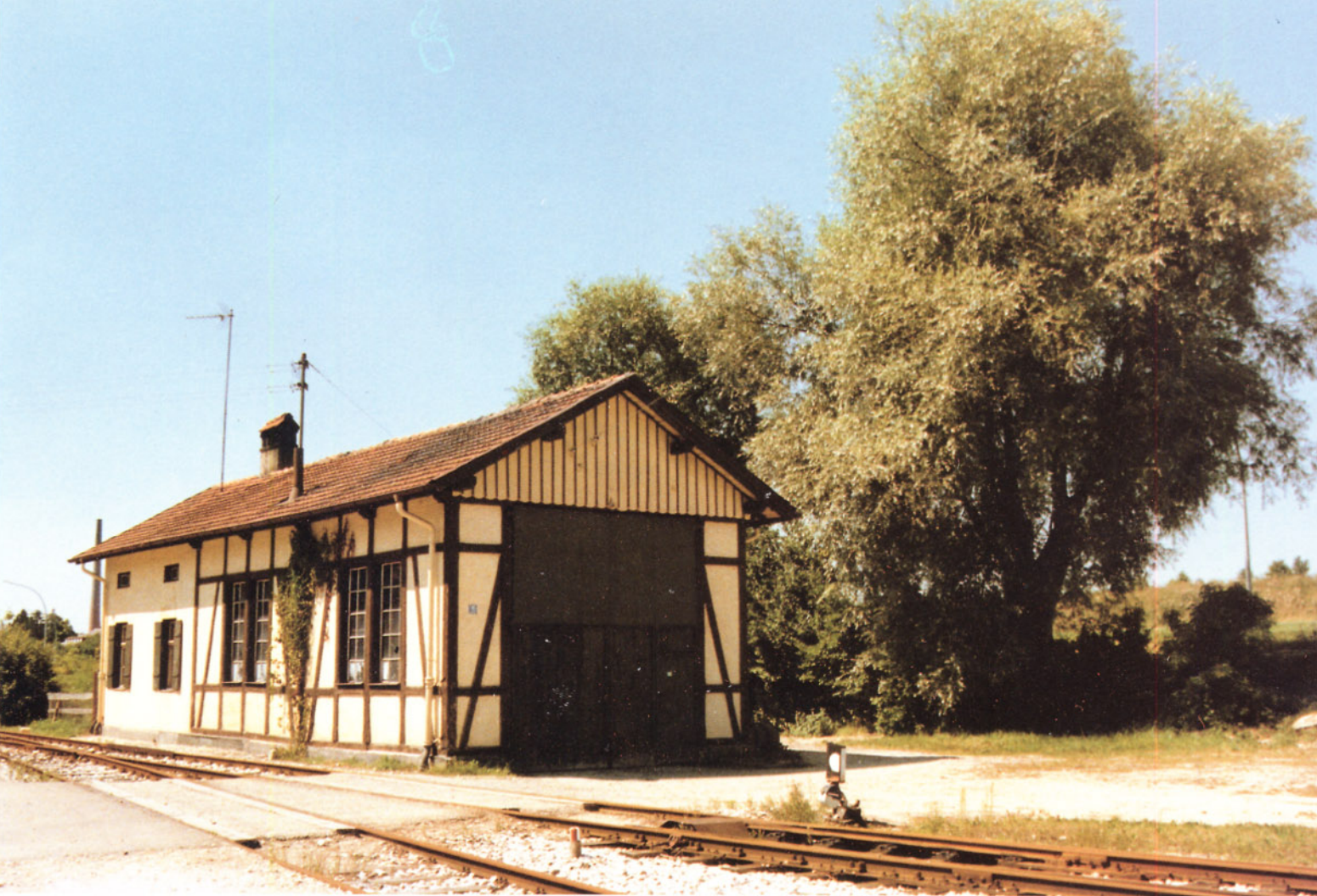
Bild 17: Der Lokschuppen in Monheim besitzt keinen Gleisanschluß mehr. Er dient heute als Lkw-Garage (mit Wohnhaus).
