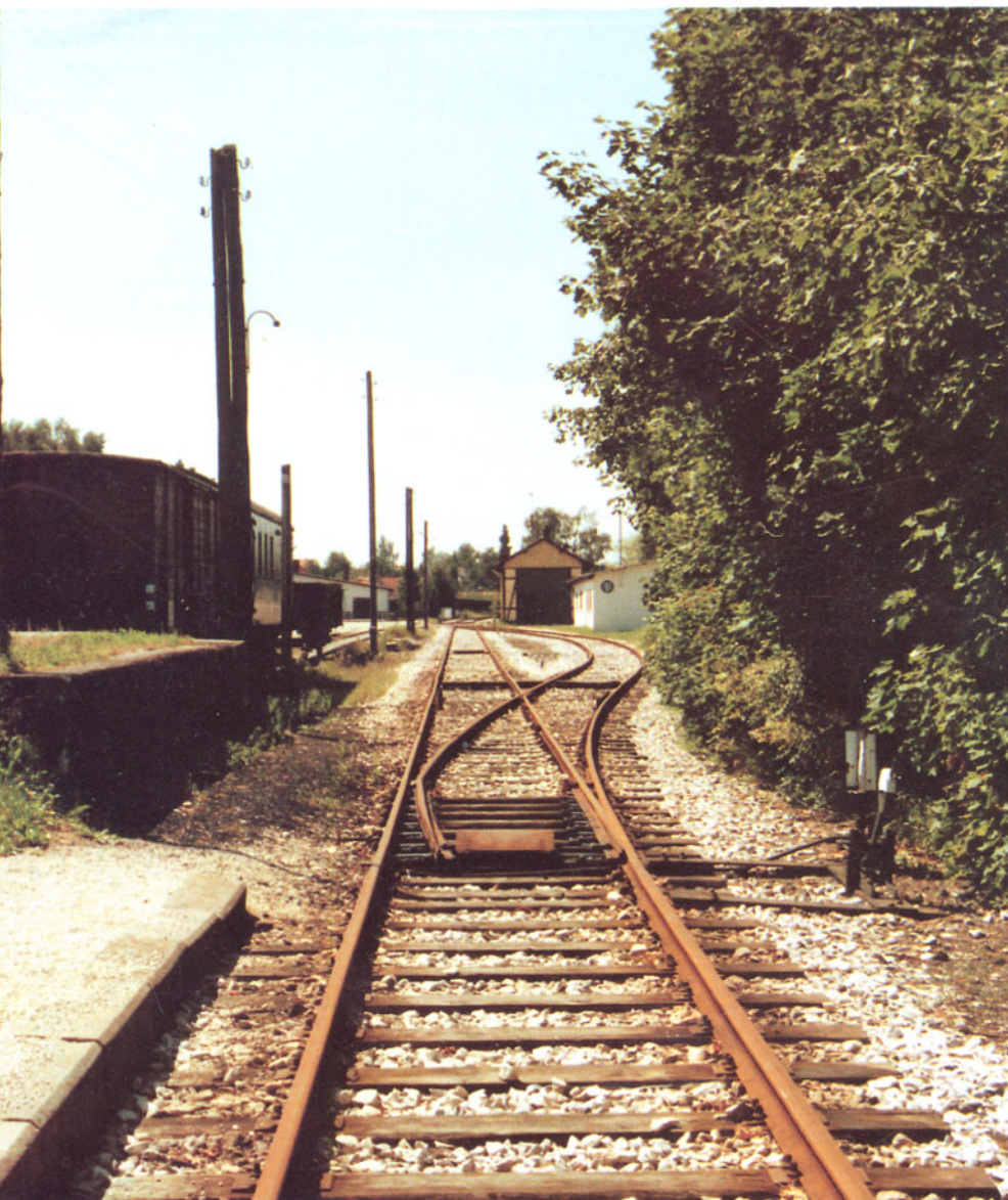
Bild 6: Blick vom Bahnsteig in Monheim (Schwab) in Richtung Lokschuppen. Foto: H. Obermayer
