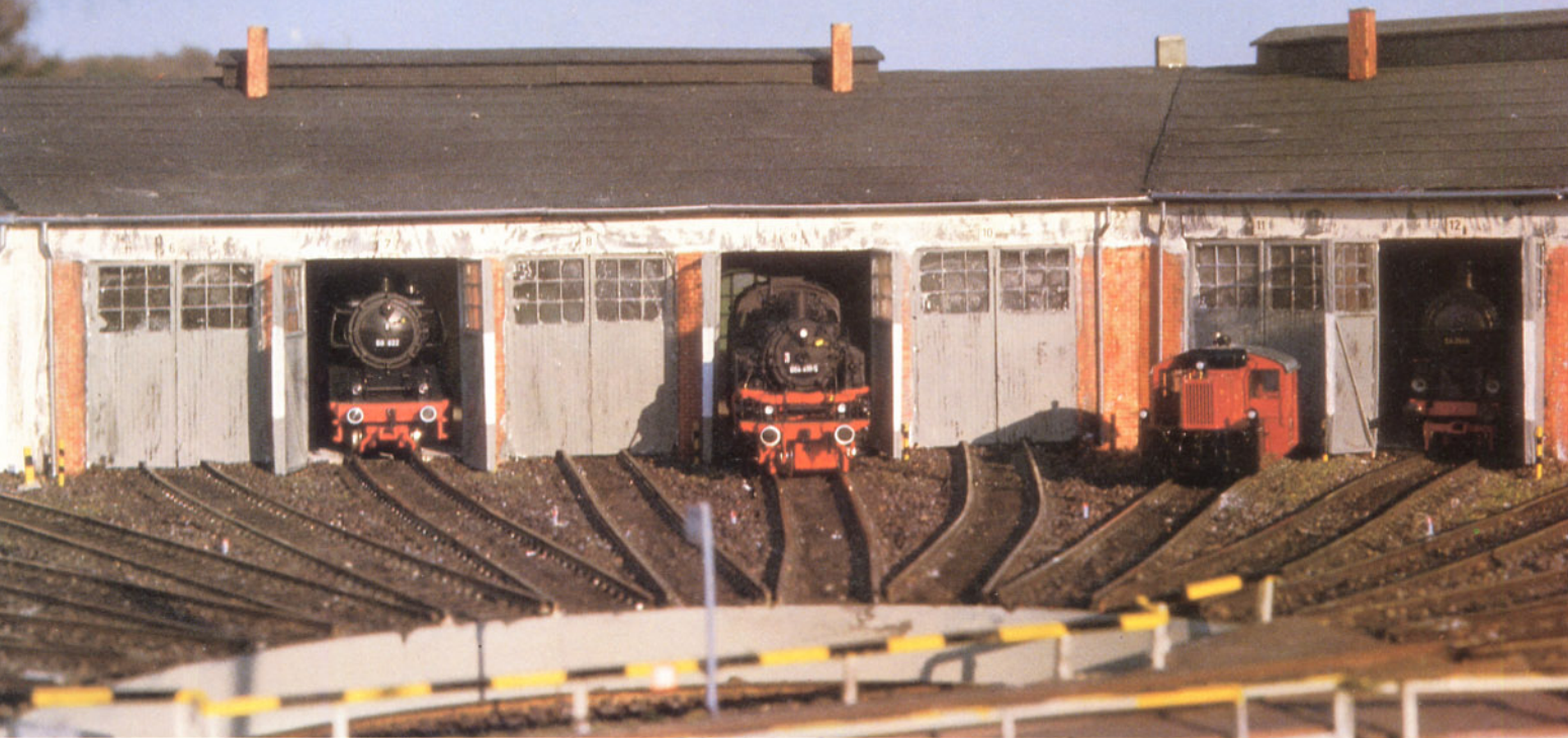
Bild 3: Blick auf den 15-ständigen Lokschuppen des Bw Nördlingen. Vorzüglich gelungen sind die Tore, die aufwendig von Silikonformen abgossen wurden.
