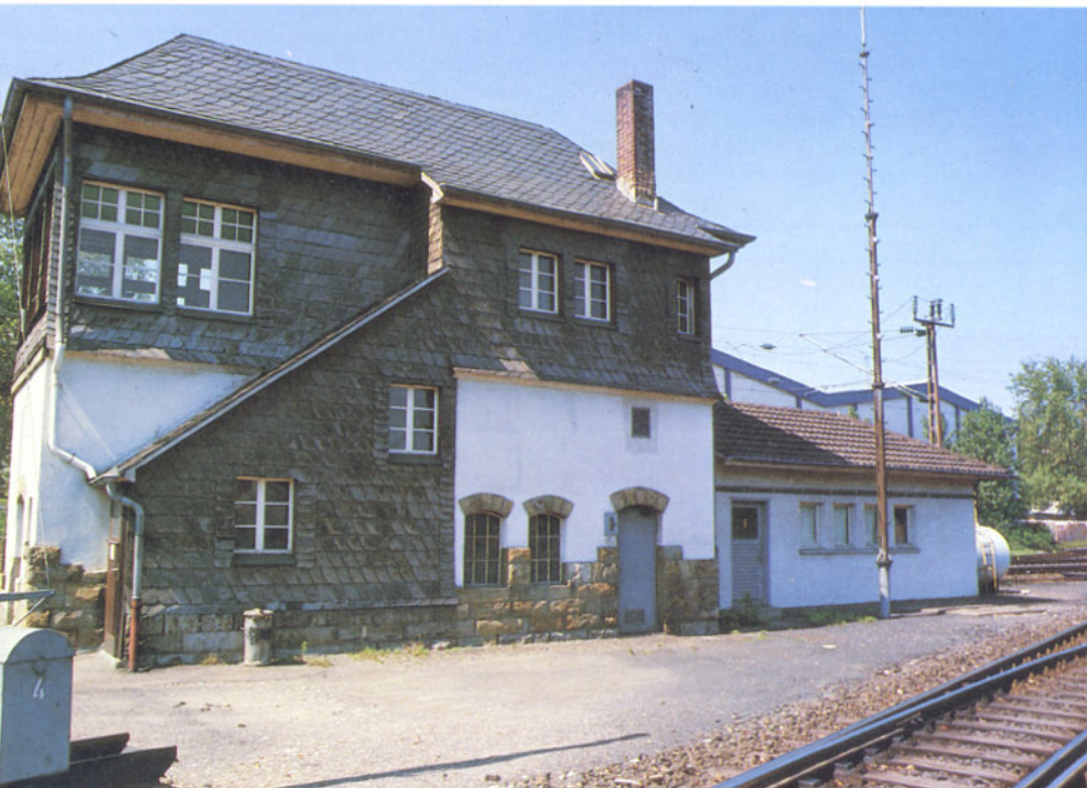
Bild 2: Das mechanische Stellwerk Bergisch Gladbach Gf befindet sich heute am Ende der Kursbuchstrecke 491 Neuss – Köln – Bergisch Gladbach.
