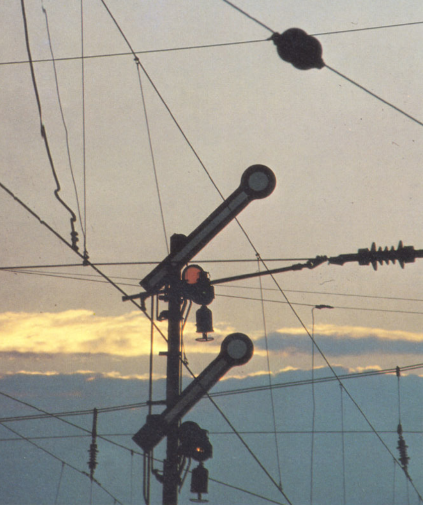
Bild 4: Die beiden Signalfügel zeigen nach rechts aufwärts – Signal Hp 2 (Langsamfahrt).
