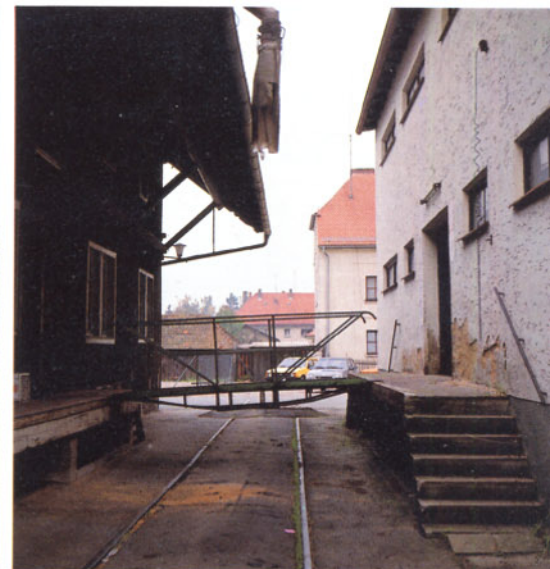
Bild 12: Ein schmaler Steg überbrückt das Gleis zwischen den Rampen der Lagerhäuser, wenn kein Verladebetrieb stattfindet.
