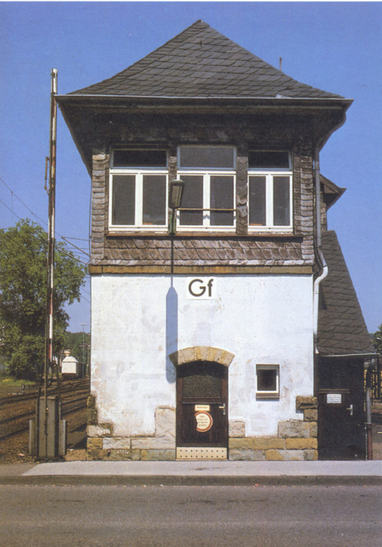
Bild 4: Blick auf die Straßenfront des Stellwerkgebäudes.
