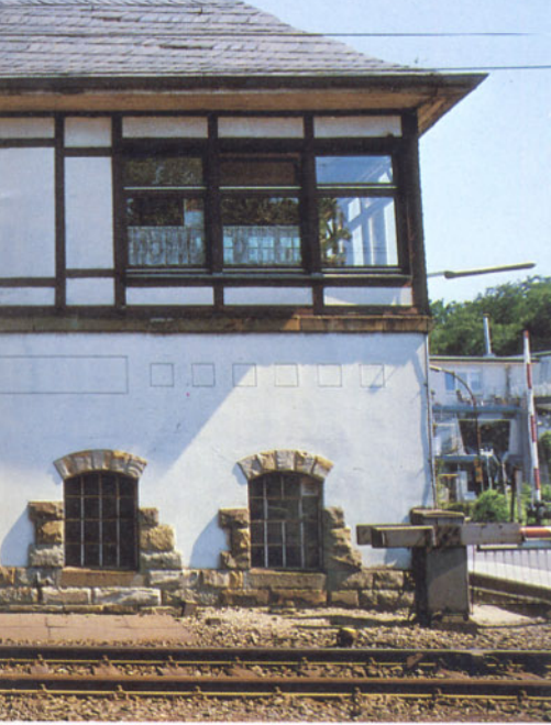
großen Fenster wurden erst vor kurzem erneuert.
