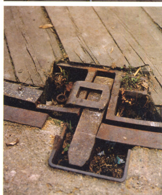
Bild 13: Die hölzerne Abdeckung der Drehscheibengrube in Neunburg vorm Wald ist mit Metallbeschlägen verstärkt.
