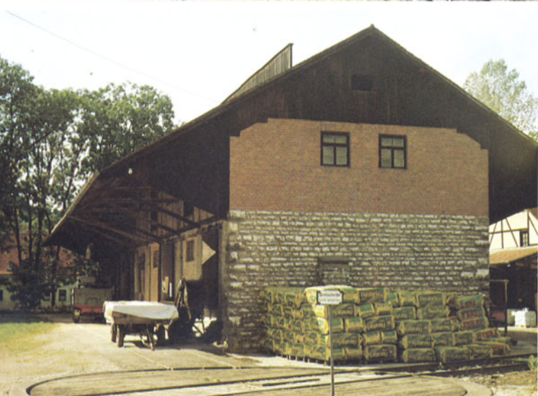
Bild 5: Mit Hilfe der Wagendrehscheibe können die Waggons direkt an die Laderampe dieses Güterschuppens rangiert werden.
