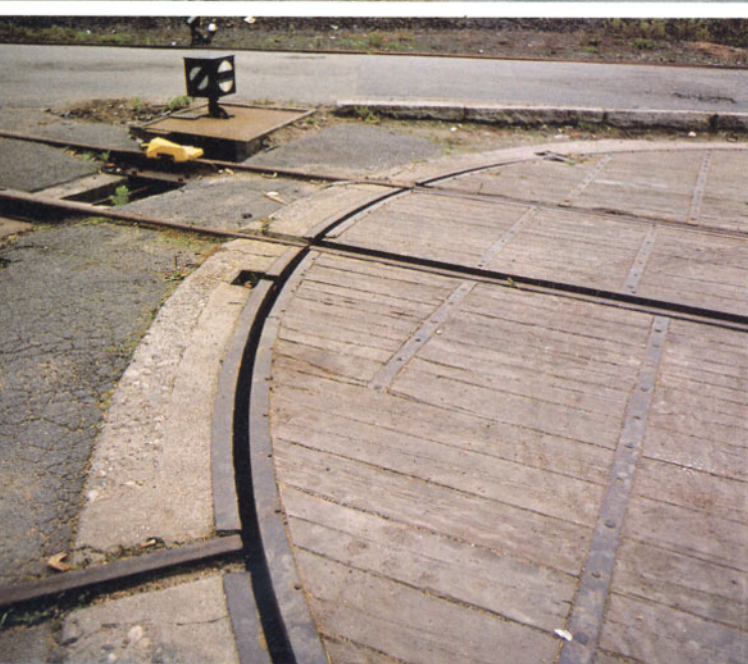
Bild 13: Die hölzerne Abdeckung der Drehscheibengrube in Neunburg vorm Wald ist mit Metallbeschlägen verstärkt.
