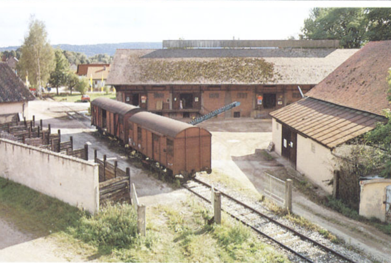
Bild 4: ...das zu einem Gewerbegebiet mit mehreren Lagerhäusern führt.
