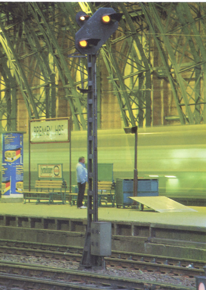
Bild 6: Ein Lichtvorsignal in der Bahnsteighalle des Bremer Hauptbahnhofs.
