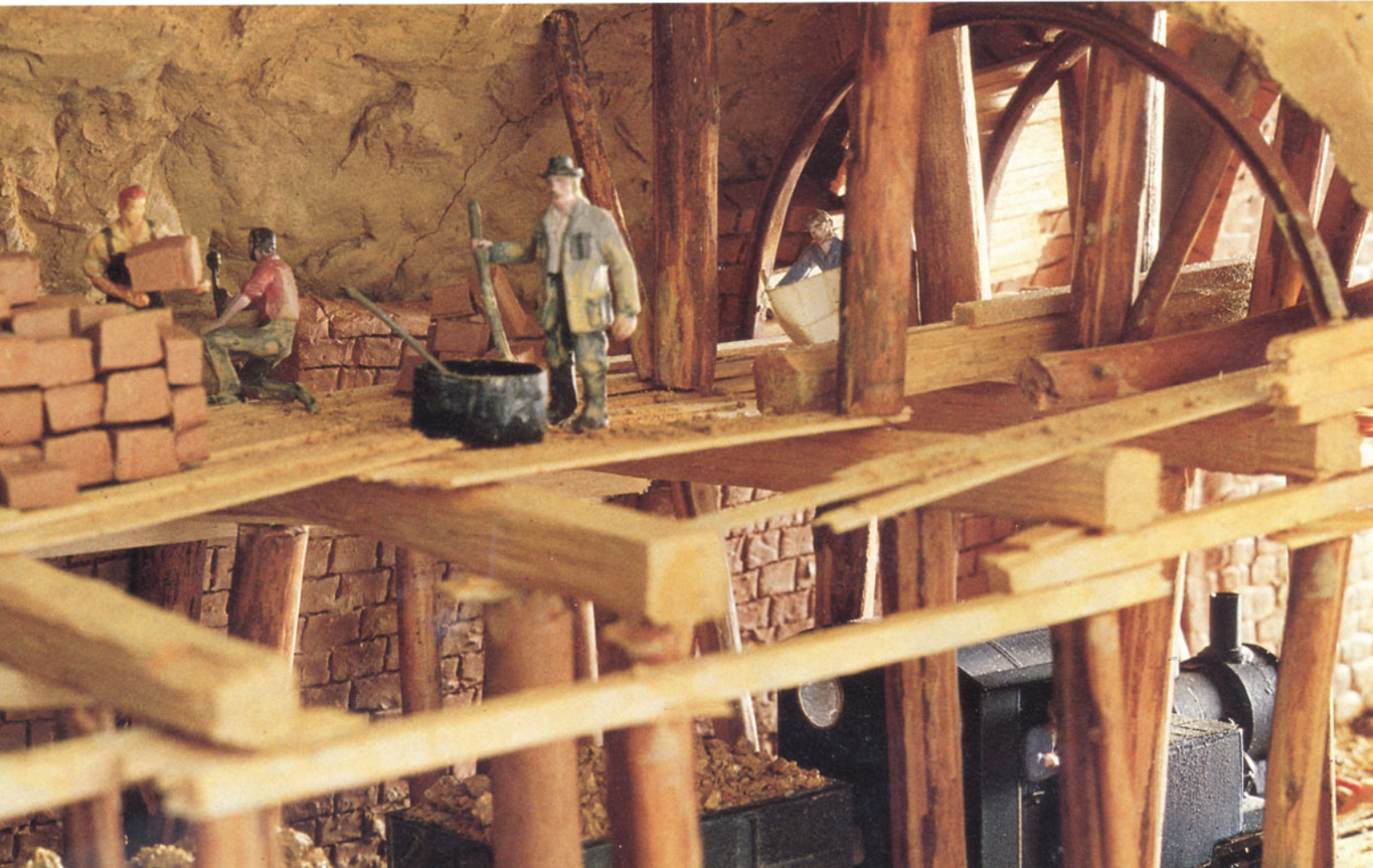
Bild 12: Inzwischen nimmt die Tunnelvermuerung Gestalt an.
