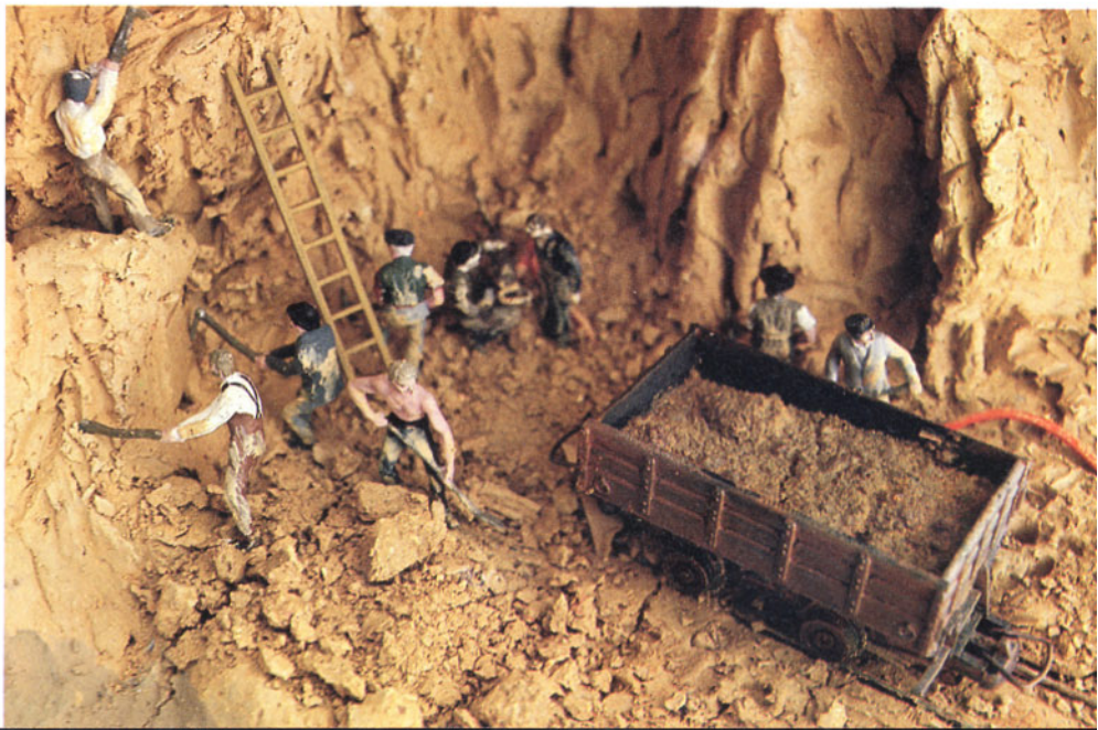
Bild 5: Kurz vor dem Durchstich: Eine beladene Feldbahn-Lore steht zur Abholung durch die Tunnellok bereit.
