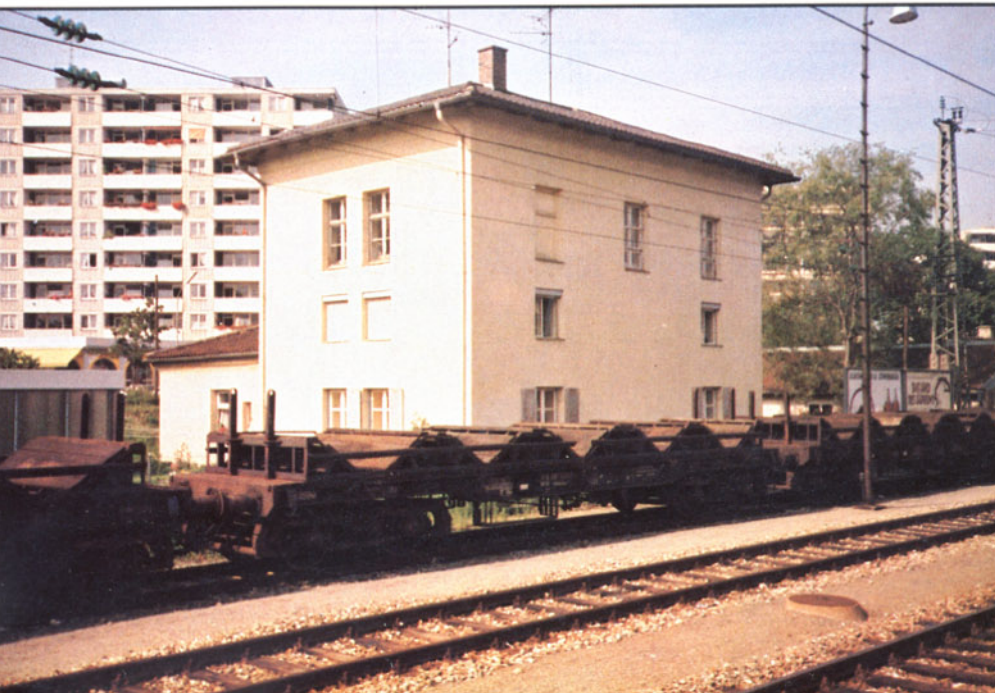
Bild 7: Das ehemalige Wasserhaus der Station Markt Schwaben (Strecke München – Simbach), von der Bahnsteigseite gesehen.
