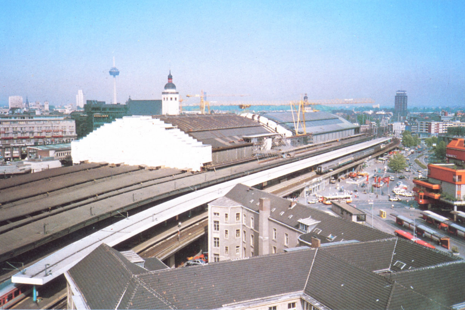
Bild 6: Der Blick auf die gesamte Halle während der Sanierungsarbeiten, nachdem etwa die Hälfte bereits fertiggestellt ist.
