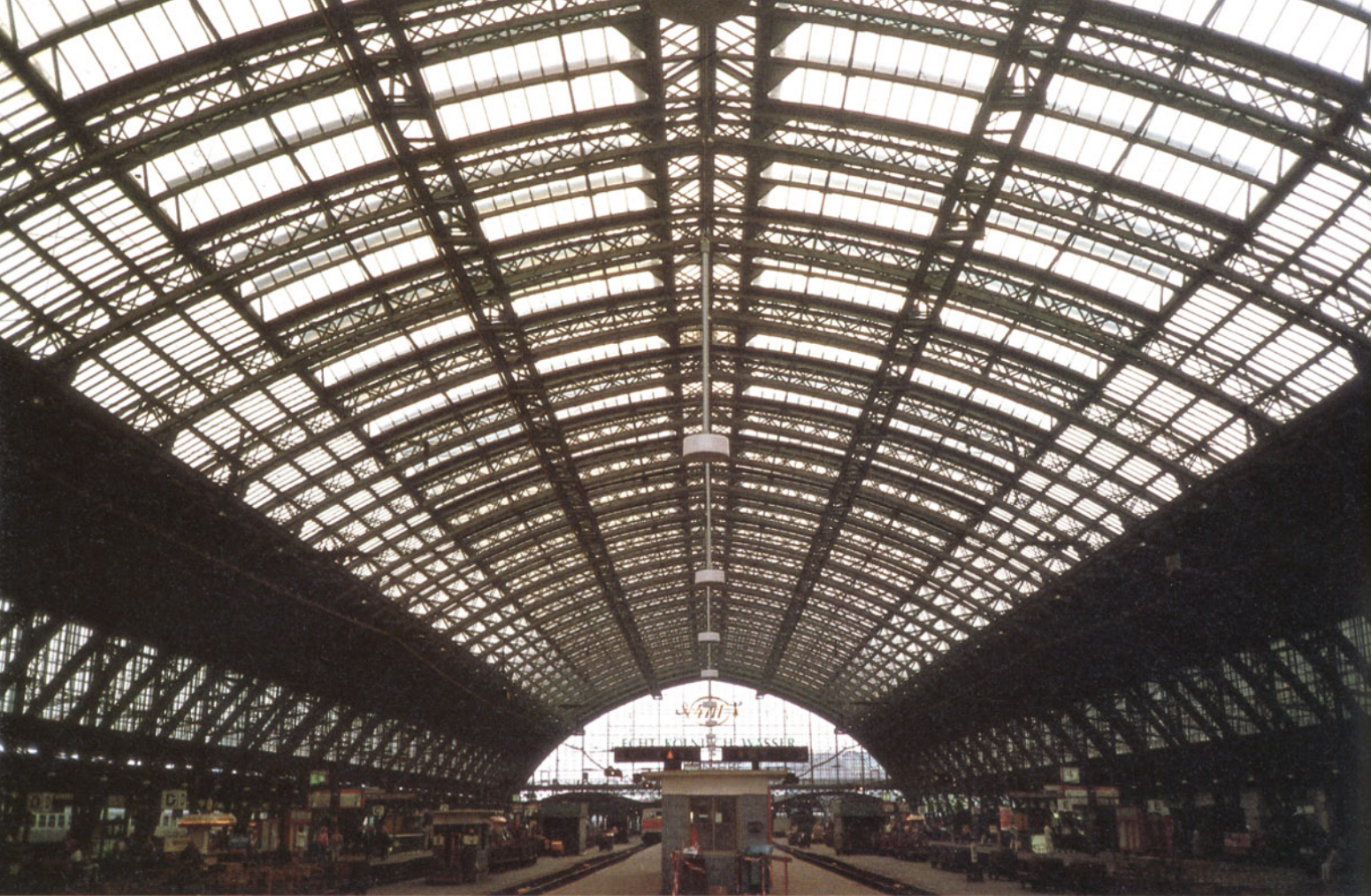
Bild 1: Wie neu wirkt die Halle nach beendeter Sanierung. Durch die neue Eindeckung kommt die filigrane Dachkonstruktion wieder richtig zur Geltung.
