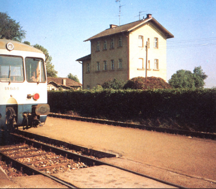
Bild 11: Das Wasserhaus in Schwabmünchen vom Bahnsteig aus gesehen ...
