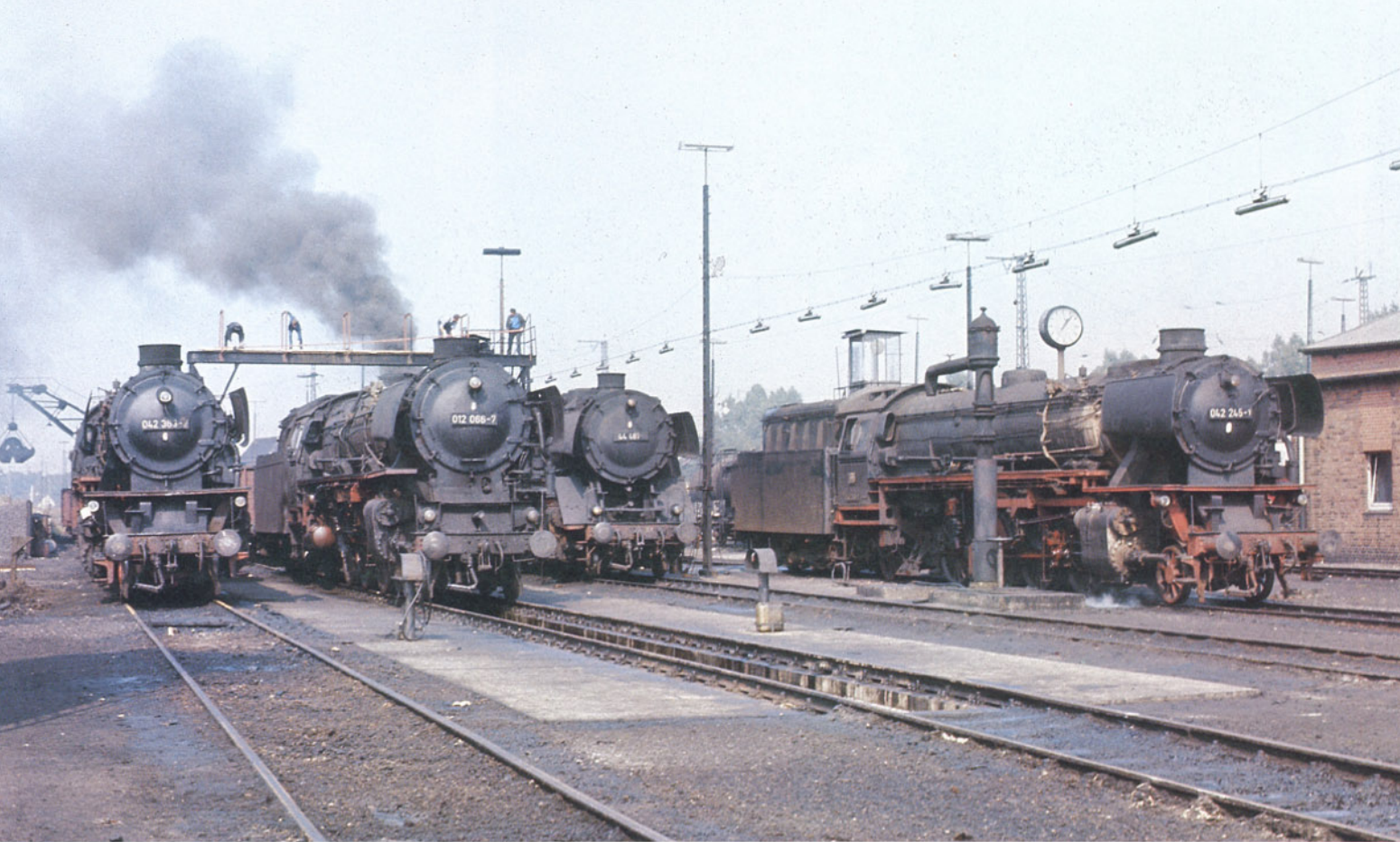
Bild 14: Reger Betrieb herrschte am 17.09.1973 auf den Lokbehandlungsgleisen des Bw Rheine (v.l.n.r.): 042 363, 012 066, 044 481 und 042 245.
