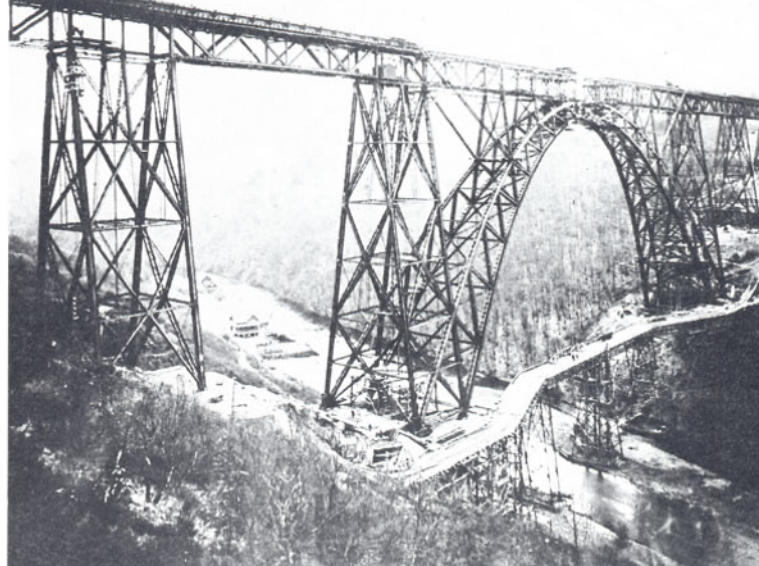
Bild 10: Schrägsicht von der Solinger Bergseite mit Blick auf die Arbeits- und Montagebrücke (aufgenommen am 01.03.1897). Foto: M.A.N.-Werkfoto
