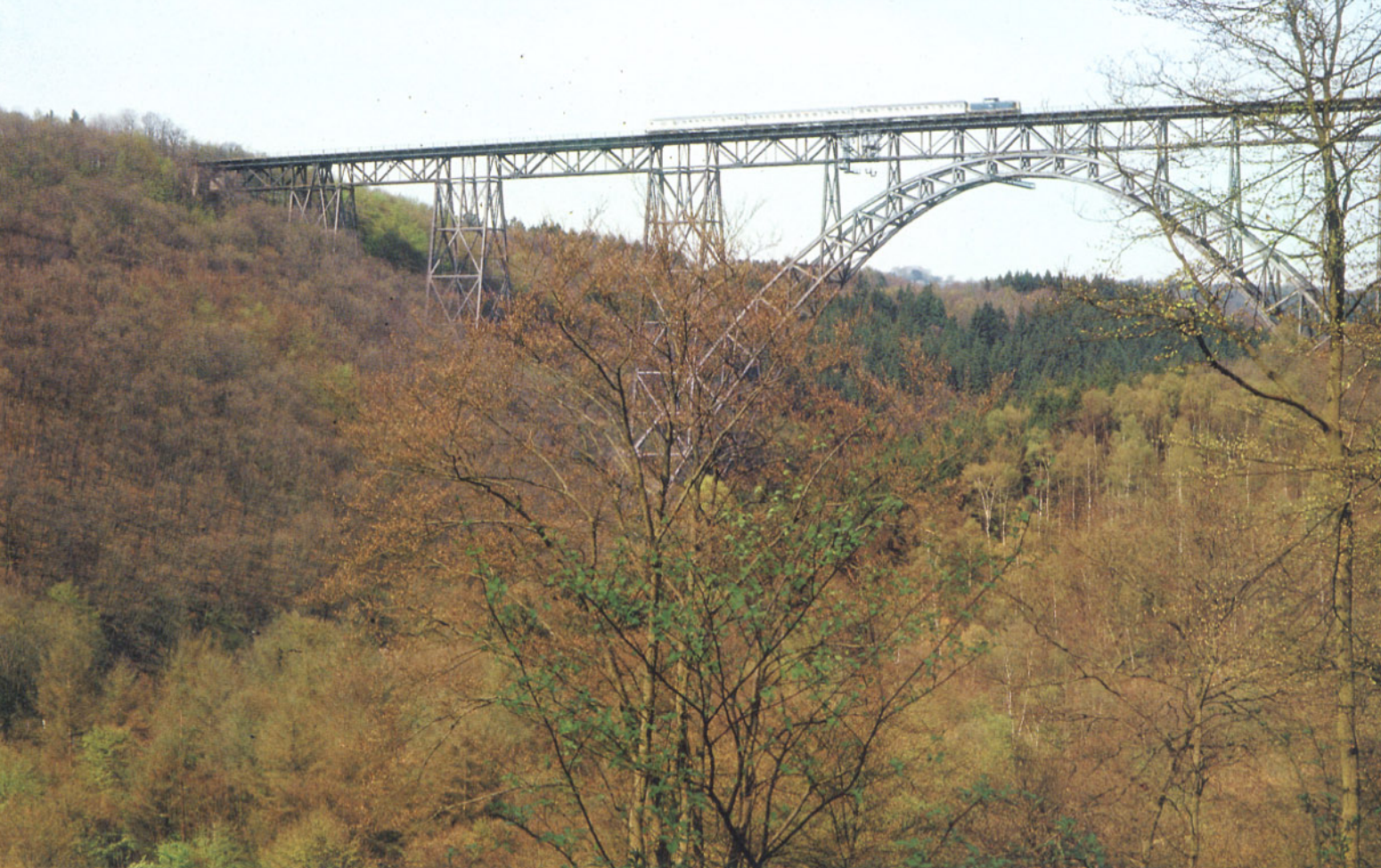
Bild 4: Der N 5262 (Solingen-Ohligs – Wuppertal-Vohwinkel) fährt am 25.04.1987 bergwärts über die Müngstener Brücke nach Remscheid. Es führt eine Lokomotive der Baureihe 212 des Bw Wuppertal. Foto: W. Reinshagen
