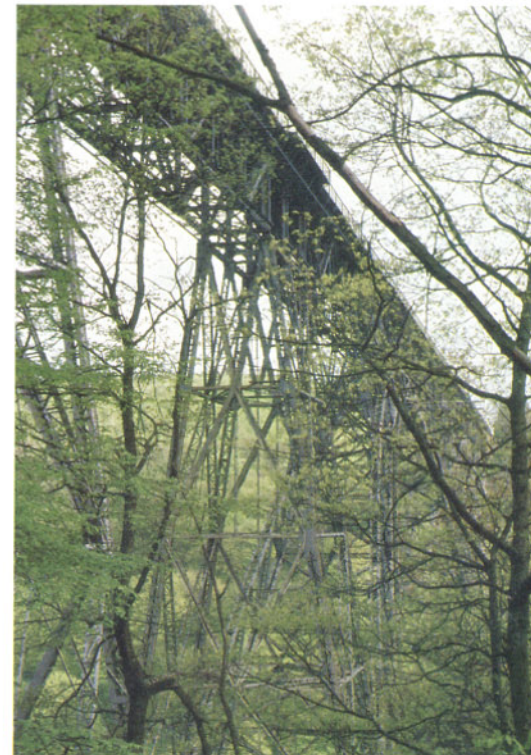
Bild 5: Brückenzug der Müngstener Brücke gegen Osten (Richtung Remscheid) am 06.05.1987. Foto: F. Bachem
