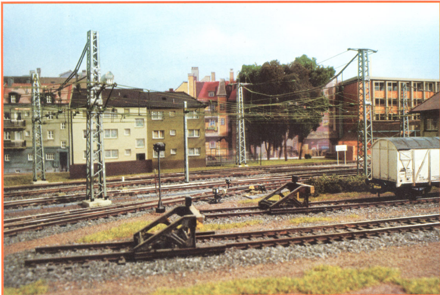
Bild 23: Die Elektrifizierungsarbeiten sind hier schon abgeschlossen worden. Gut zu erkennen sind die Quertragwerke, die mehrgleisige Streckenabschnitte überspannen.
