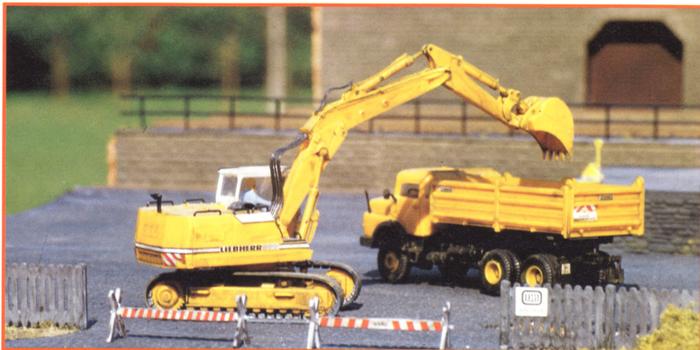
Bild 14: Zu Kanalarbeiten auf dem Vorplatz der großen Güterhalle ist ein Liebherr Raupenbagger A 922 eingesetzt. Der Aushub muß wegen des regen Lkw-Verkehrs abtransportiert werden.
