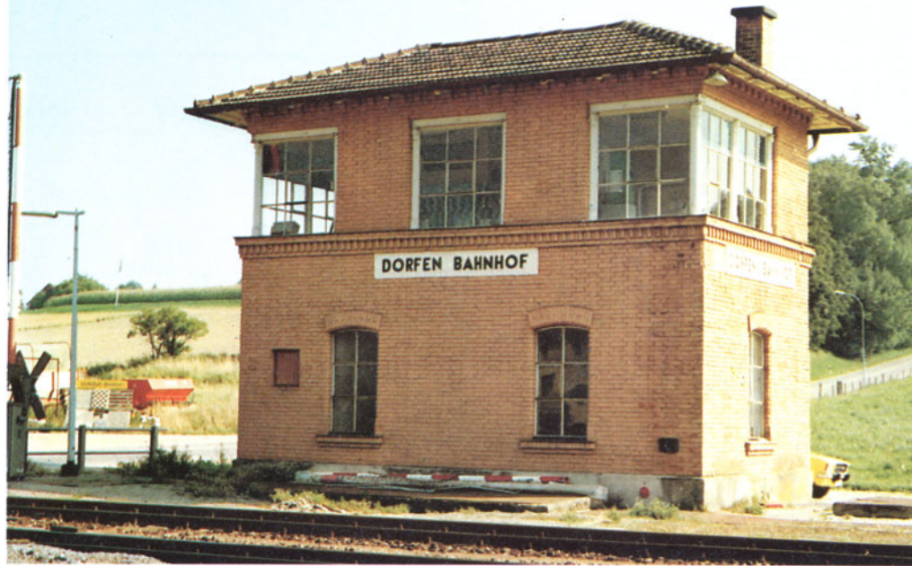
Bild 3: "Der" bayerische Stellwerksturm! Station Dorfен an der Strecke München – Mühldorf. In durchaus gepflegtem Zustand wurde er im September 1979 aufgenommen. Vor dem Fundament kann man die mit Riffelblech abgedeckte Betonwanne für die Umlenkvorrichtung erkennen.
