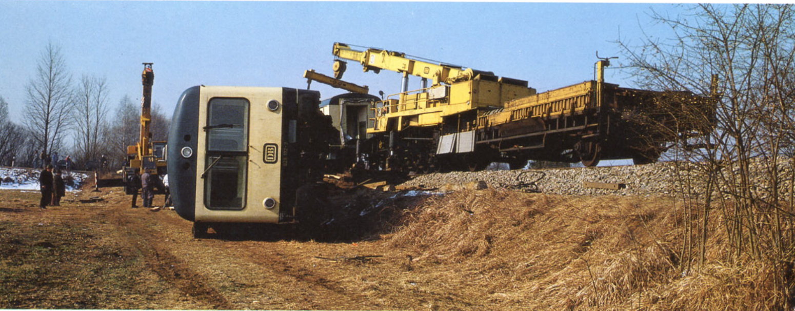
Bild 4: Am 14.03.1987 fuhren zwei Hilfszüge mit jeweils einem Schienenkran sowie ein Autokran zur Bergung des Triebzuges an die Unfallstelle.
