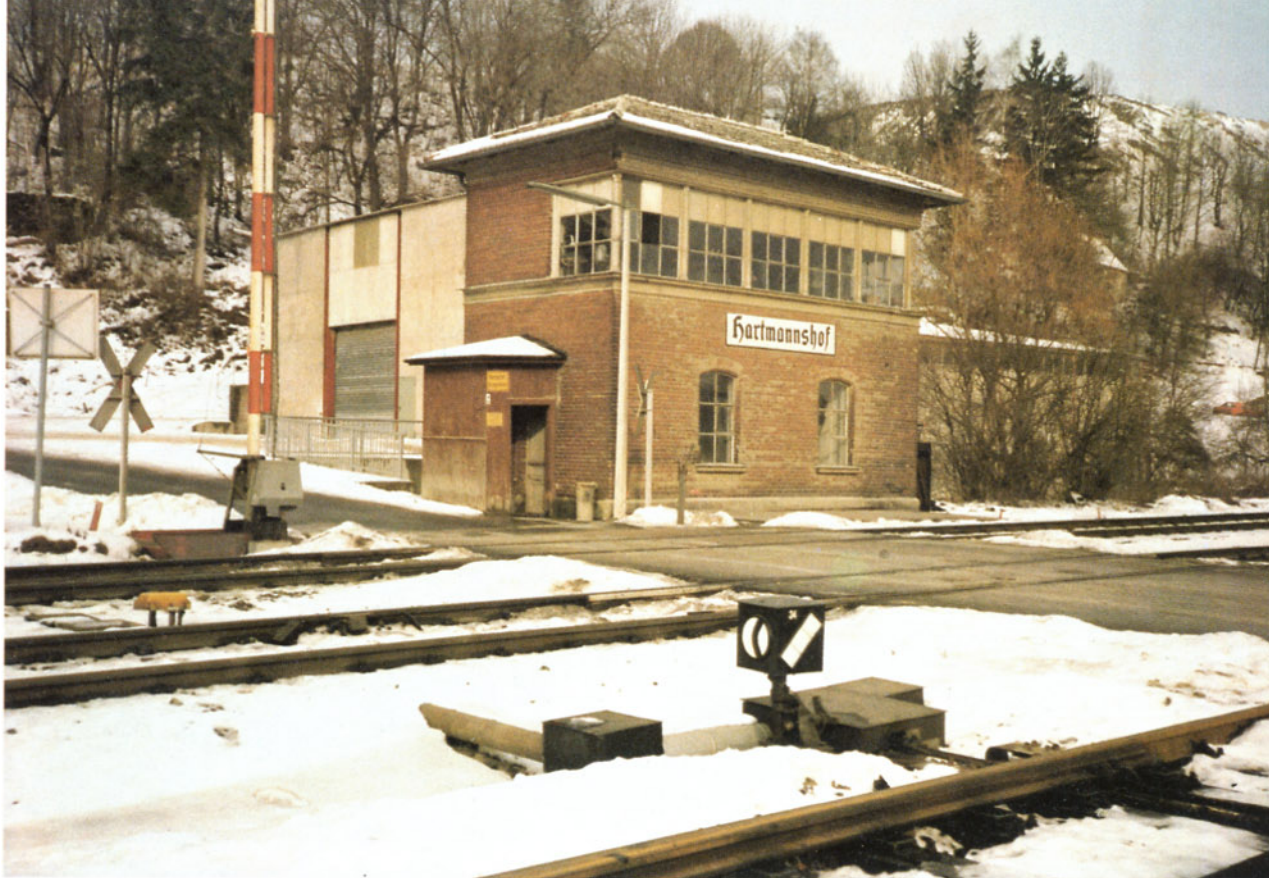
Bild 14: Das ist das "andere" Stellwerk von Hartmannshof (Ostseite). Auf den ersten Blick sieht es anders aus, erweist sich bei genauem Hinsehen aber dann doch als "Grundtyp". Backsteinbauart, durchgehende Fensterfront, Gurtgesimse aus Sandstein, anstatt Ziegel.
