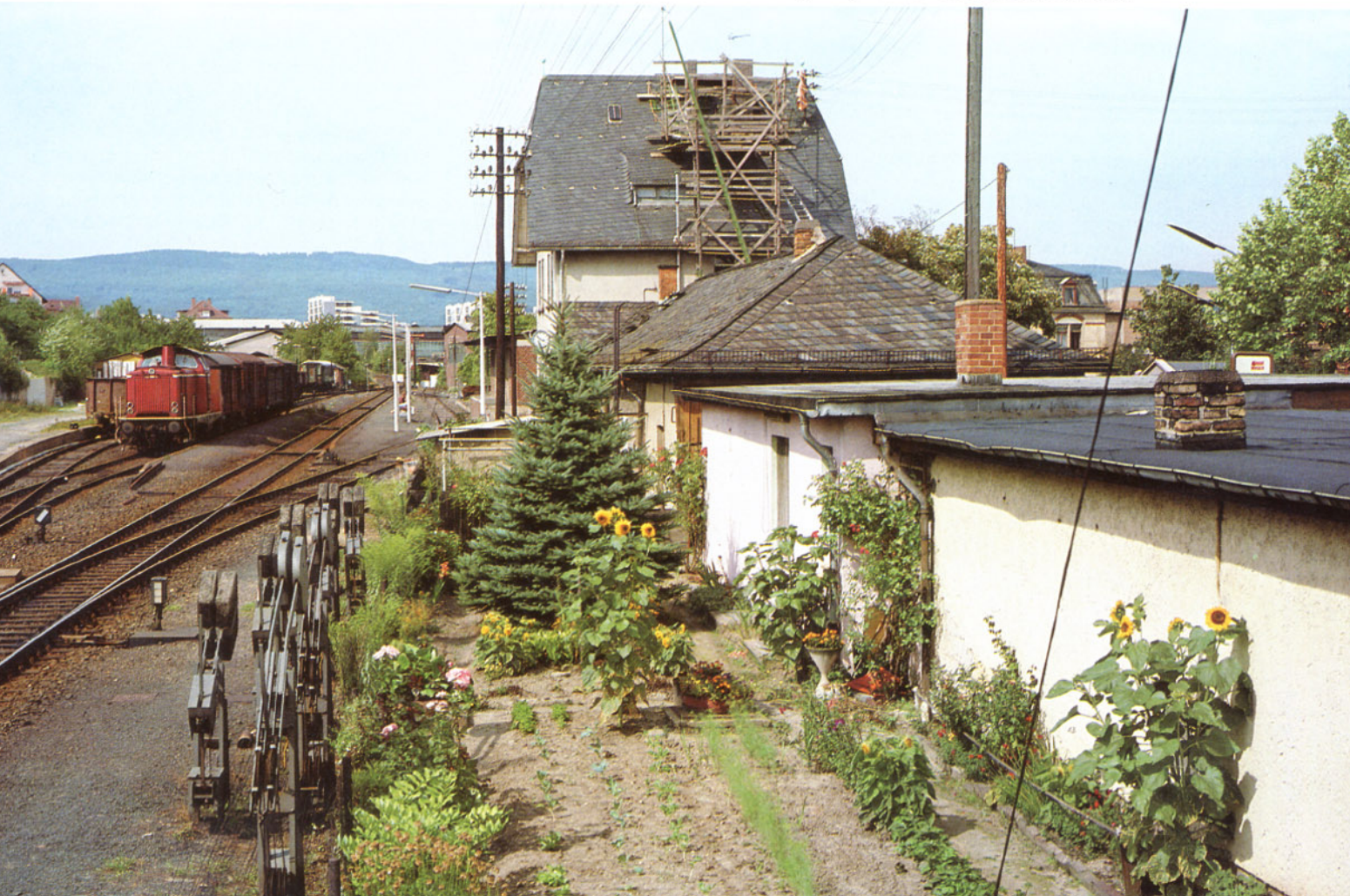
Bild 2: Blick vom Stellwerk auf das Empfangsgebäude in Wiesbaden-Dotzheim. Die 212 056 steht mit dem Übergabezug 67341 am 13.08.1982 zur Abfahrt bereit.
