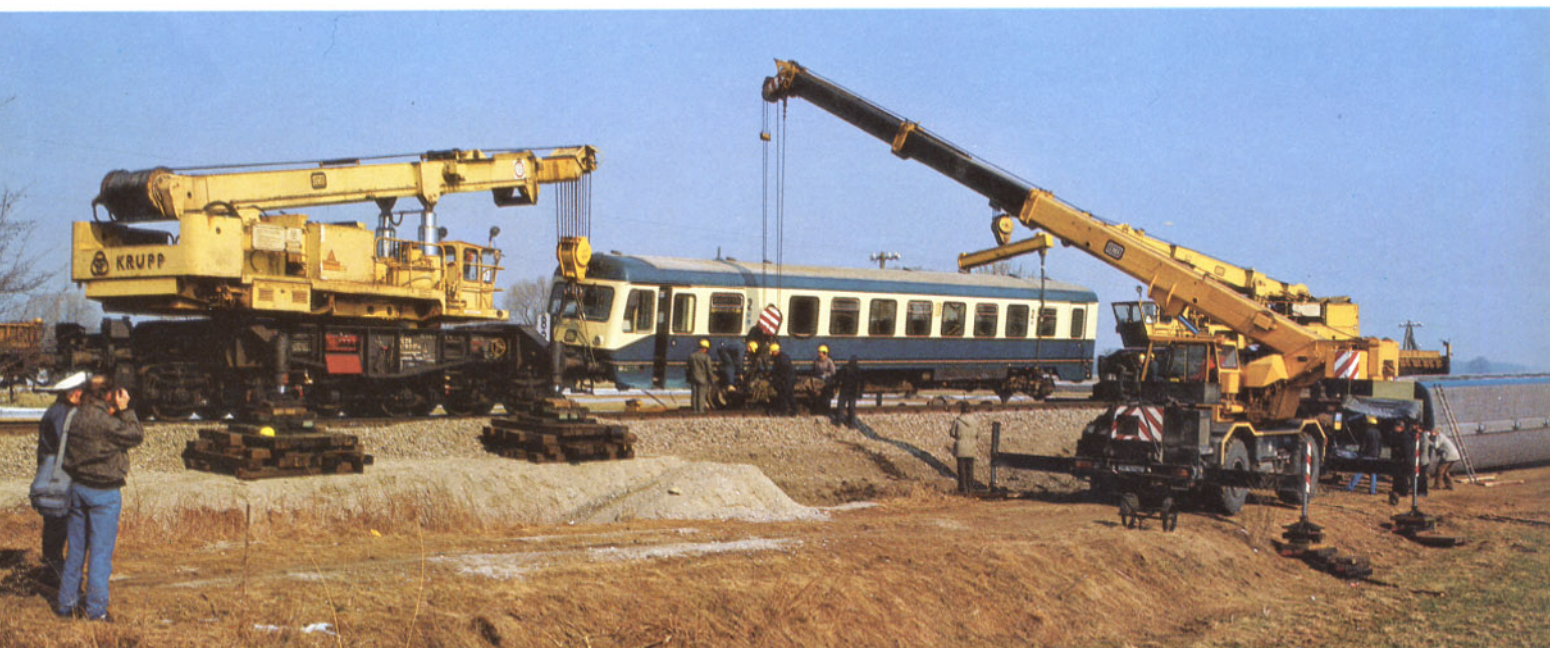
Bild 7: Nachdem der 628 102 von den beiden Schienenkränen seitlich über das Gleis hinaus verschwenkt wurde, erfolgte mit Hilfe des Autokrans das Aufgleisen seines Drehgestells.
