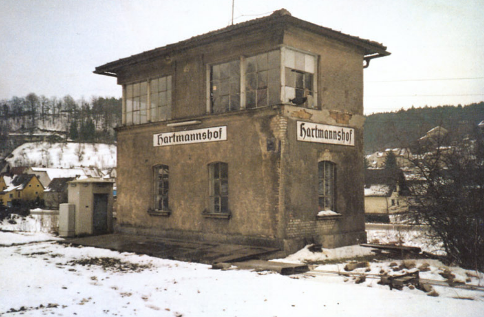
Bild 9: Aus den ersten Jahren unseres Jahrhunderts stammt das westliche Stellwerk von Hartmannshof. Es war von Anfang an verputzt, was die verwendete Ziegelsorte unschwer an den Stellen erkennen läßt, wo der Putz abfällt.
