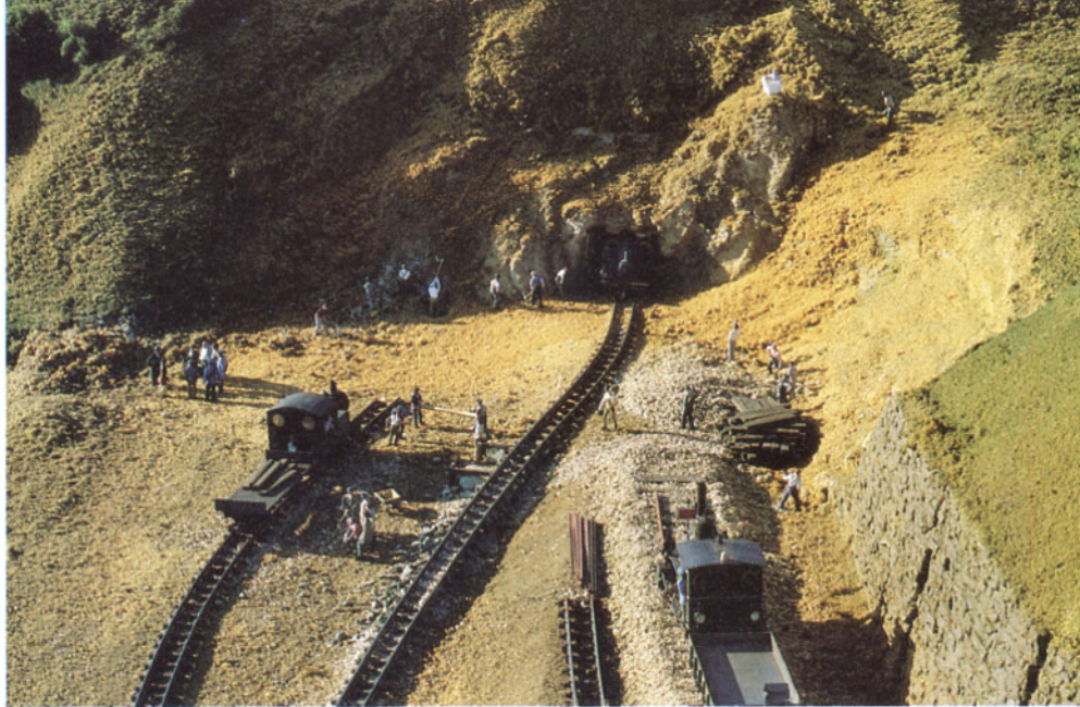
Bild 20: Blick auf den Tunnelstollen, der bereits so groß ist, daß Bauzuglokomotiven einfahren können.
