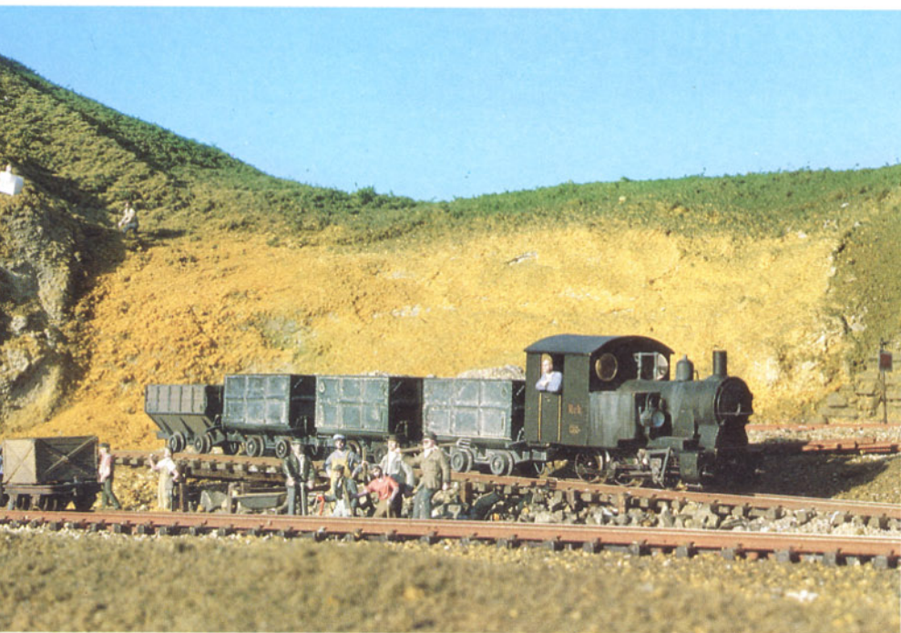
Bild 21: Gerade kam wieder ein Bauzug mit Abraum aus dem Tunnel und wartet jetzt auf das Entladen.
