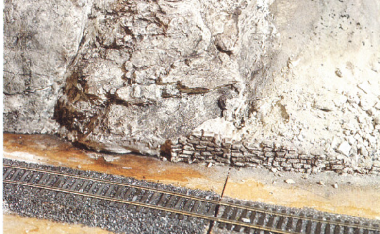
Bild 8: ... und halten dadurch eventuelle Erdrutsche vom Bahndamm fern.
