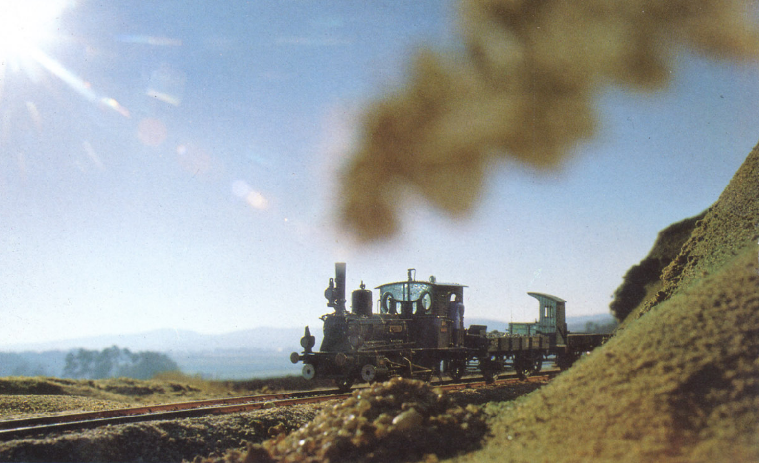
Bild 13: Eine bayerische D VI sorgt auf den bereits verlegten Lokalbahngleisen für den Materialnachschub zur Tunnelbaustelle.
