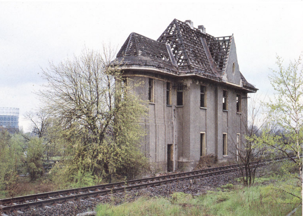
Bild 15: In einem baufälligen Zustand präsentierte sich im Mai 1985 das frühere Stellwerk Tpa am Bahnhof Papestraße. Foto: J. Horstkamp
