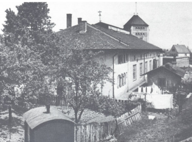
Bild 7: Die Rückseite des Lokschuppens mit dem angebauten Wohngebäude (28.05.1940). Foto: Sammlung Öhm
