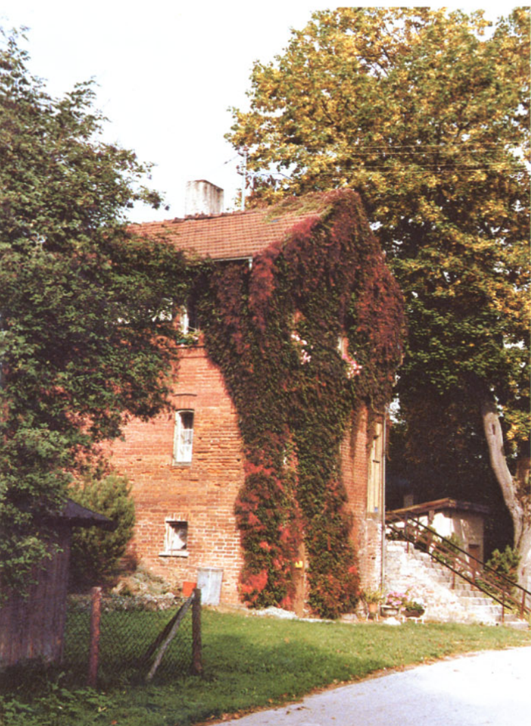
Bild 4: Die Straßenansicht des Gebäudes. Von dieser Seite wirkt es zweistöckig.
