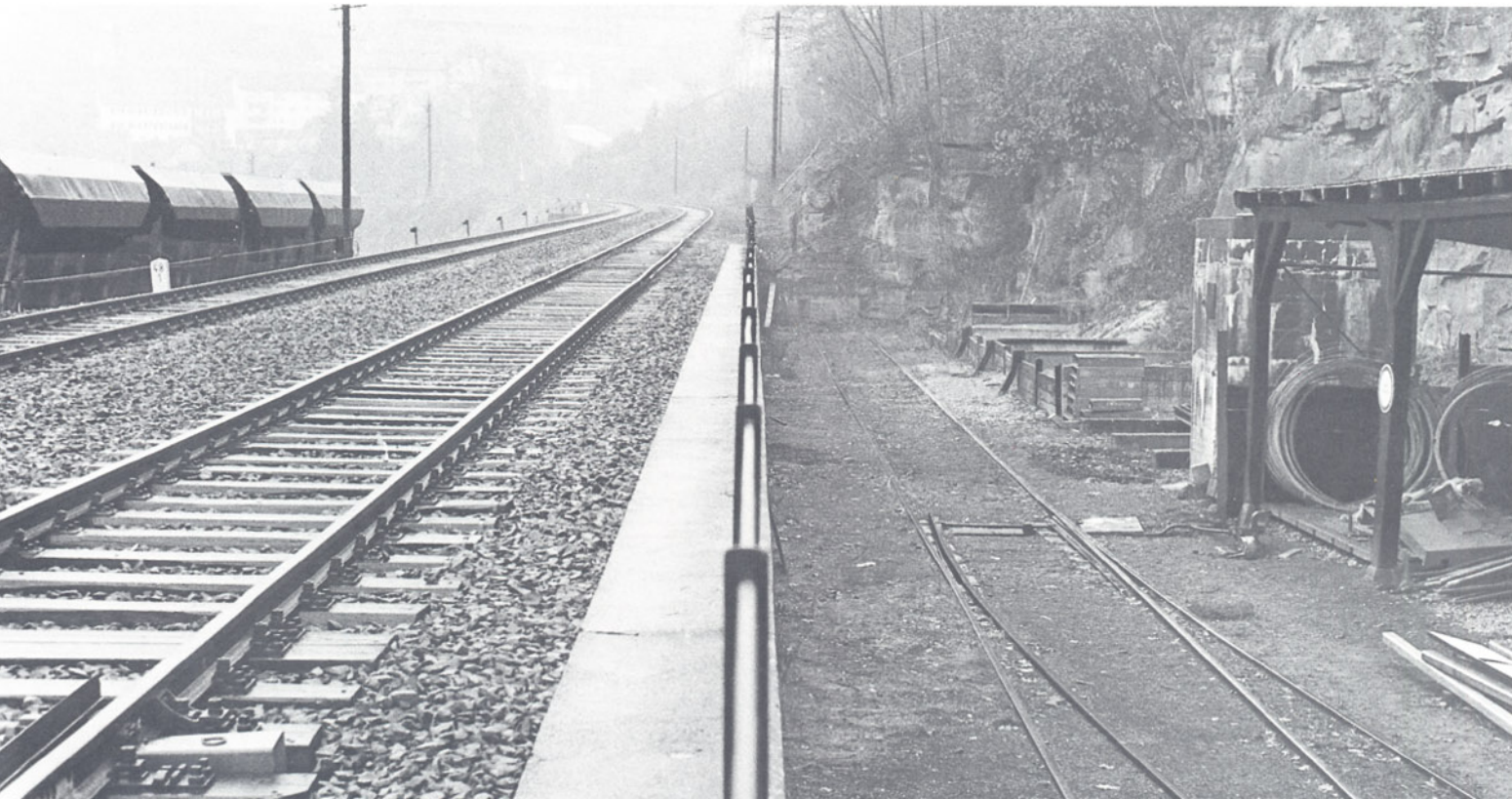
Bild 9: Gleisstummel beim kleinen Lokschuppen, daneben die Rampe der Strecke nach Althengstett.
