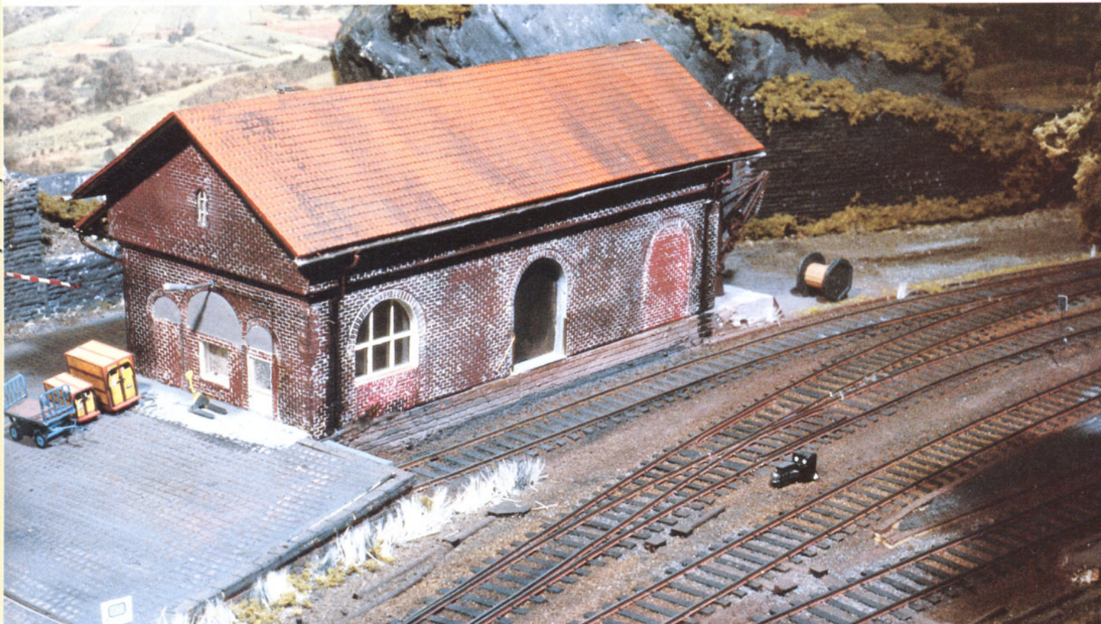
Bild 5: Hier die gegenüberliegende Seite des Güterschuppens mit Ladegleis.
