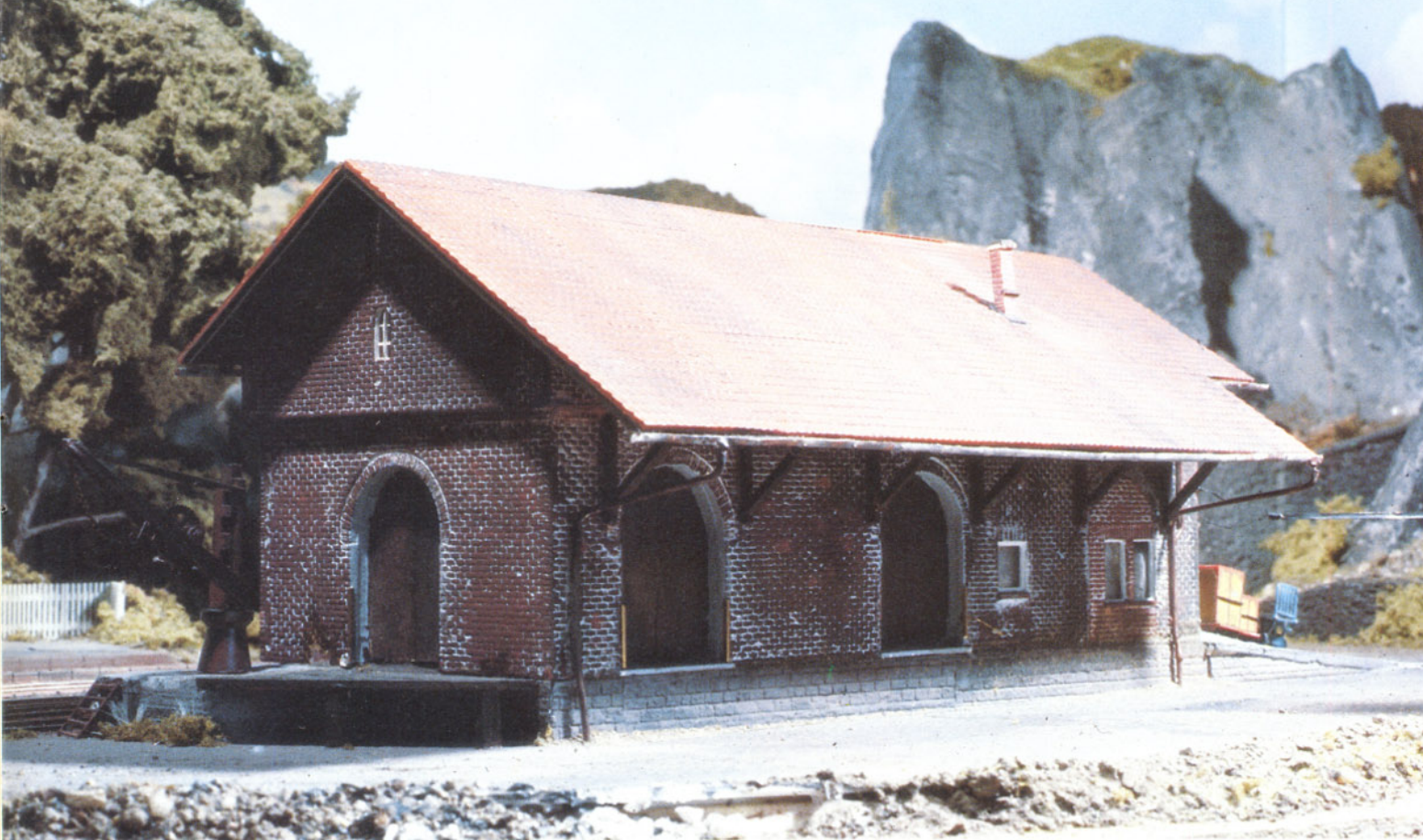
Bild 4: Ansicht von der Straßenseite auf den Güterschuppen.
