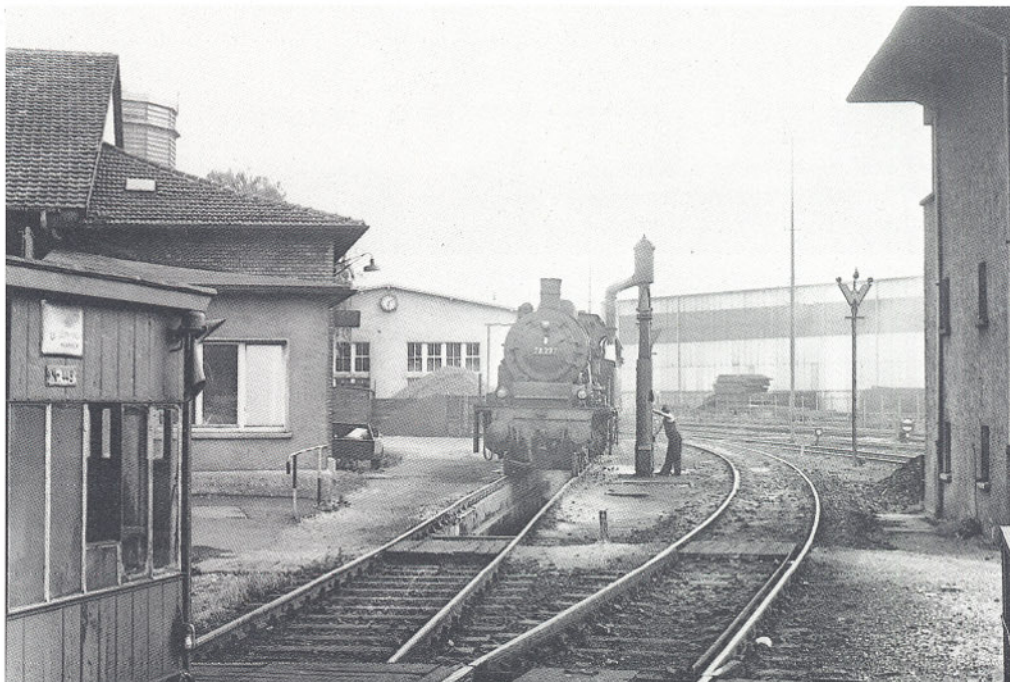
Bild 18: Eine zweite Schlackengrube befand sich am Zufahrtsgleis zur Drehscheibe, dort stand auch ein Wasserkran (07.07.1968). Foto: H. Stemmler
