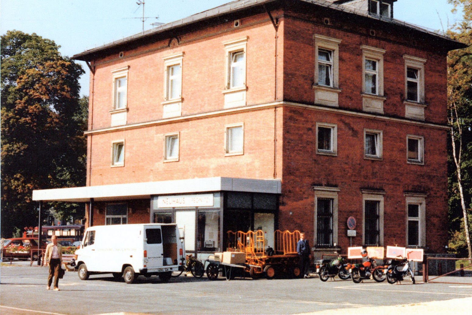
Bild 3: In Neuhaus (Pegnitz) blieb der "Würfel" sogar unverputzt. Neue Fensterstöcke in den Wohnungen und der Abbruch eines seitlichen Anbaues sind die einzigen (äußeren) Veränderungen. Eine Besonderheit am "Würfel" stellt die Dachgaube dar.
