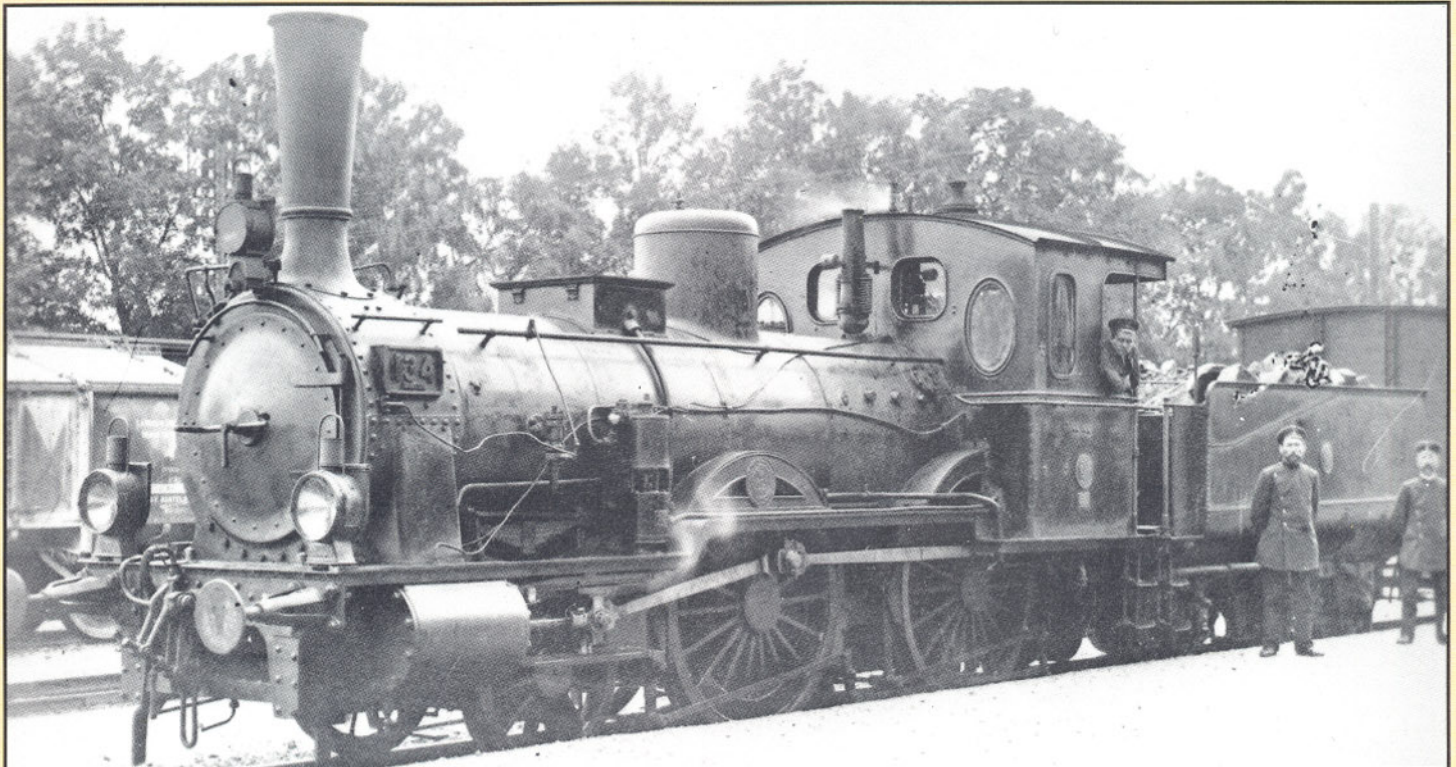
Bild 9: Diese 1B nach altem Musterblatt 15 lieferte Hanomag im Jahre 1878 mit der Fabrik-Nr. 1401 an die (staatliche) Westfälische Eisenbahn, die sie als Betriebsnummer 196 führte. Im Jahre 1880 erhielt sie bei der Direktion Hannover die Betriebsnummer 896, 1883 wurde sie in Hannover 438 und 1895 in Münster 134 umgezeichnet. Die 1906 der Gattung P 2 zugewiesene Maschine wurde 1908 ausgemustert. Foto: Sammlung Rauter
