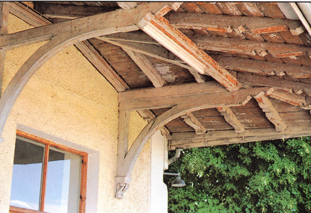
Bild 6: Das Bahnsteig-Vordach am Hauptgebäude war überall ziemlich einheitlich ausgeführt. Der Holzbalken-Stuhl (hier des Gebäudes in Schechen, Strecke Rosenheim – Mühldorf) ist deutlich erkennbar. Das Dach selbst ist entweder als Pult- oder als Walmdach ausgeführt.
