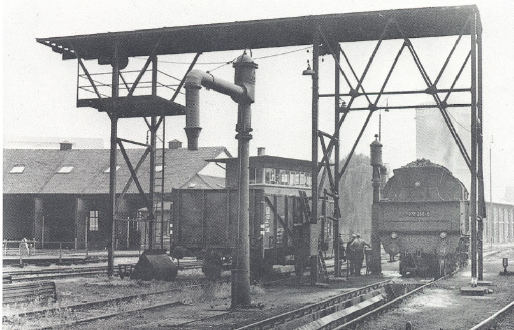
Bild 19: Der Bockkran des Bw Aalen; an der linken Stütze des Bockkrans ist eine Plattform zu erkennen, die über eine Leiter erreicht werden konnte (31.08.1970). Foto: H. Stemmler
