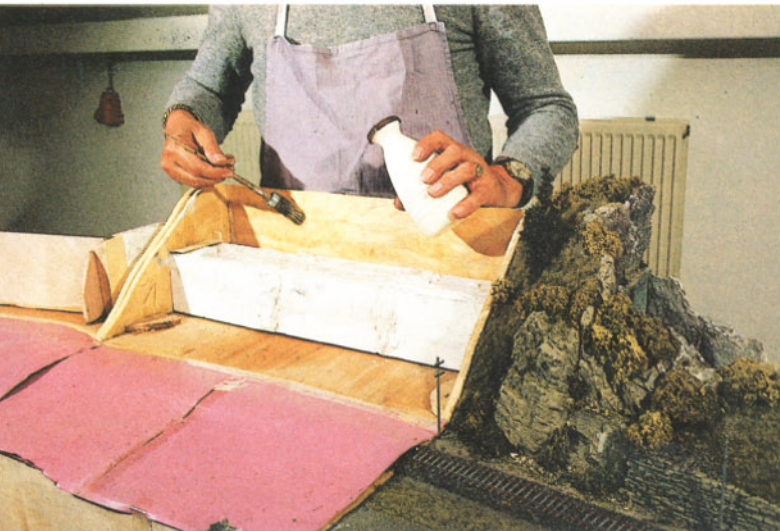
Bild 51: Nun werden alle Flächen (siehe auch Haupttext) gut mit Wasser benetzt.
