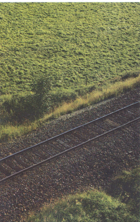
▼ Bild 18: Um Geländeunebenheiten auszugleichen, ist hier das Schotterbett höher ausgeführt.
