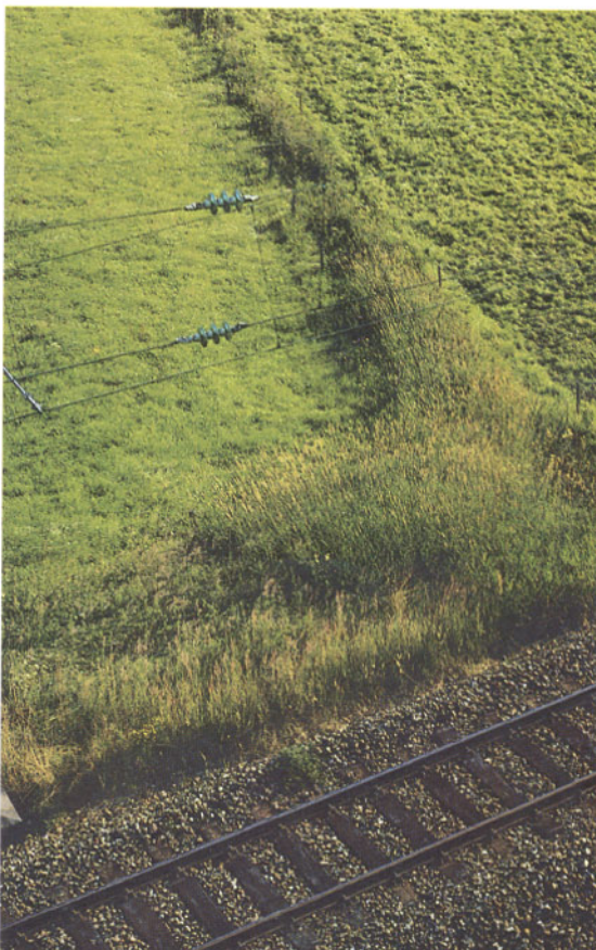
Bild 16: Schotter beim Holzschwellengleis mit Holzbohlenübergang.
