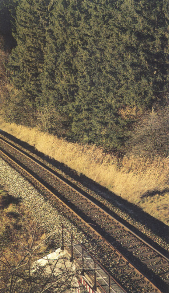
▲ Bild 17: Hier ist das Gleis auf erhöhtem Bahndamm mit Grasbewuchs verlegt. Auf kleinen Brücken wie im Vordergrund ist die Beschotterung durchgehend.
