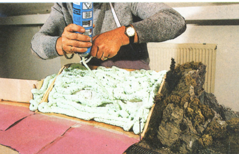
Bild 53: Das Gleis wurde vorher mit Papier abgedeckt, nicht zuviel Schaum auftragen...
