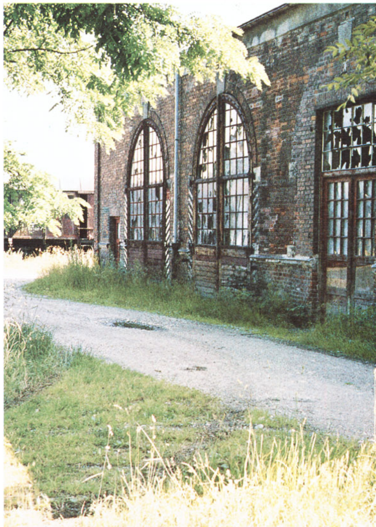
Bild 16 (oben): Ein Blick auf die Bekohlungsanlagen des Bw Simbach im Jahre 1956. Der Kohlebansen neben den vier abgestellten Dampflokomotiven in der Bildmitte ist zurückgebaut worden. Links daneben ist der Bockkran und die Schlackengrube zu erkennen. Freigabe: Regierung v. Obb. G 4/182. Foto: Bertram-Luftbild, München-Riem
