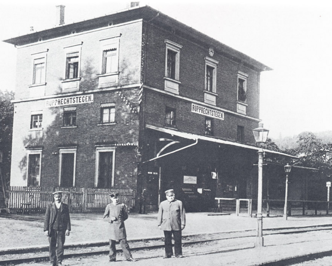
◀ Bild 6: Ein gleichartiges Haupthaus wie in Bild 1: Ruppertshegen in der Hersbrucker Schweiz (Strecke Nürnberg – Schnabelwaid). Das Stell- werk befindet sich im Freien vor dem Fahr- dienstleiterbüro. Dieses E.G. steht heute noch in nur wenig verändertem Zustand.
