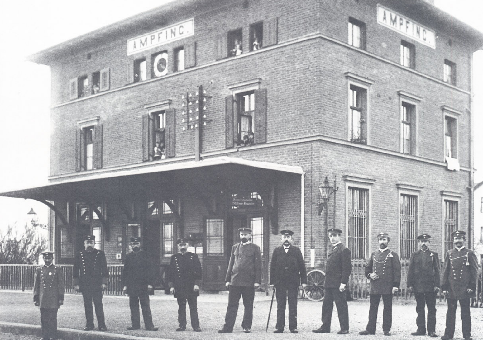
Bild 3: Der "Würfel" im Süden Bayerns: der Bahnhof Ampfing, an der Strecke München – Mühldorf, ist ein Ziegelbau, ganz nach Art und Maß unseres Paradetyps. Ursprünglich nur mit einer Dienstwohnung im 1. Stock (hohe Fenster) für den Herrn Expeditoer ausgestattet, wurden später weitere Wohnungen aufgestockt. Interessant die Teilung der dazugehörigen Fenster.
