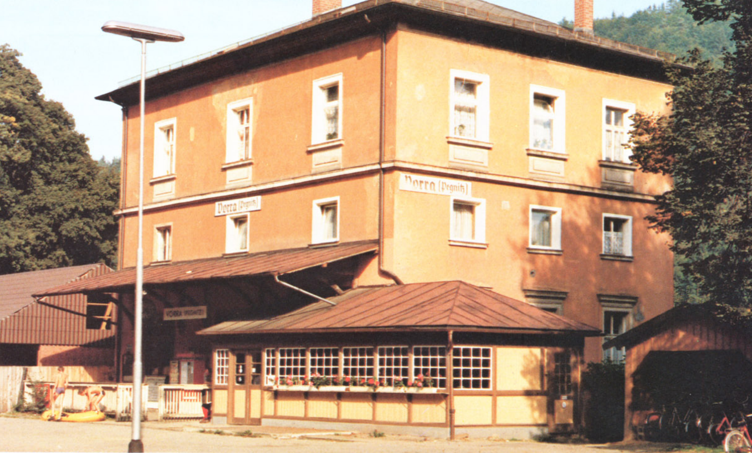
Bild 9: Das Stationsgebäude in Vorra (Pegnitz) im Jahre 1981. Auch hier wieder der Grundtyp der K.Bay.Sts.B., nur mittlerweile schön verputzt und angestrichen. Das Stellwerk ist in einer Holzbude untergebracht.
